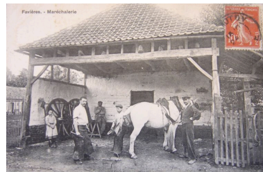
Vue de la maréchalerie rue des Forges au début du 20e siècle. Phot. Inès Guérin IVR22_20078005792NUCAB
