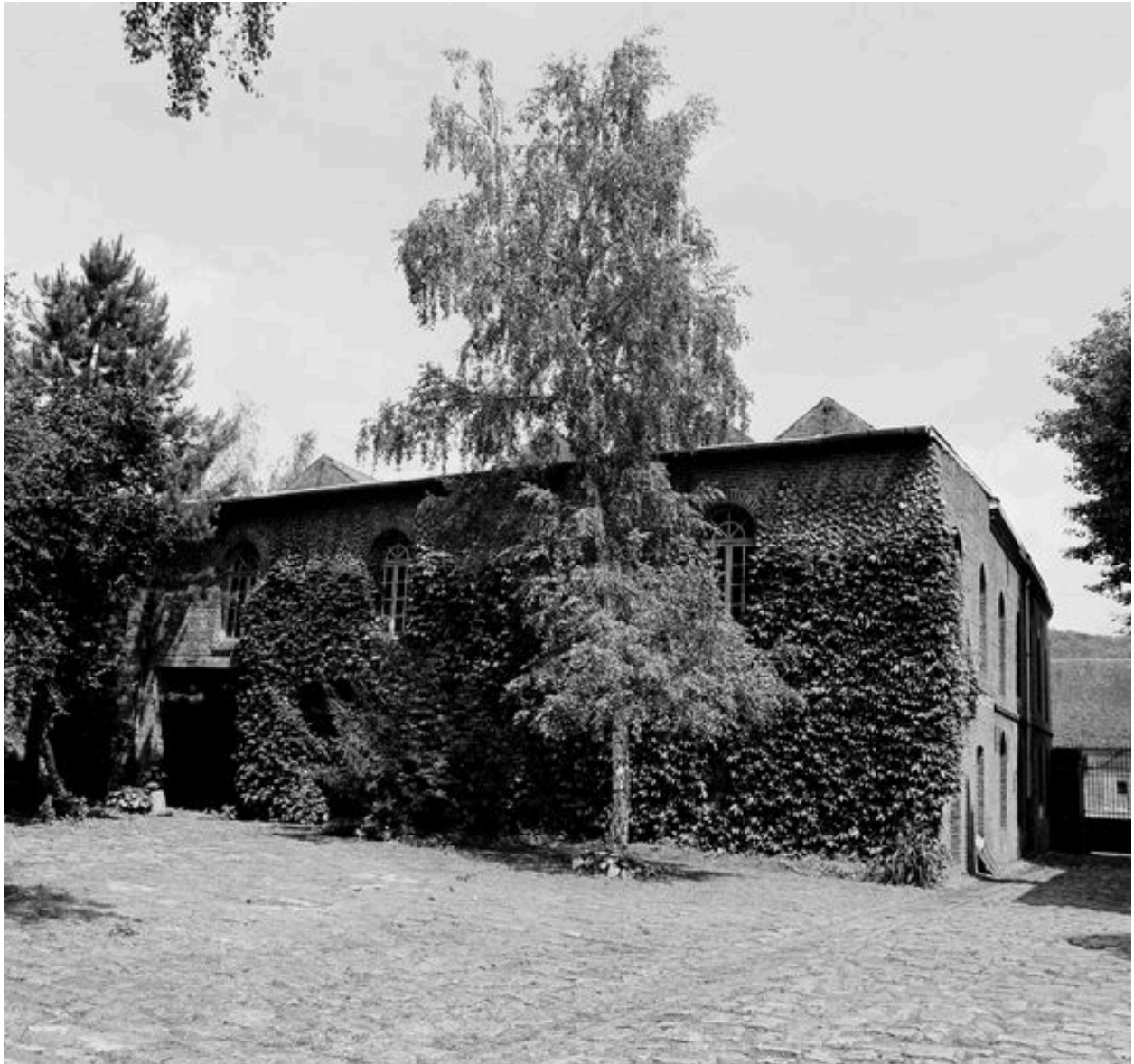
Atelier de fabrication : façade postérieure.
