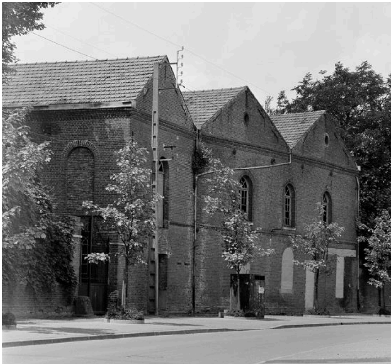
Atelier de fabrication : façade antérieure.
