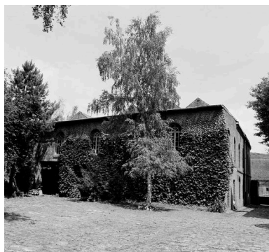
Atelier de fabrication : façade postérieure. Phot. Patrick Glotain
