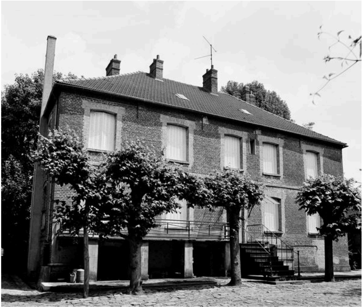
Logement patronal : façade antérieure.
