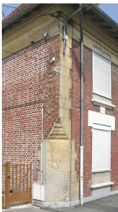
Détail d'un enduit imitant un appareillage en pierre de taille, sur un des deux pavillons d'entrée. Phot. Frédéric Pillet IVR22_20070205103NUCA
