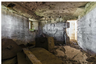
Vue intérieure en enfilade vers le sud Phot. Jean-Marc Ramette IVR32_20165901521NUCA
