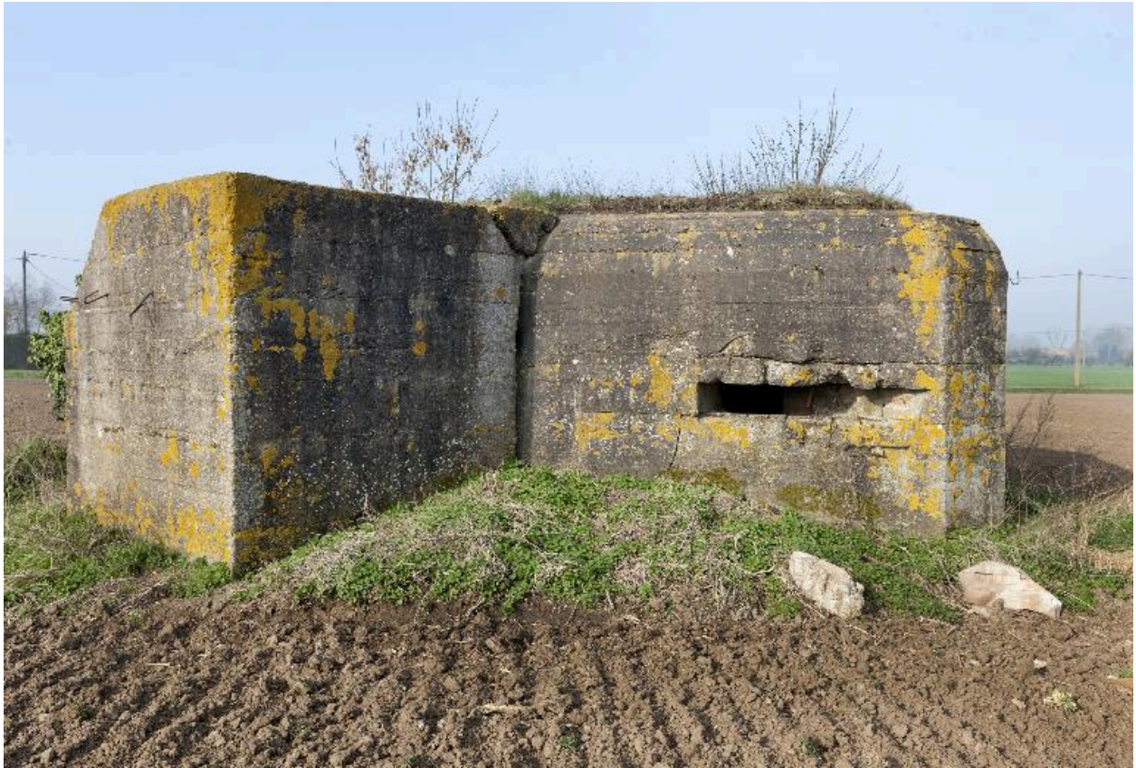
Vue générale vers le sud-ouest. A Gauche la soute à munition.
