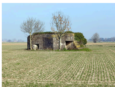
Vue vers l'est depuis la rue des Breux Phot. Jean-Marc Ramette IVR31_20145905321NUCA
