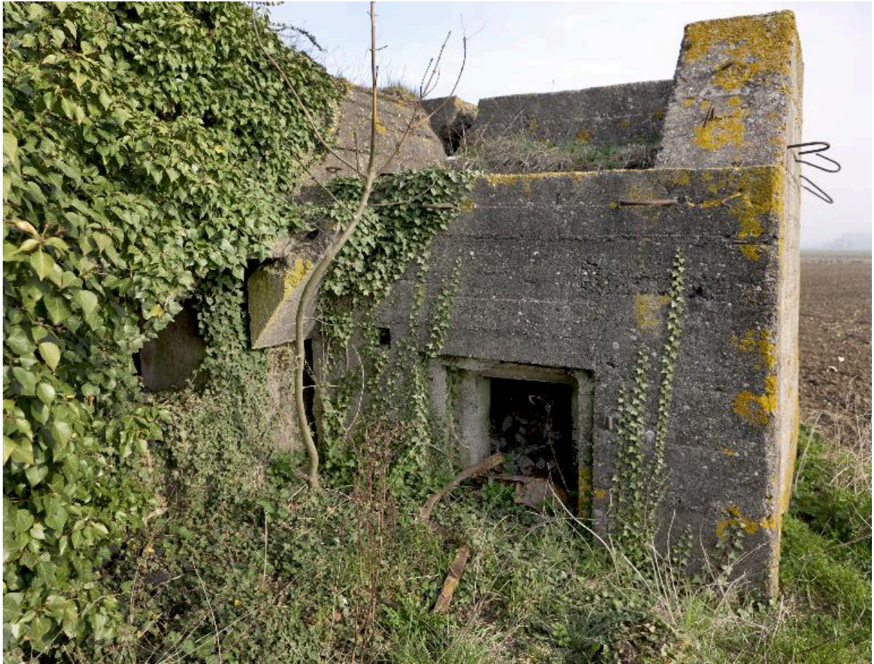
Soute à munitions (?) vers le nord
