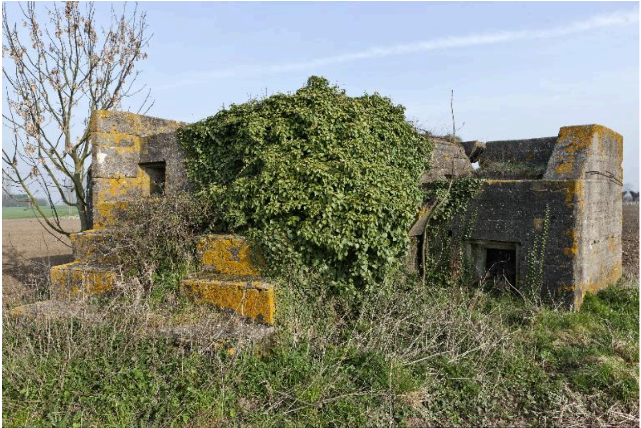
Vue générale, vers le nord-ouest
