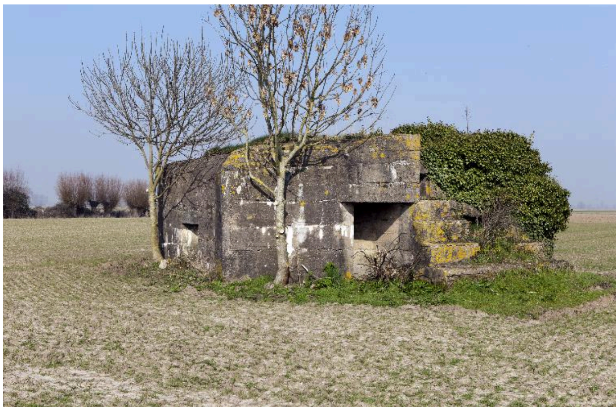
Vue générale vers le nord-est
