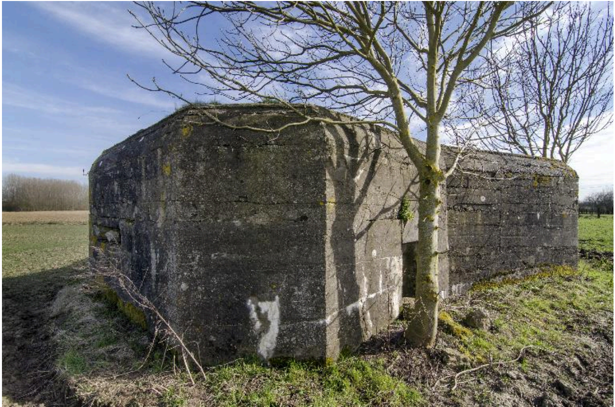
Vue générale vers le sud-est (au grand angulaire)
