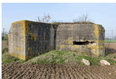
Vue générale vers le sud-ouest. A Gauche la soute à munition. Phot. Jean-Marc Ramette IVR31_20145905303NUCA
