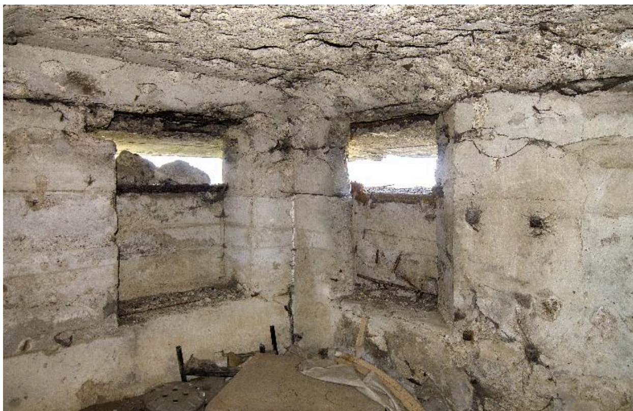
Salle nord, embrasures de tir. A droite deux paires de gonds à la fonction obscure
