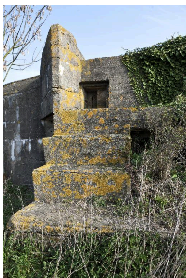
Escalier menant au poste de mitrailleuse. Au centre, la niche à mitrailleuse, en haut et à gauche, celle à munitions Phot. Jean-Marc Ramette IVR31_20145905319NUCA
