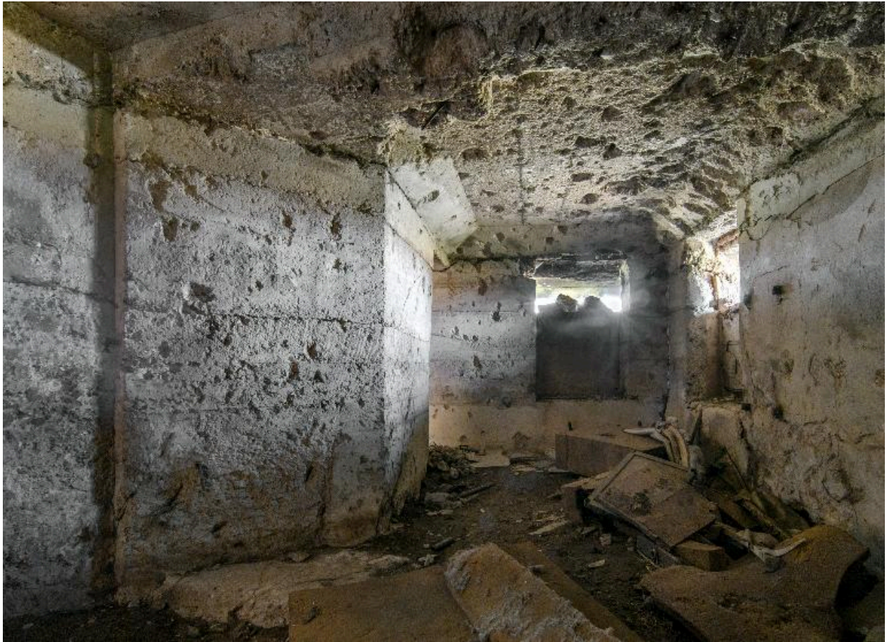
Vue intérieure. Enfilade vers le nord
