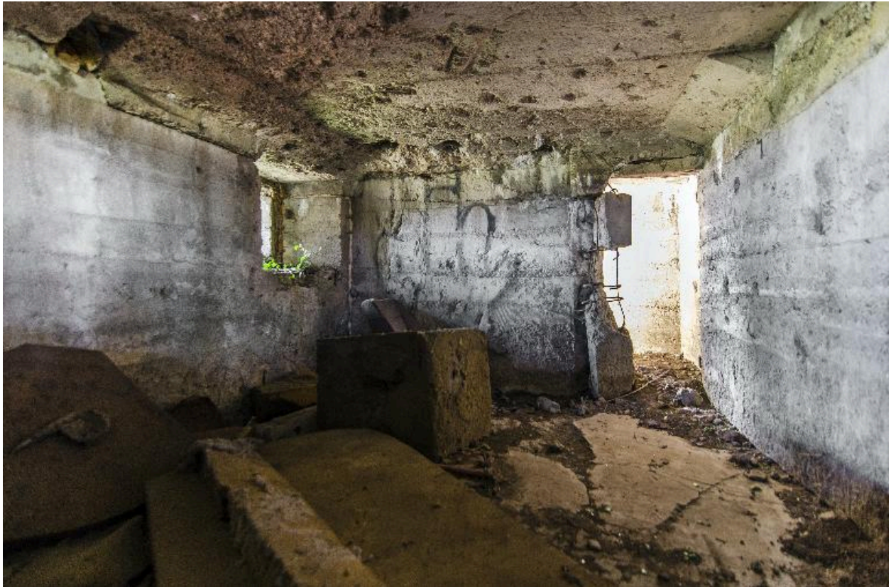
Vue intérieure en enfilade vers le sud
