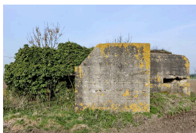
Vue latérale de la soute à munitions. Phot. Jean-Marc Ramette IVR31_20145905302NUCA
