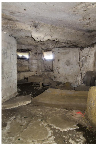
Vue intérieure de la salle nord et des postions de tir. On décèle les traces de l'ancien mur de refend.
