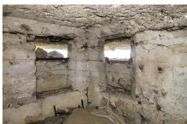
Salle nord, embrasures de tir. A droite deux paires de gonds à la fonction obscure Phot. Jean-Marc Ramette IVR32_20165901519NUCA
