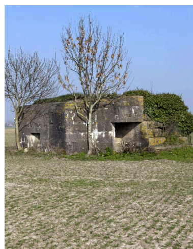
Vue générale vers le nord-est Phot. Jean-Marc Ramette IVR31_20145905290NUCA
