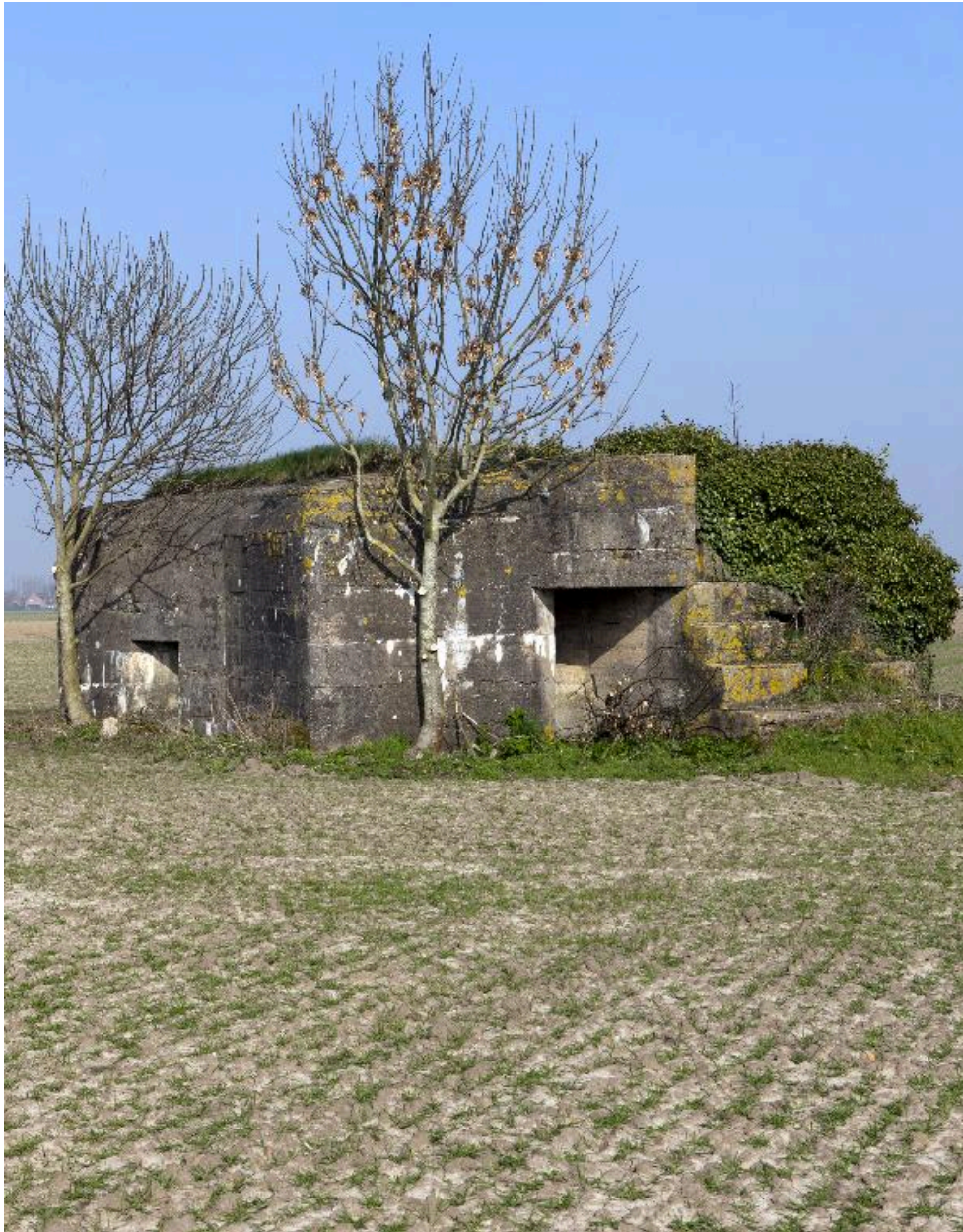
Vue générale vers le nord-est
