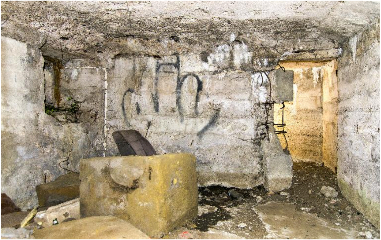
Vue intérieure de la salle sud. Au fond, le couloir en chicane de sortie
