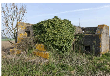
Vue générale, vers le nord-ouest Autr. Jean-Marc Ramette IVR31_20135901083NUC
