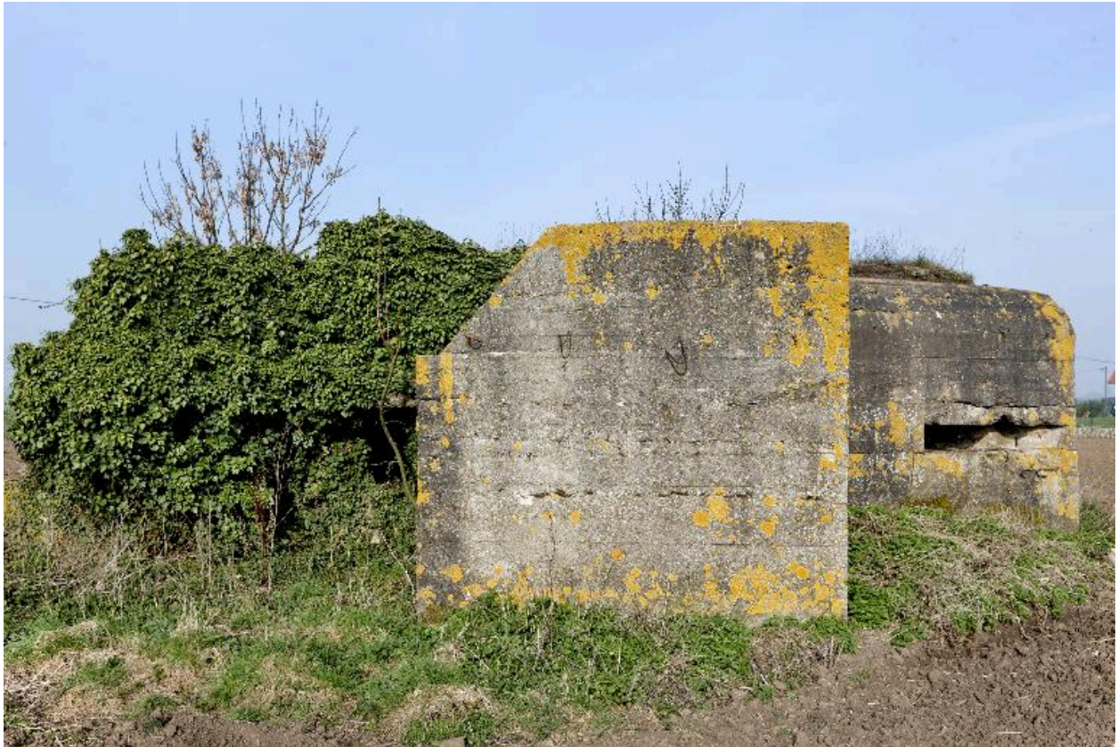
Vue latérale de la soute à munitions.
