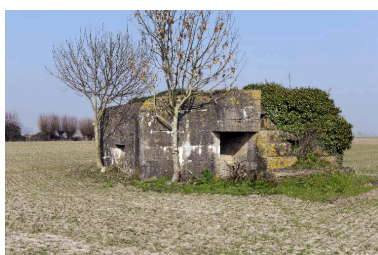
Vue générale vers le nord-est Phot. Jean-Marc Ramette IVR31_20145905291NUCA
