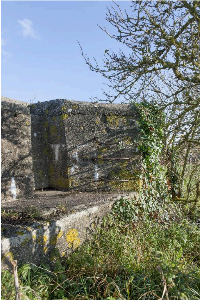
Echélons métalliques donnant accès au couvrement
