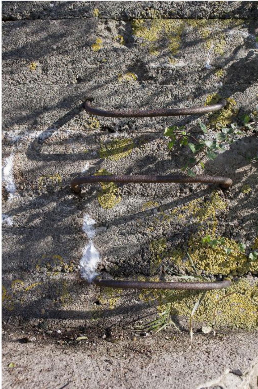
Echelons métalliques donnant accès au couvrement
