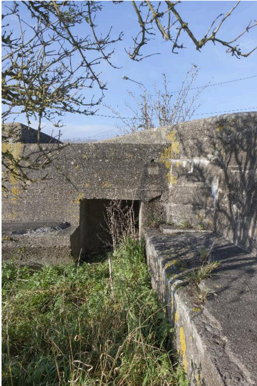
Accès pare-souffle à l'entrée ouest
