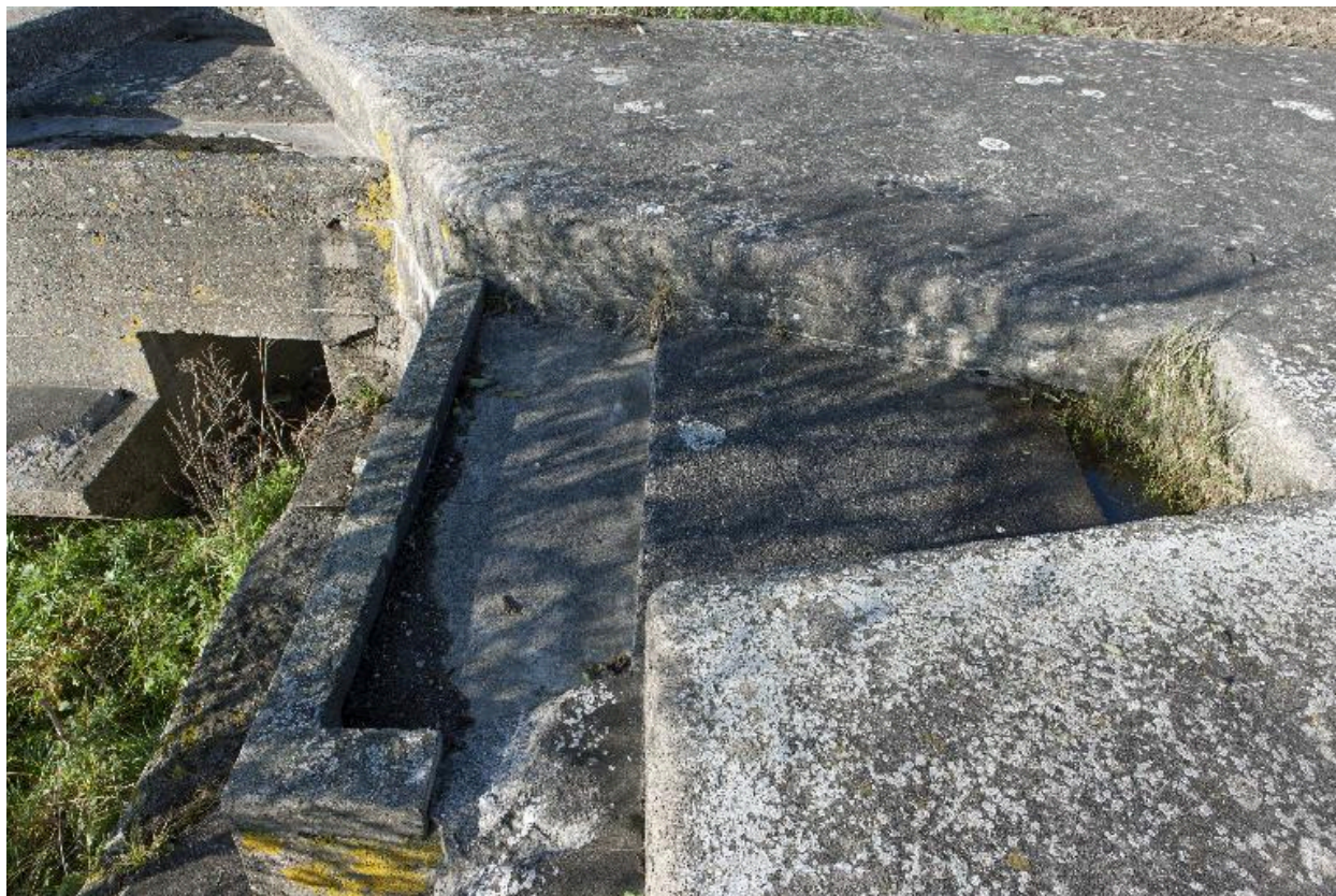
Cuve à mitrailleuse centrale
