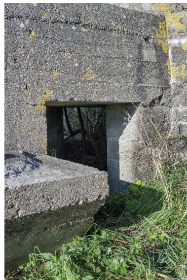
Entrée ouest. Entrée pare-souffle. Phot. Jean-Marc Ramette IVR31_20145904901NUCA
