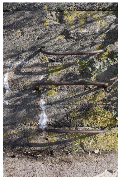
Echélons métalliques donnant accès au couverture Autr. Jean-Marc Ramette IVR31_20145908891NUCA
