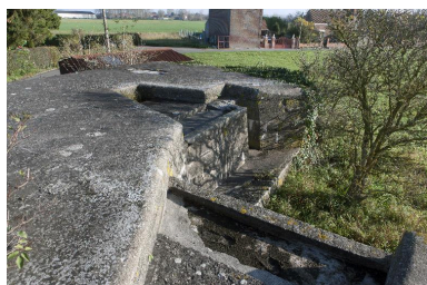
Vue des cuves à mitrailleuse, vers l'est Phot. Jean-Marc Ramette IVR31_20145904897NUCA
