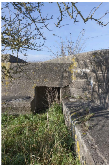
Accès pare-souffle à l'entrée ouest Phot. Jean-Marc Ramette IVR31_20145904895NUCA
