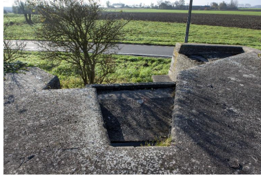
Vue des cuves à mitrailleuse, vers le sud Phot. Jean-Marc Ramette IVR31_20145904899NUCA
