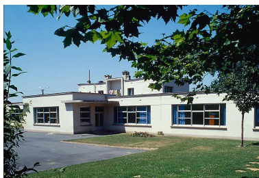
Élévation sud. Phot. Thierry Petitberghien IVR31_19945901216ZA
