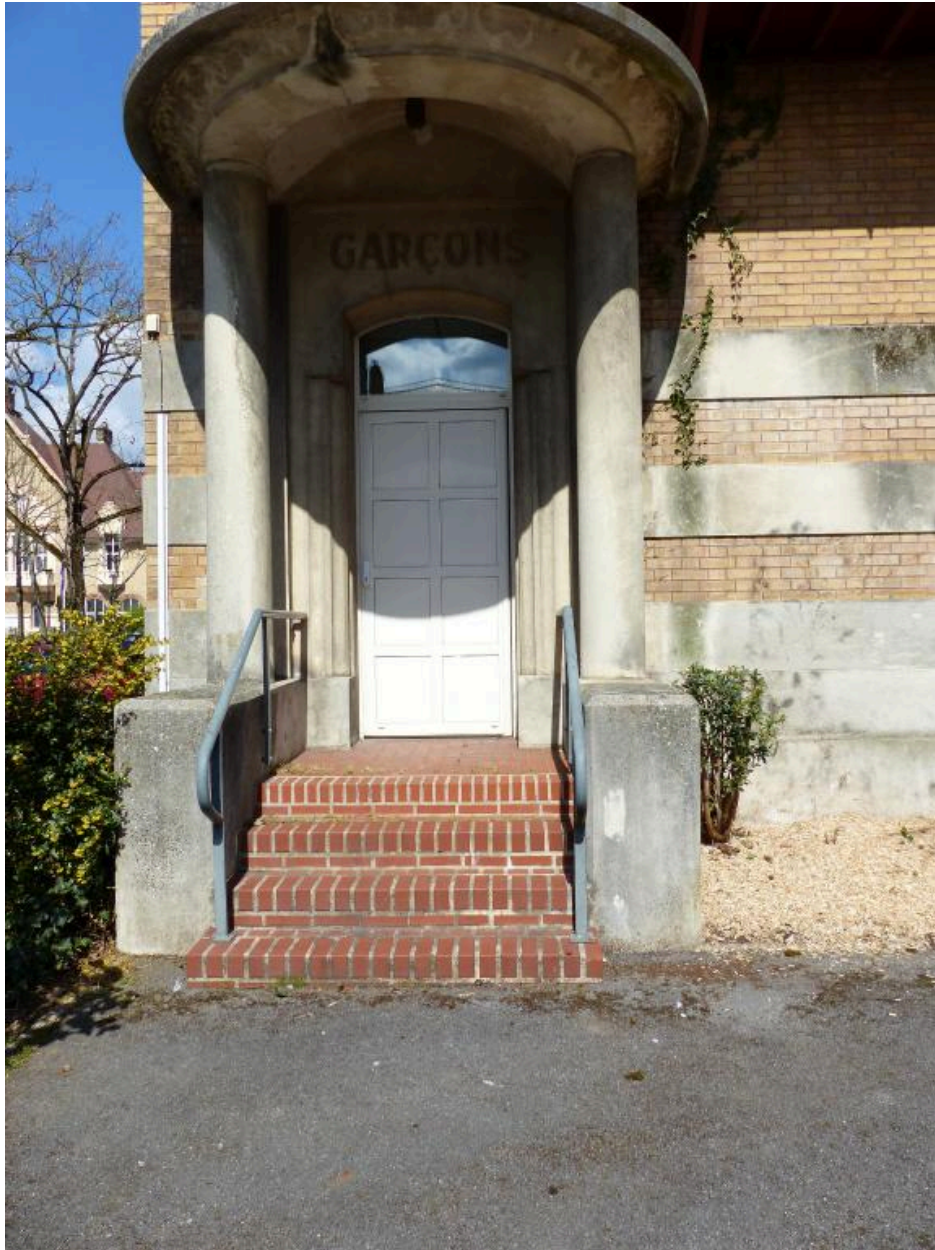
Porte de l'école de garçons (pignon sud).
