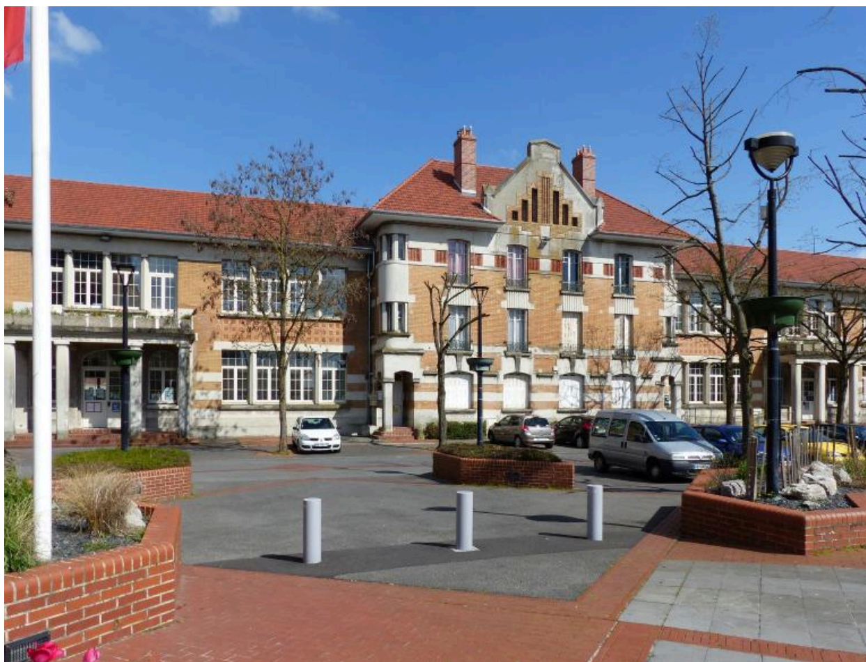
Vue du corps central et des portiques latéraux.
