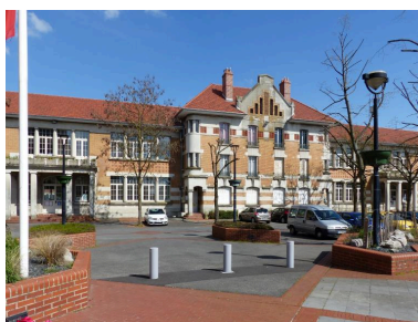
Vue du corps central et des portiques latéraux. Phot. Isabelle Barbedor IVR32_20210205007NUCA
