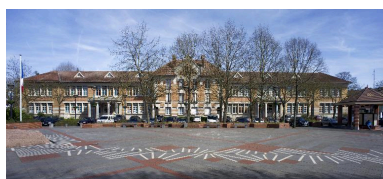
Vue générale de la façade principale donnant sur la place. Phot. Thierry Lefébure IVR32_20170200110NUC2AQ
