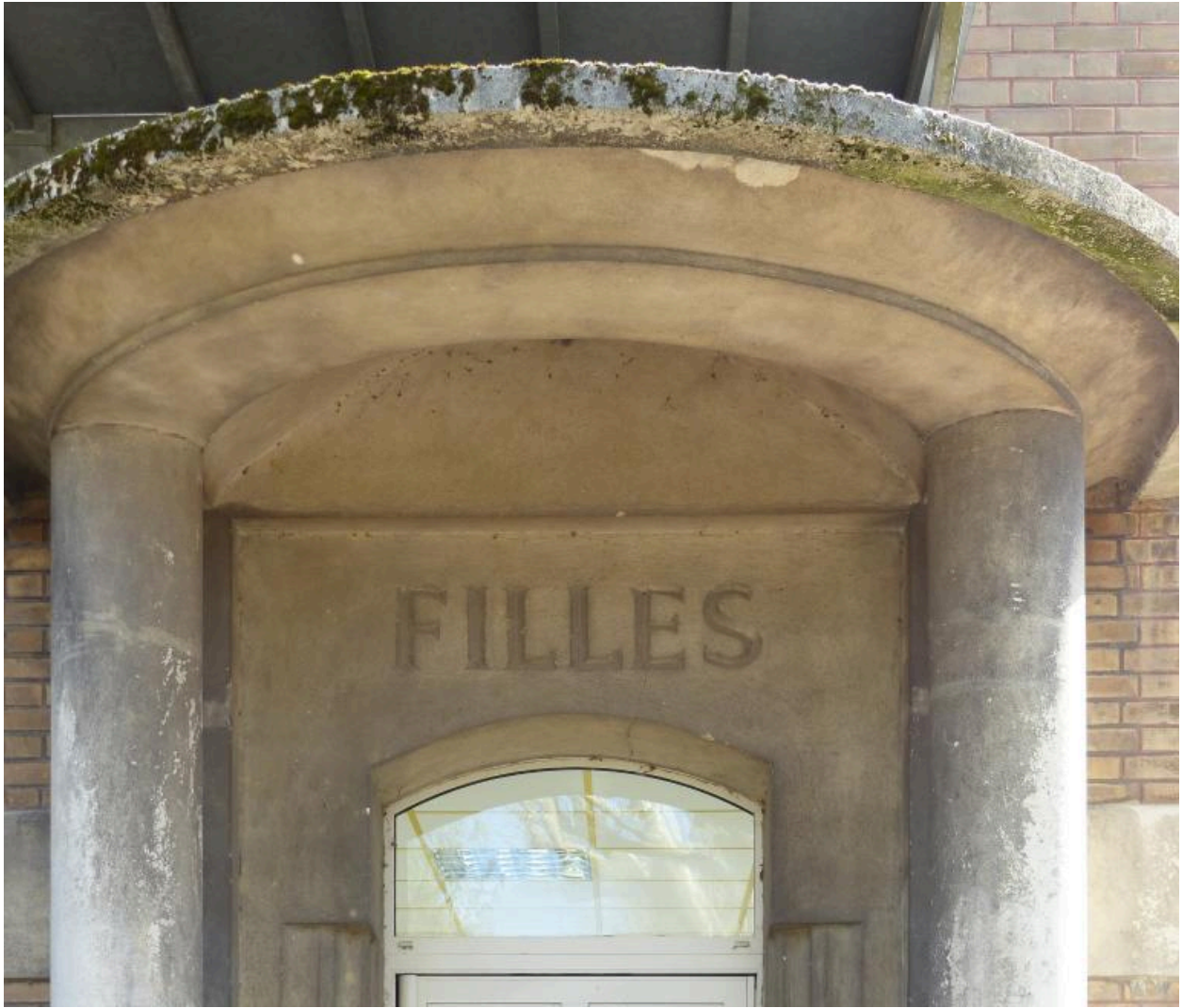
Porte de l'école de filles (pignon nord).
