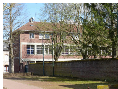
Bâtiments en fond de cour. Bâtiments reconstruits et surélevés vers 1955. Phot. Isabelle Barbedor IVR32_20210205006NUCA
