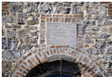
Pierre insérée dans l'élévation sud du bras sud du transept portant un chronogramme de 1632. Phot. Christiane Riboulleau IVR22_19930201234ZA
