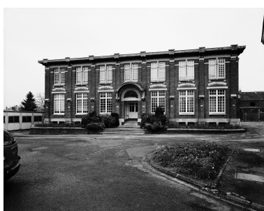
Élévation antérieure. Phot. Thierry Petitberghien IVR31_20025900380V
