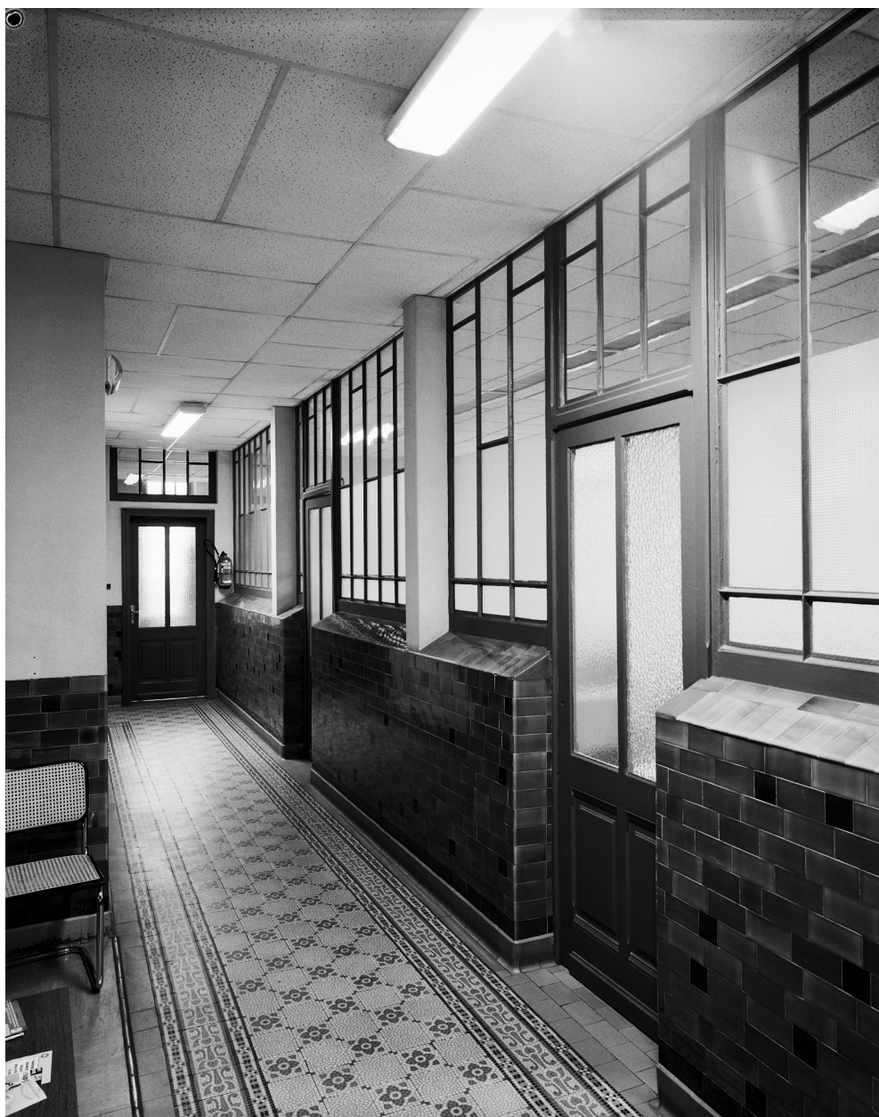
Vue générale du couloir et des bureaux du rez-de-chaussée.
