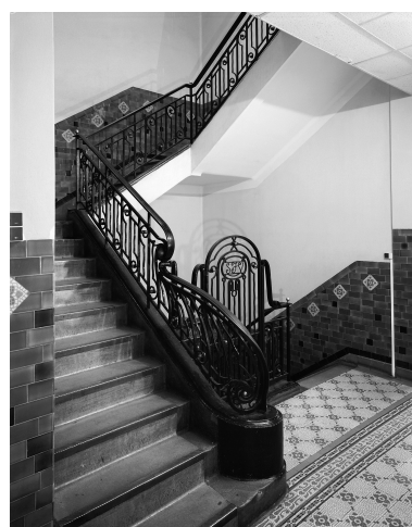
Vue générale de la cage d'escalier : la rampe d'escalier et la porte de l'ascenseur (non réalisé)
