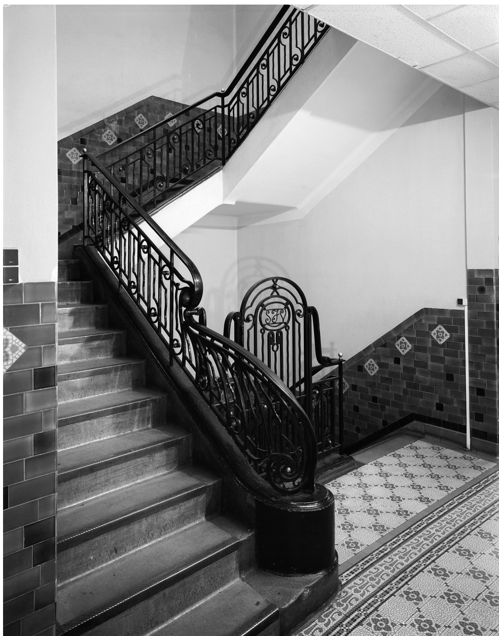
Vue générale de la cage d'escalier : la rampe d'escalier et la porte de l'ascenseur (non réalisé) portant les initiales de l'entreprise Sculfort Fockedey Vautier (SFV).
