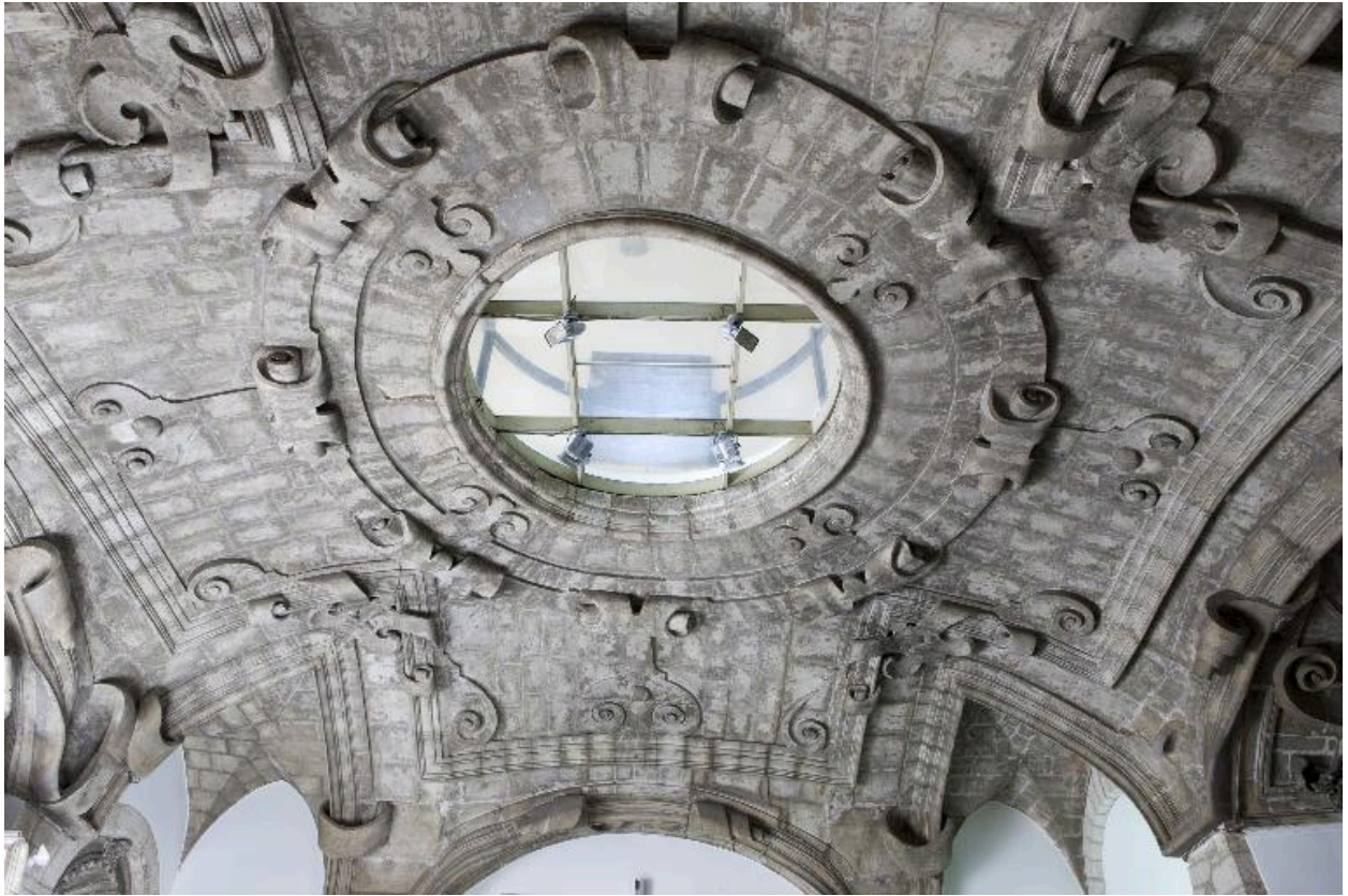
Le porche de l'ancienne église, abritant aujourd'hui une des salles d'exposition du musée ; la voûte en pendentifs.
