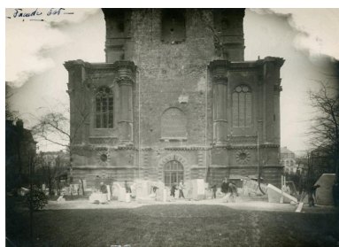
Ouvriers dans le jardin public travaillant à la restauration de la tour de l'abbaye, photographie, années 1930 (Musée municipal Saint-Amand-les-Eaux). IVR31_20135908065NUCA
