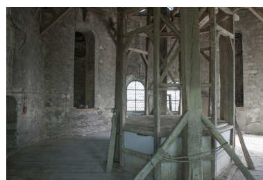
La tour sud-est adossée au porche de l'ancienne église ; l'escalier menant au belvédère.
