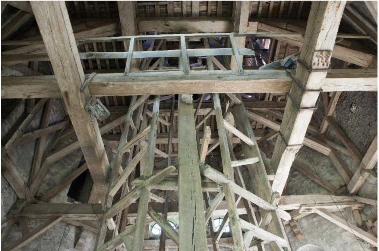
La tour sud-est adossée au porche de l'ancienne église ; la voute et l'échafaudage.
