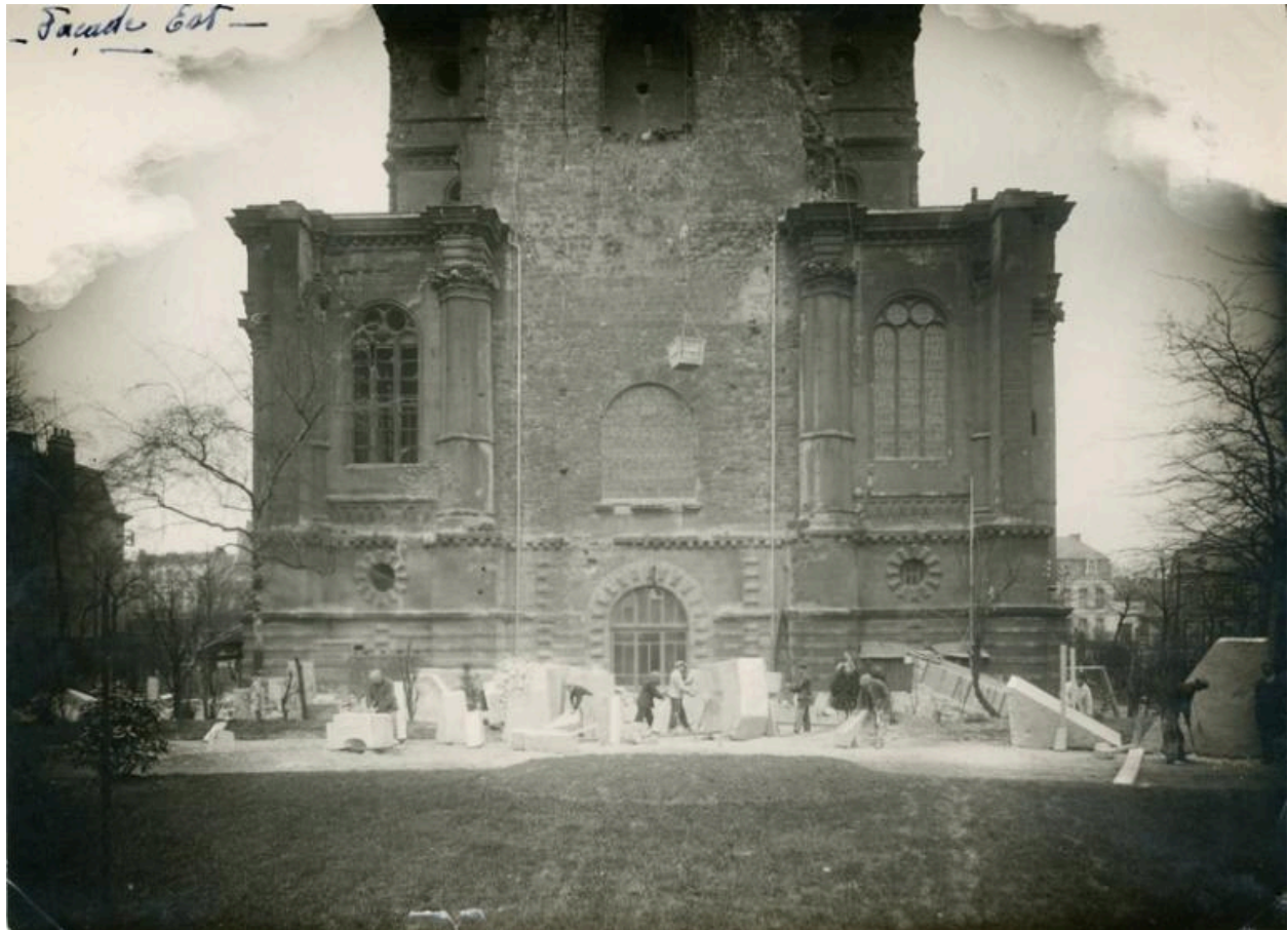
Ouvriers dans le jardin public travaillant à la restauration de la tour de l'abbaye, photographie, années 1930 (Musée municipal Saint-Amand-les-Eaux).
