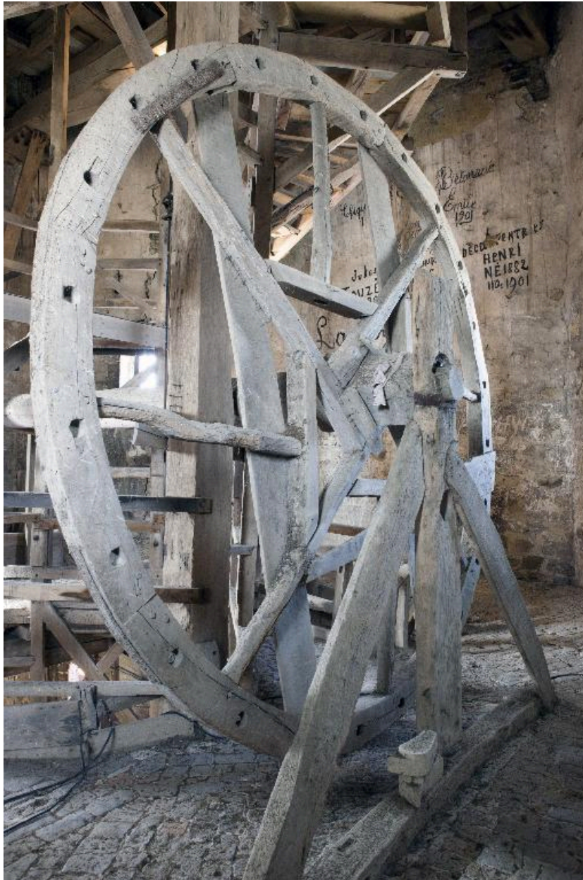
Escalier et roues d'accès au carillon.
