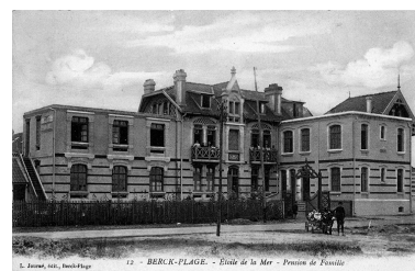
Pension de famille l'Étoile de la Mer - Elévation antérieure, vue générale. Carte postale, début du 20e siècle. Phot. Stein Eddy IVR32_20166200001NUC
