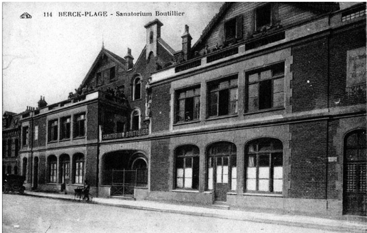
Sanatorium Boutillier - Elévation antérieure donnant sur la rue, vue générale. Carte postale, années 1920-1930.
