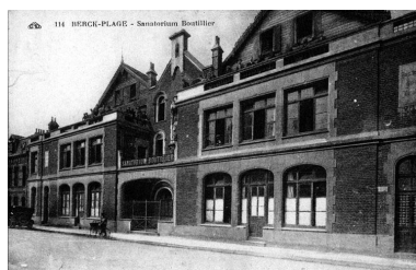
Sanatorium Boutillier - Elévation antérieure donnant sur la rue, vue générale. Carte postale, années 1920-1930. Phot. Thibaut Pierre (reproduction) IVR31_20066200463NUC
