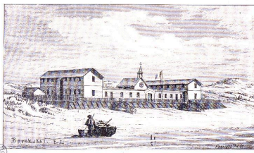
Petit hôpital maritime - Elévations antérieure et latérale gauche telles qu'elles se présentaient lors de l'ouverture de l'établissement en 1861, vue d'ensemble. Gravure, 1885.
