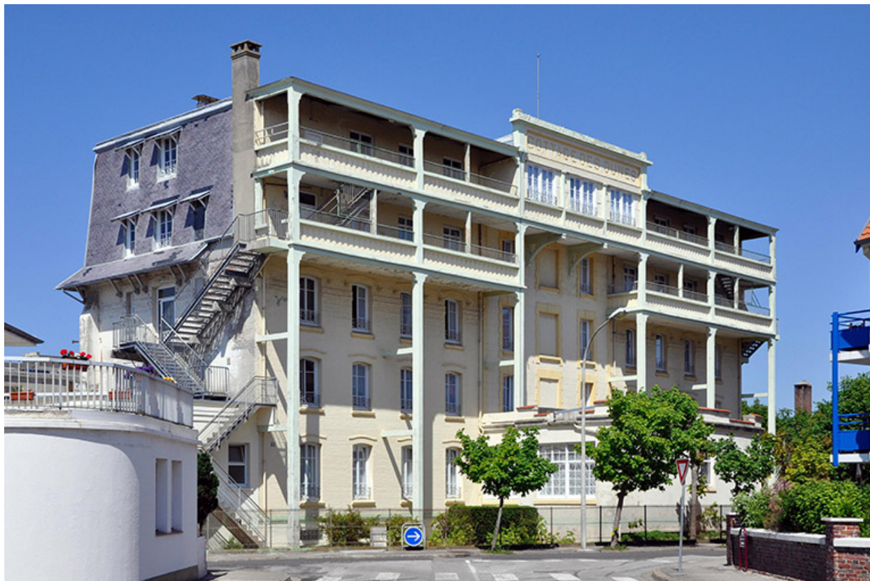
Hôtel de voyageurs, puis hôpital marin dit Cottage des Dunes. Corps de logis principal, élévation postérieure montrant les galeries de cure superposées ajoutées en 1924-1925.
