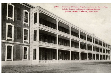
Grand hôpital maritime - Corps de logis méridional de l'édifice primitif, état après l'ajout en 1913 de galeries de cure superposées en béton armé sur une partie de sa face sud. Carte postale, 1er quart du 20e siècle. Phot. Eddy Stein IVR31_20086200002NUCB
