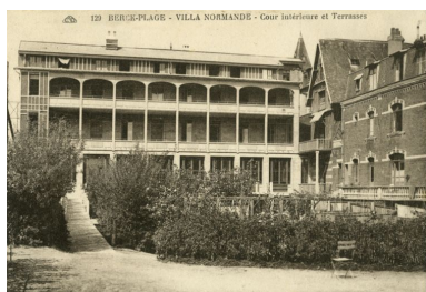
Villa Normande - Revers du bâtiment donnant du côté de la rue Eugène-Trigoulet, ajouté dans les années 1930 et doté d'emblée de galeries de cure. Carte postale, années 1930. Phot. Bouvet Hubert IVR31_20146202321NUC
