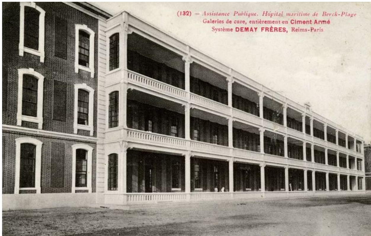
Grand hôpital maritime - Corps de logis méridional de l'édifice primitif, état après l'ajout en 1913 de galeries de cure superposées en béton armée sur une partie de sa face sud. Carte postale, 1er quart du 20e siècle.
