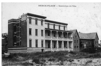
Sanatorium de l'Oise et des départements - Elévation est donnant sur la rue, état après le premier agrandissement vers le sud de l'édifice primitif d'un bâtiment doté de galeries de cure, visible au premier plan. Carte postale, 2e quart du 20e siècle. Phot. Stein Eddy IVR31_20076200012NUC
