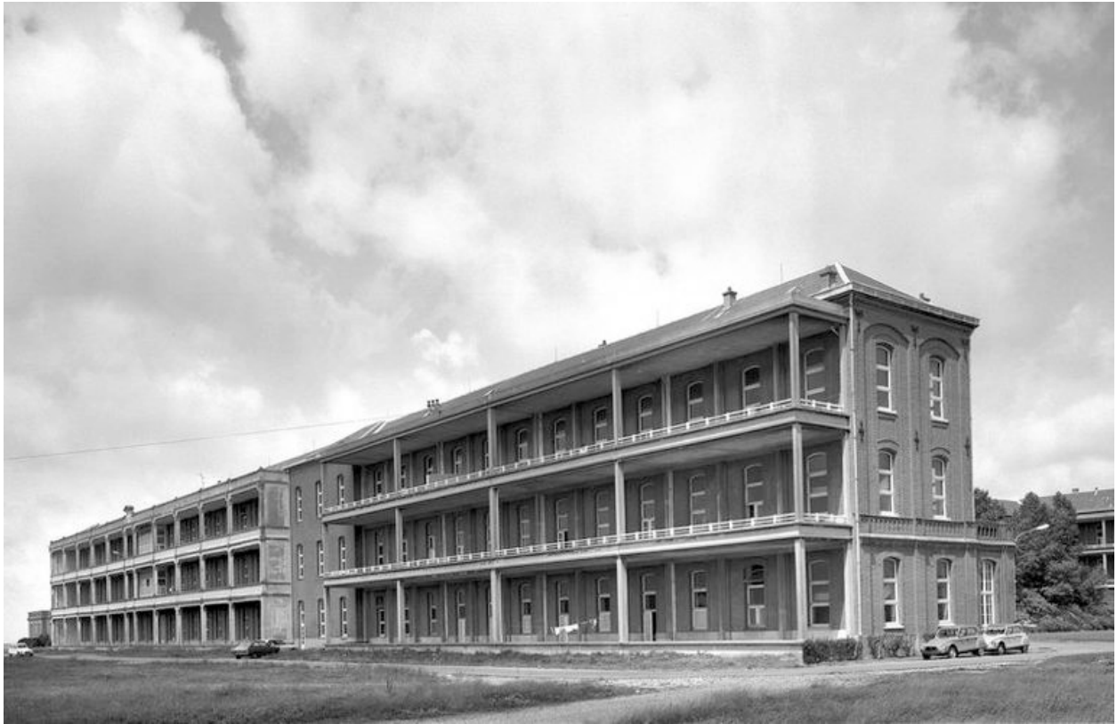
Grand hôpital maritime - Corps de logis méridional de l'édifice primitif, face sud avec ses galeries de cure superposées ajoutées en 1913 du côté ouest, dans les années 1950 du côté est.
