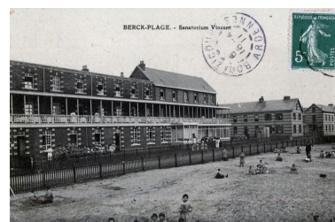
Maison Cornu pour filles puis sanatorium Vincent - Elévation des divers corps de bâtiment sur le chemin des Anglais, vue générale prise de trois-quarts gauche montrant sa nouvelle extension, pourvue d'une galerie de cure seulement au premier étage. Carte postale, début du 20e siècle. Phot. Stein Eddy IVR31_20066200539NUC
