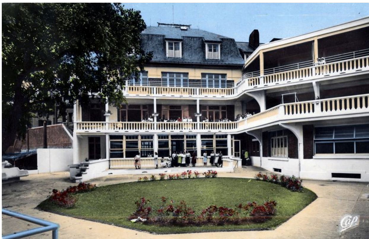
Hôpital Pasteur ou Fondation franco-américaine - Elévations sur la cour avec leurs galeries de cure pour les pensionnaires, vue d'ensemble. Carte postale, 3e quart du 20e siècle.
