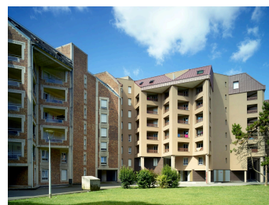
L'îlot 41 (quartier l'Hôtel-de-Ville) en cours d'isolation par l'extérieur (à droite). Phot. Pierre Thibaut IVR32_20195900982NUCA
