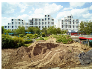
Quartier Le Pont-de-Bois : chantier à l'emplacement de l'ancien collège Léon-Blum, 2019. Au fond : l'îlot 4.
