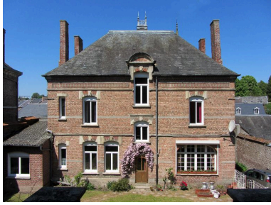
Façade postérieure sur cour, vue d'ensemble. Phot. Bertrand Fournier IVR22_20138015648NUC2A
