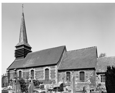
Vue de l'élévation sud de la nef et du chœur, depuis le sud-est. Phot. Thierry Lefébure IVR22_19930200440V
