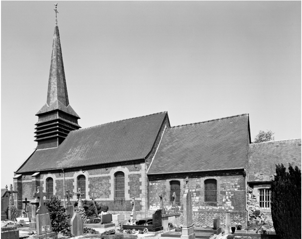
Vue de l'élévation sud de la nef et du choeur, depuis le sud-est.
