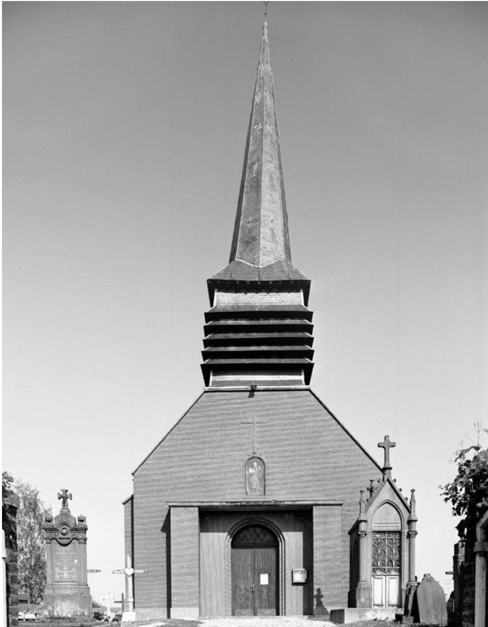
Vue générale de la façade occidentale.
