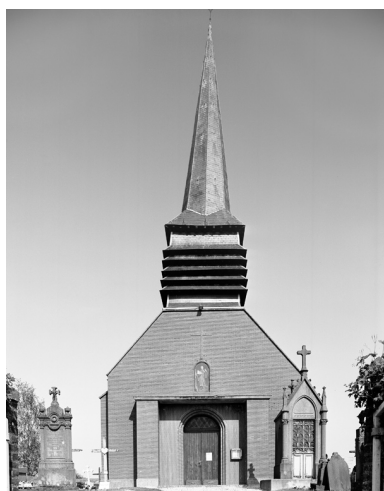
Vue générale de la façade occidentale. Phot. Thierry Lefébure IVR22_19930200441V
