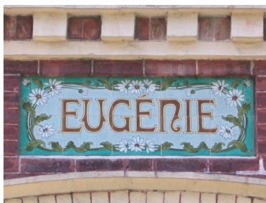
Détail des carreaux de céramique portant appellation Eugénie. Phot. Elisabeth Justome IVR22_20048001581NUCA
