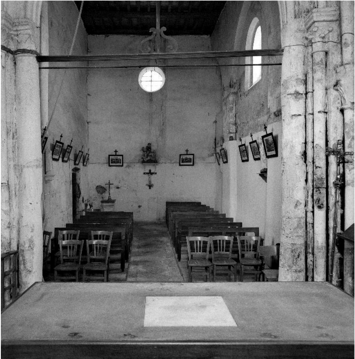
Vue intérieure de l'église, prise du chœur vers la nef.
