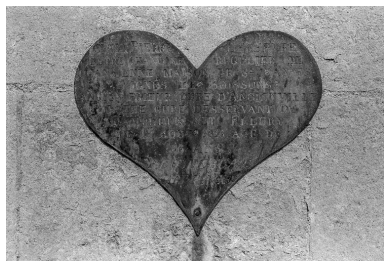
Vue d'un cœur en cuivre fixé sur le contrefort sud du chœur, provenant de la croix funéraire de l'abbé Pierre Lefebvre, curé de Dampleux et Fleury, décédé le 1er août 1826. Phot. Christiane Riboulleau IVR22_19880201247X
