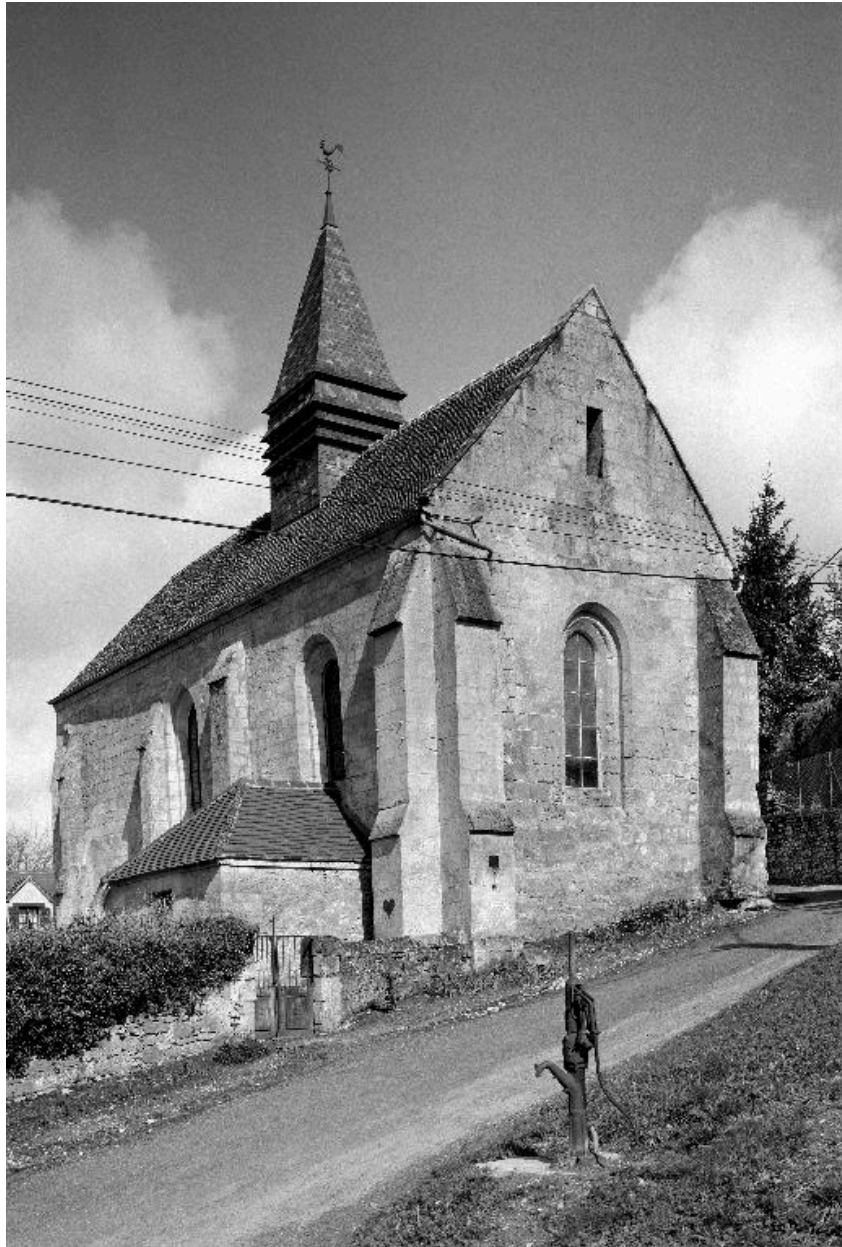
Vue générale de l'église, depuis le sud-est.
