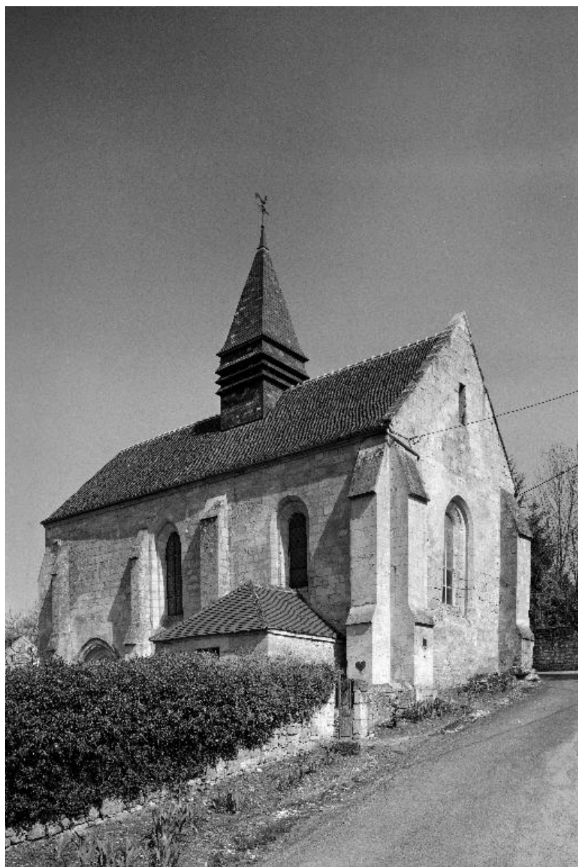
Vue générale de l'église, depuis le sud.
