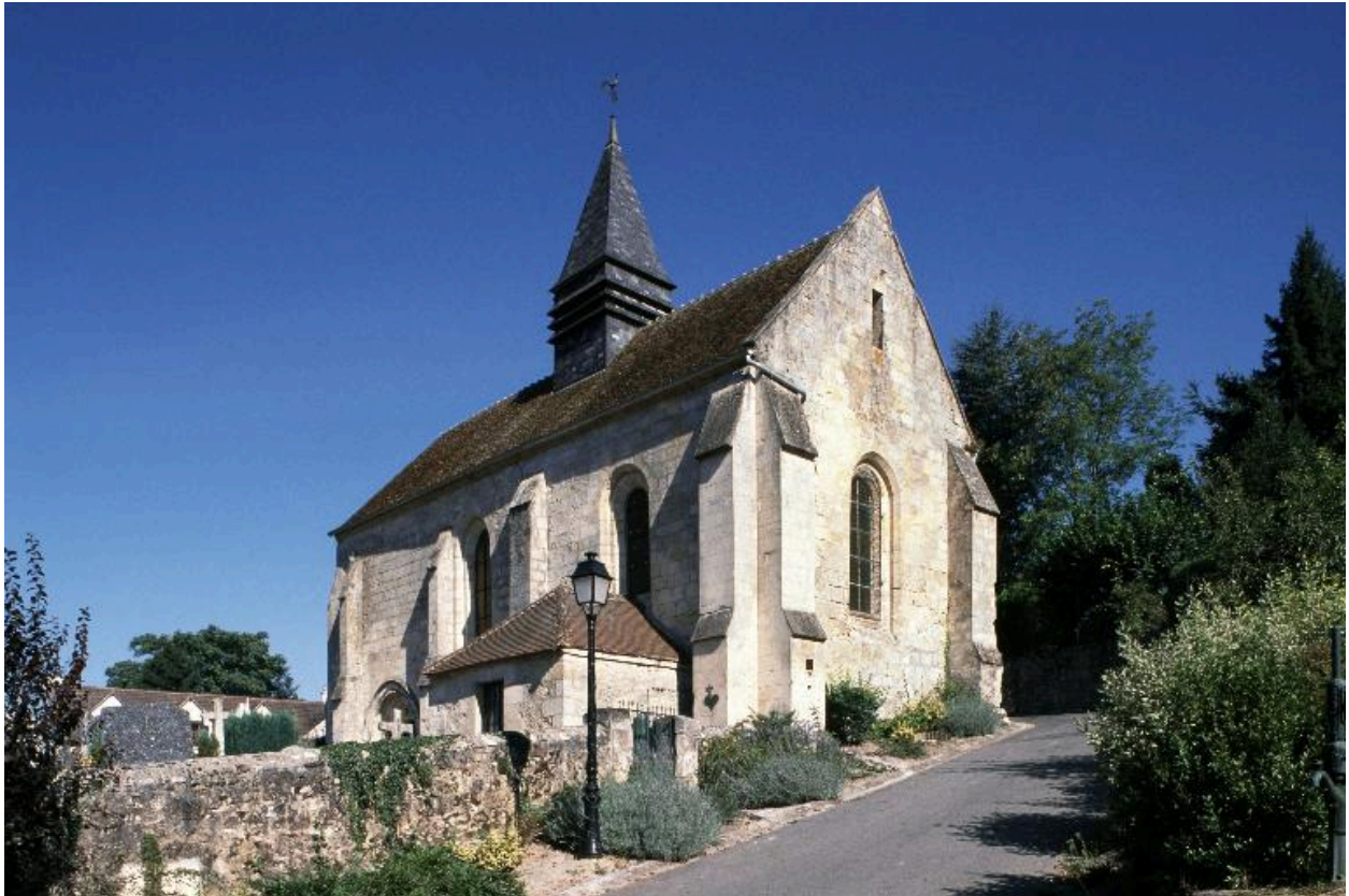
Vue générale sud de l'église.
