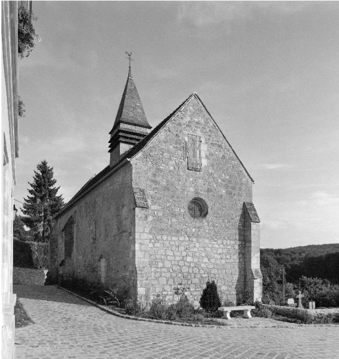
Vue de l'église, depuis le nord-ouest.
