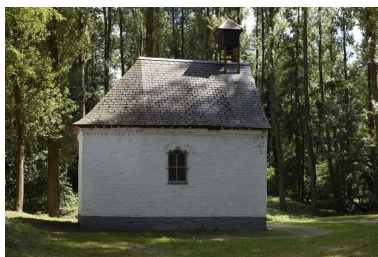
Vue de la chapelle Notre-Dame-des-Prés. Phot. Pierre Thibaut IVR31_20095902734NUCA
