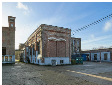
Façade nord de l'ancienne chaufferie (bâtiment K). Phot. Thierry Lefébure IVR32_20238000031NUCA
