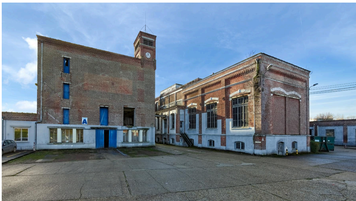
Vue d'ensemble des anciens ateliers de fabrication de la filature et de l'ancienne chaufferie (bâtiment A et K).
