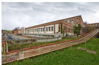
Vue d'ensemble depuis le sud-ouest (bâtiment K, partie basse et haute). Phot. Thierry Lefébure IVR32_20238000121NUCA
