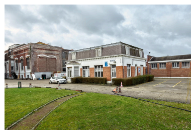
Bâtiment B, vue d'ensemble des bureaux depuis le nord-est. Phot. Thierry Lefébure IVR32_20238000020NUCA
