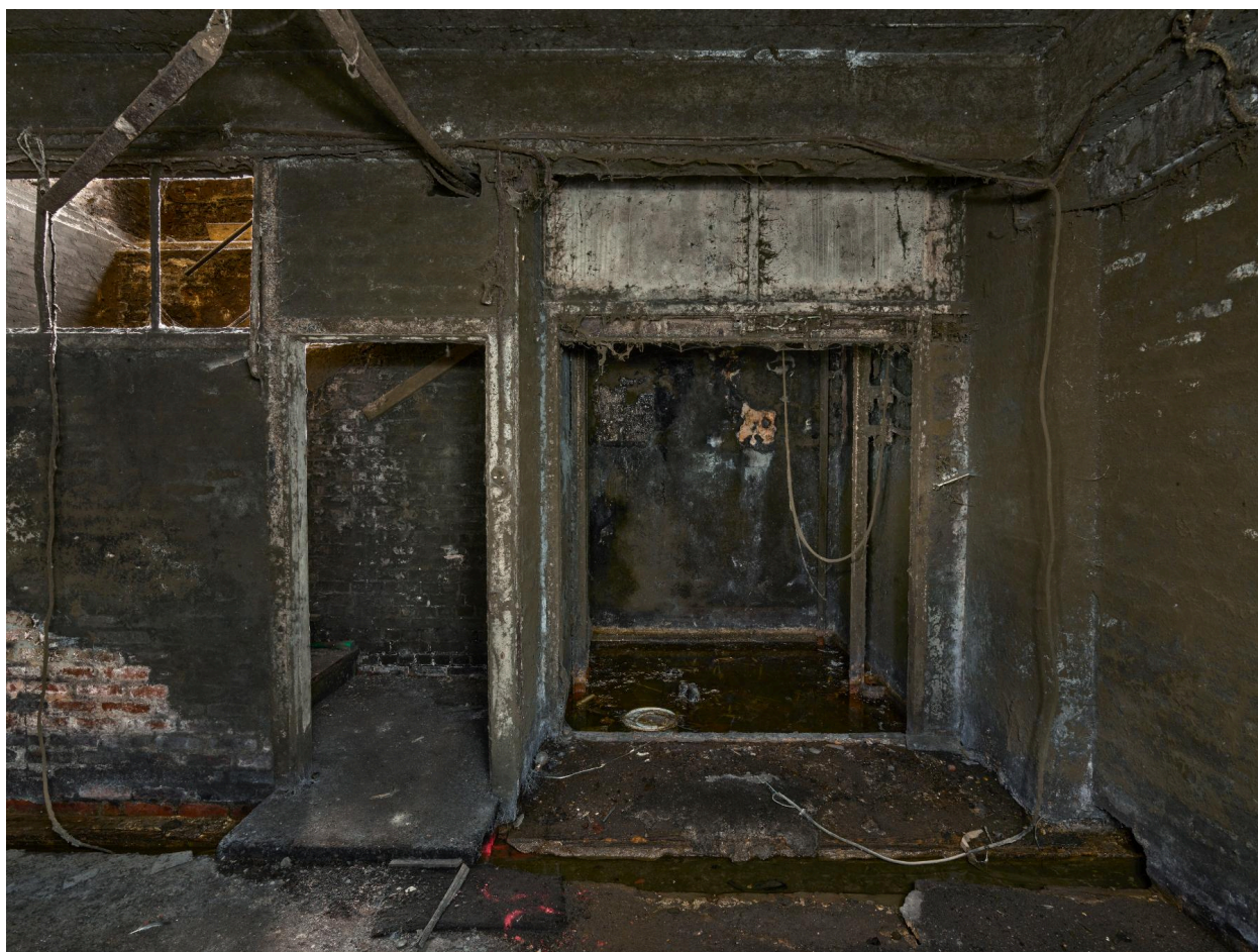
Bâtiment A, monte-charge depuis le sous-sol.
