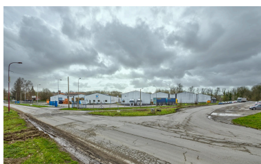
Vue d'ensemble des halles de fabrication de l'usine Acia construites après 1984.
