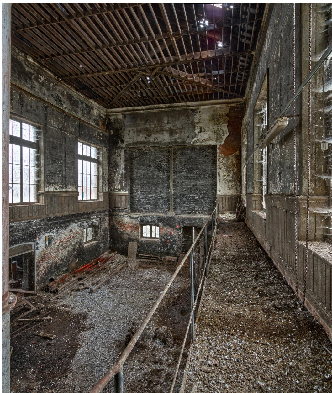
Vue intérieure de la salle des machines.
