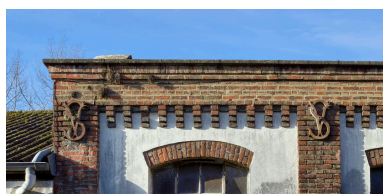
Détail des fers d'ancrage portant les initiales VS sur la façade est d'un des ateliers (bâtiment M).
