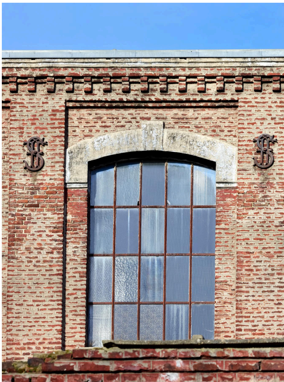
Détail d'une ouverture du deuxième étage de l'ancien atelier de fabrication encadré de fers d'ancrage portant les initiales de l'industriel.
