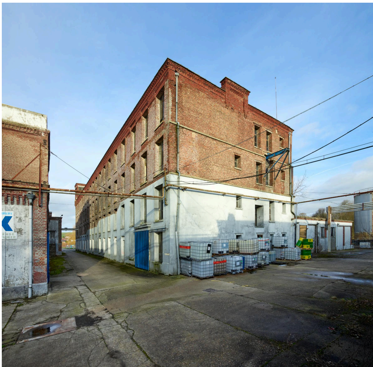
Bâtiment A, vue d'ensemble de la façade sud.
