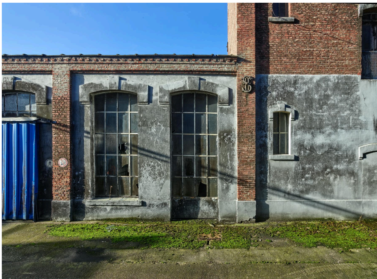
Ouvertures au rez-de-chaussée de la façade est de l'atelier de fabrication (bâtiment K).
