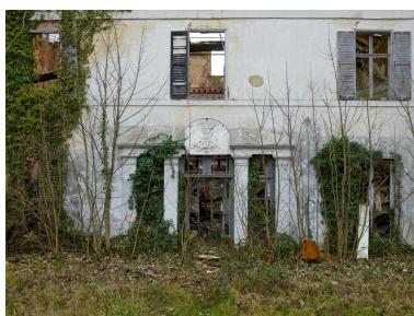
Entrée de l'ancien logement patronal. Phot. Thierry Lefébure IVR32_20238000133NUCA
