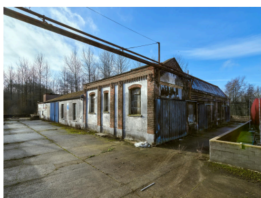
Vue générale nord-est d'un atelier (bâtiment M). Phot. Thierry Lefébure IVR32_20238000088NUCA
