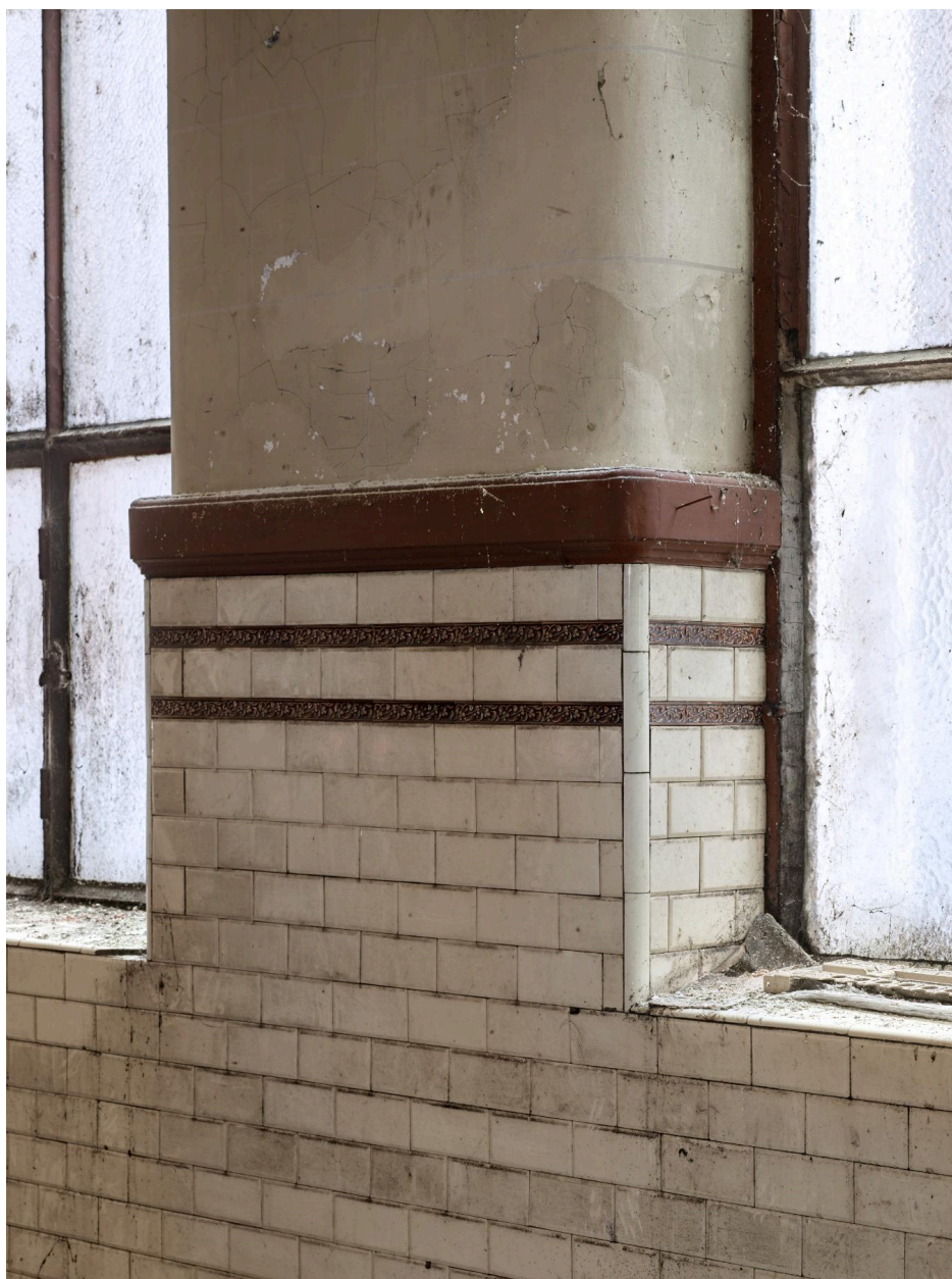
Salle des générateurs électriques, détail des revêtements céramiques sur le mur est.
