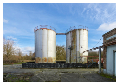
Cuves de stockage entre les bâtiments A et N. Phot. Thierry Lefébure IVR32_20238000098NUCA
