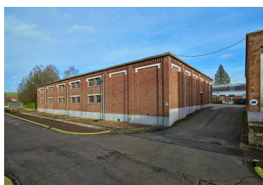
Vue d'ensemble nord-ouest des entrepôts (bâtiment E). Phot. Thierry Lefébure IVR32_20238000024NUCA
