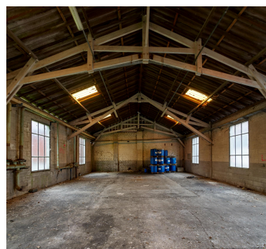
Intérieur de la partie sud d'un des ateliers à charpente apparente (bâtiment M).
