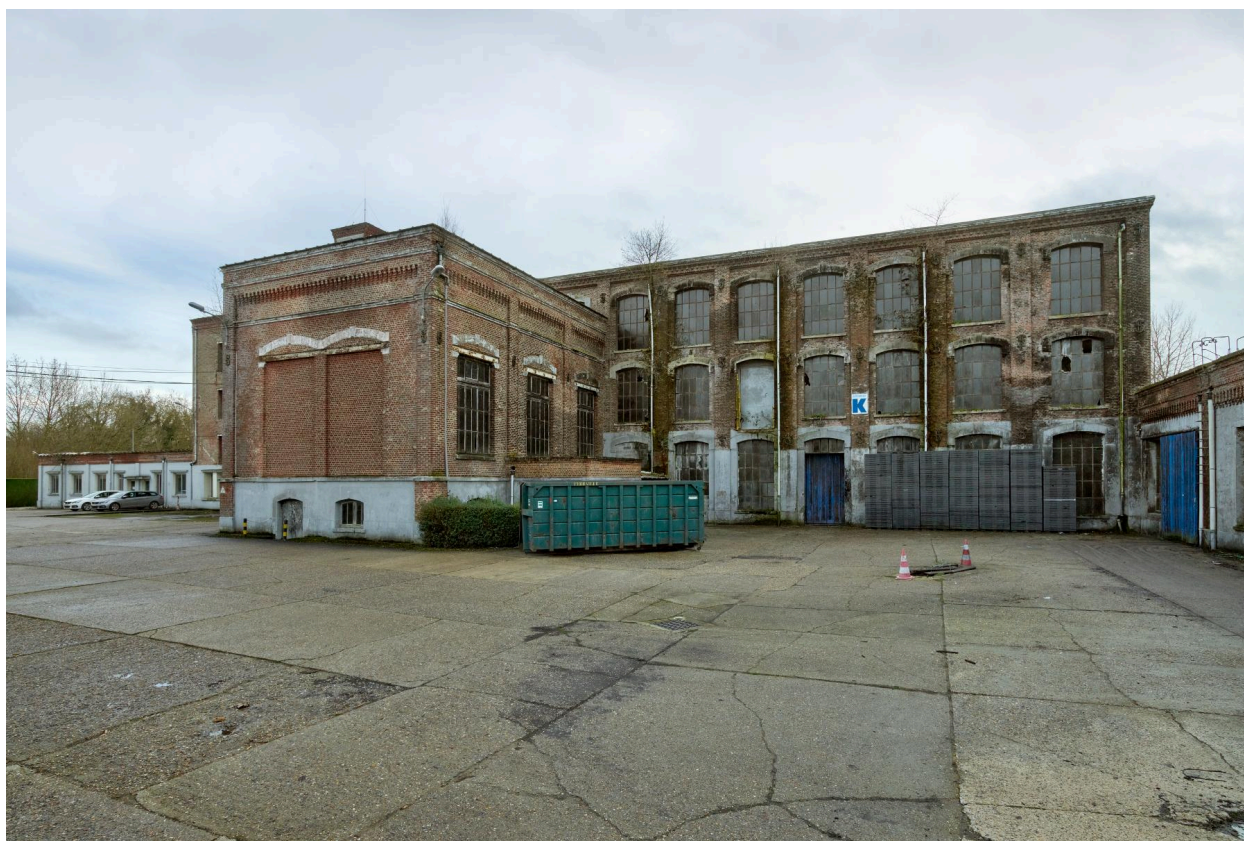
Vue d'ensemble nord de l'ancienne chaufferie et de l'atelier de fabrication (bâtiment K).
