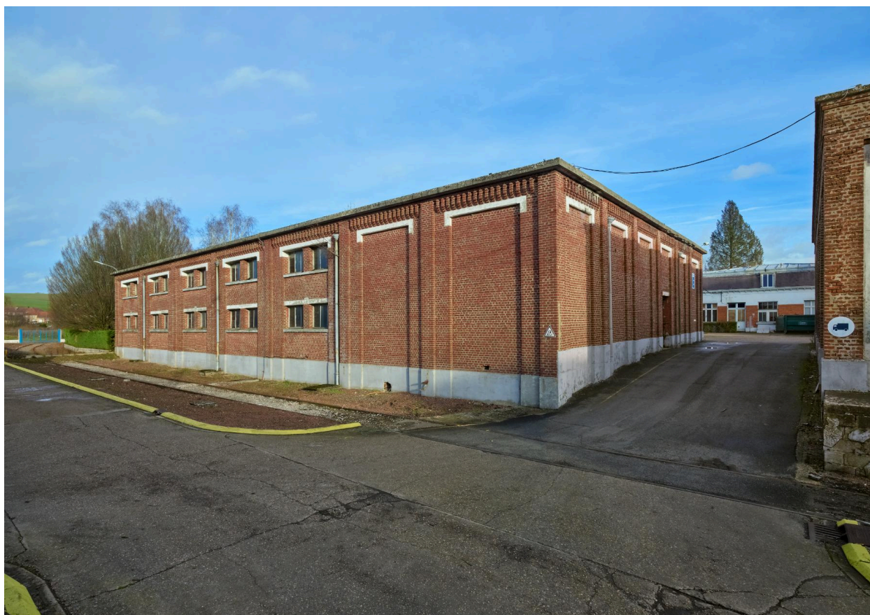
Vue d'ensemble nord-ouest des entrepôts (batiment E).
