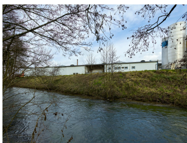
Vue des halles de fabrication de l'usine de produits chimiques Acia depuis la rive opposée de l'Authie. Phot. Thierry Lefébure IVR32_20238000126NUCA
