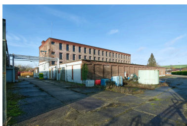
Bâtiment A, vue d'ensemble depuis le sud-est. Phot. Thierry Lefébure IVR32_20238000003NUCA
