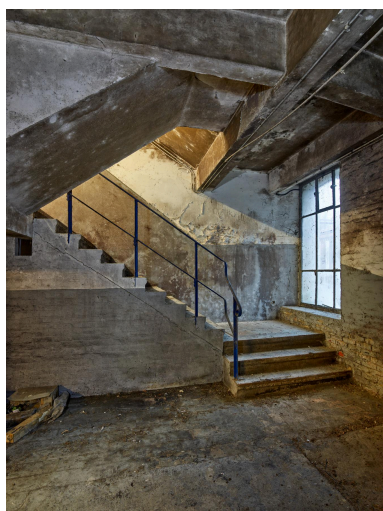
Bâtiment A, escalier en béton desservant les étages. Phot. Thierry Lefébure IVR32_20238000015NUCA
