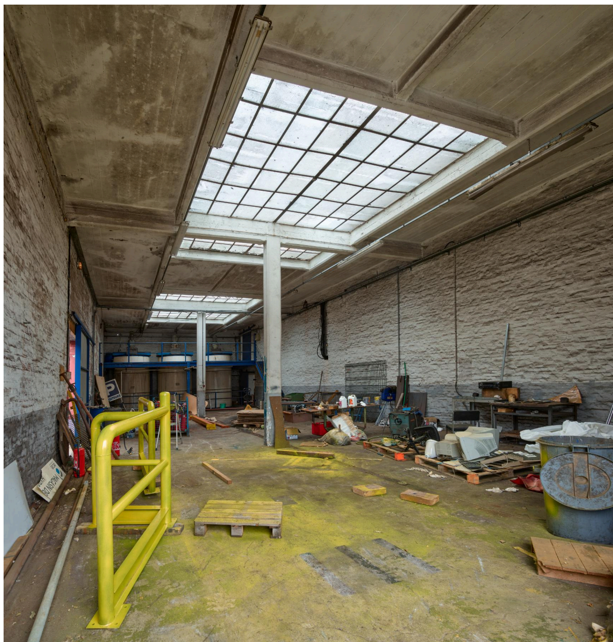
Intérieur des entrepôts (bâtiment E).
