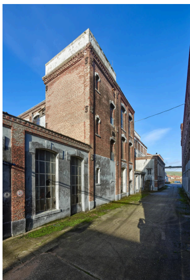
Façade est de l'ancien atelier de fabrication (bâtiment K).
