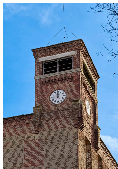
Bâtiment A, détail de l'horloge située à l'angle nord-ouest de l'édifice. Phot. Thierry Lefébure IVR32_20238000007NUCA
