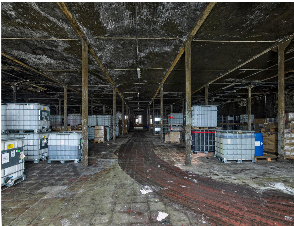
Intérieur du rez-de-chaussée de l'atelier de fabrication.
