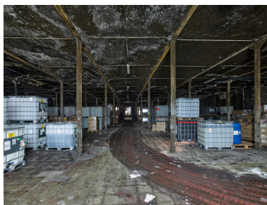
Intérieur du rez-de-chaussée de l'atelier de fabrication.
