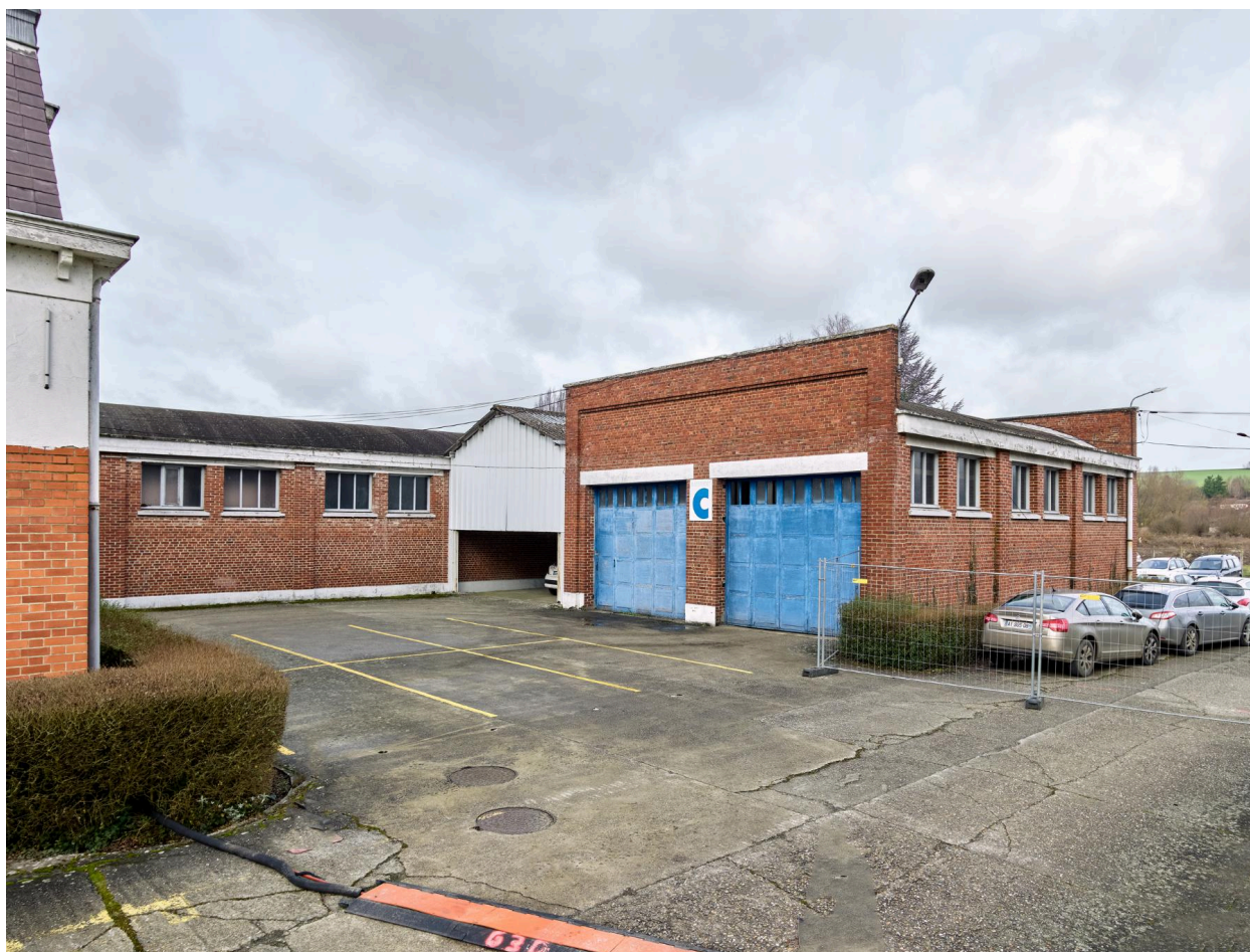
Bâtiment technique et logistique à l'entrée de l'usine (bâtiment C).
