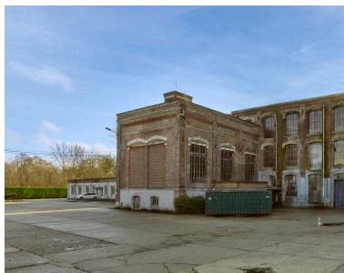
Vue générale nord-ouest de la salle des machines attenante à l'atelier de fabrication. Phot. Thierry Lefébure IVR32_20238000064NUCA
