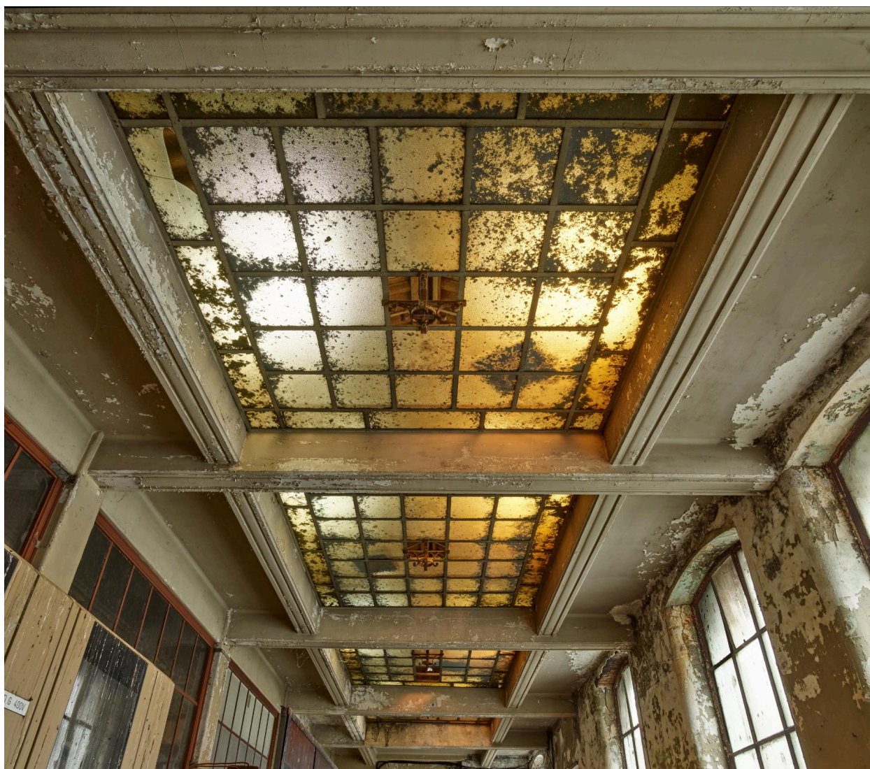
Salle des générateurs électriques, détail du plafond en béton et verre cathédrale.
