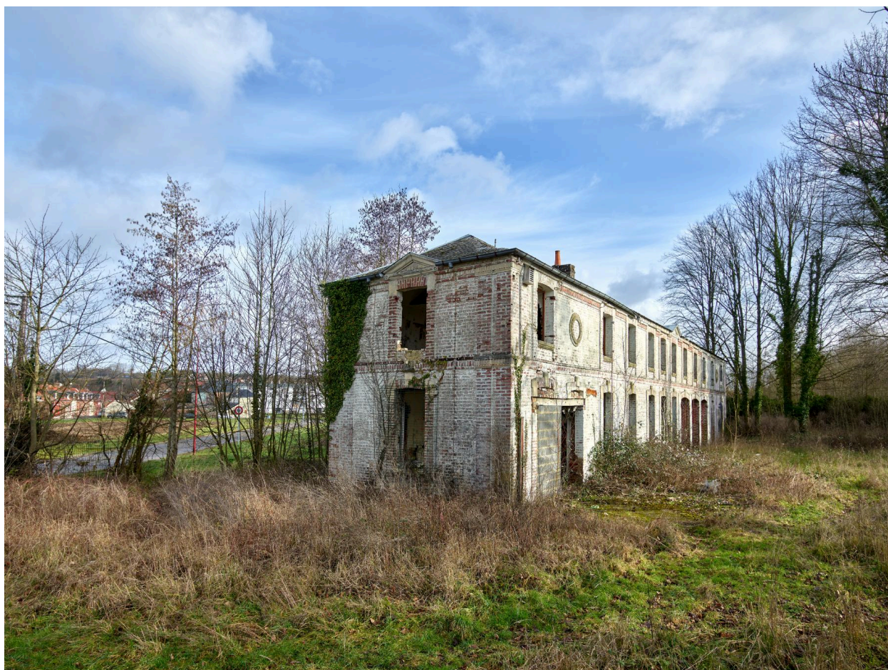
Dépendance du logement patronal, vue de trois quarts.
