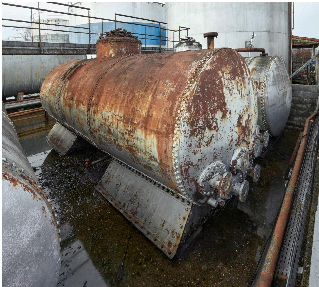
Cuves de stockage de produits chimiques.
