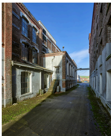
Salle des générateurs électriques, vue depuis le sud. Phot. Thierry Lefébure IVR32_20238000065NUCA
