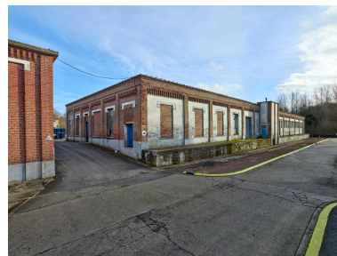
Magasins avec le quai de chargement et l'embranchement ferroviaire à l'avant, vue générale depuis le nord-ouest (bâtiment K). Phot. Thierry Lefébure IVR32_20238000081NUCA
