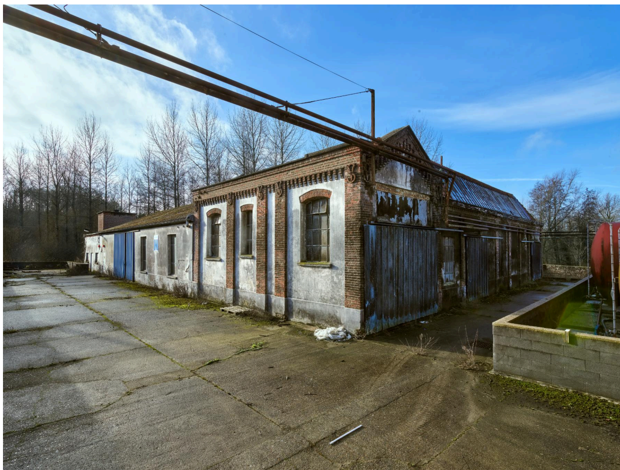
Vue générale nord-est d'un atelier (bâtiment M).
