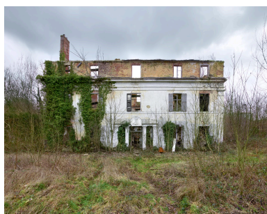
Ancien logement patronal, vue de face. Phot. Thierry Lefébure IVR32_20238000132NUCA
