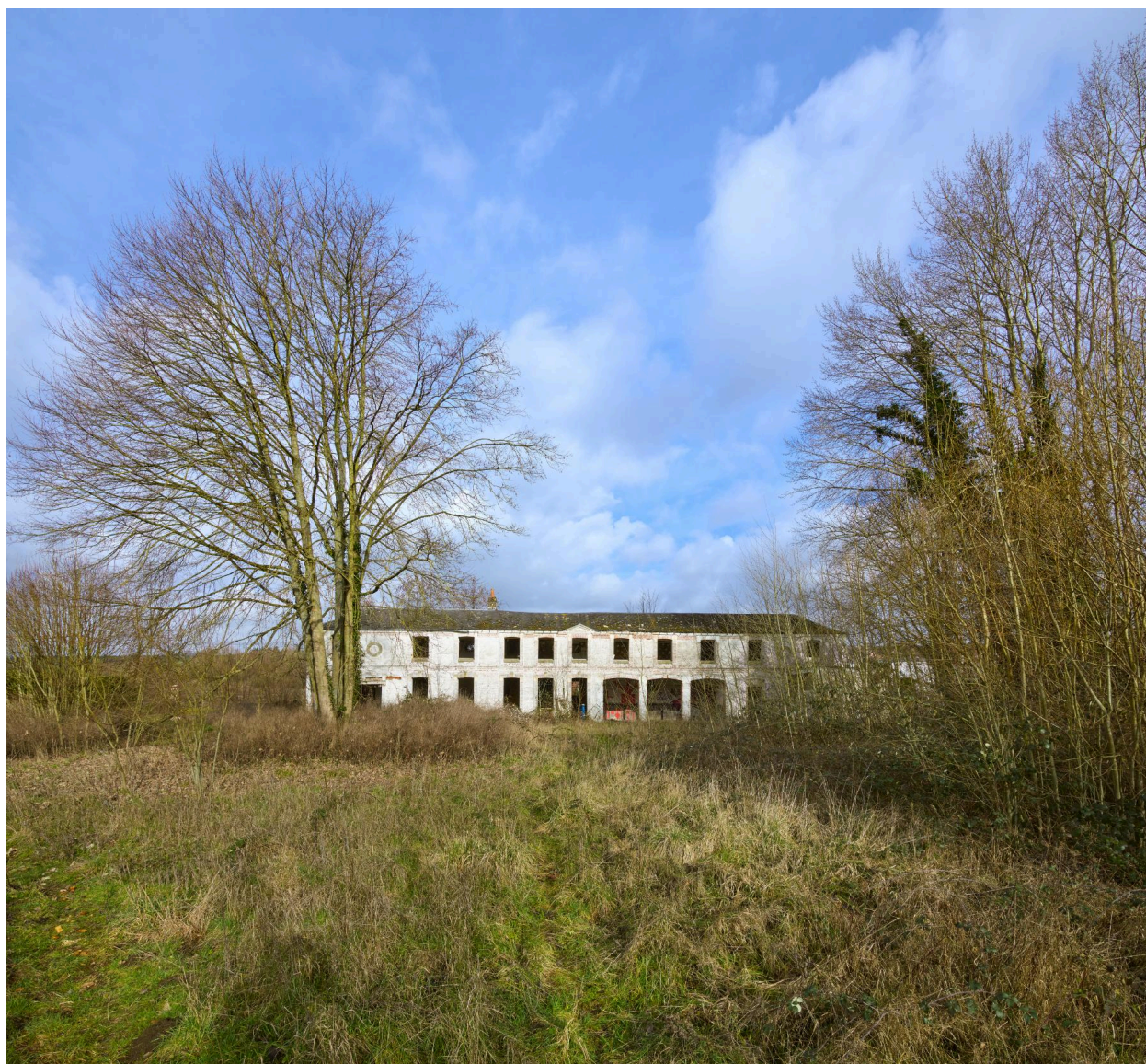
Dépendance du logement patronal, vue générale depuis le logement.
