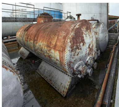
Cuves de stockage de produits chimiques. Phot. Thierry Lefébure IVR32_20238000124NUCA
