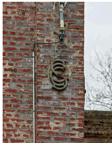
Détail d'un fer d'ancrage portant les initiales entrelacées CS. Phot. Thierry Lefébure IVR32_20238000066NUCA
