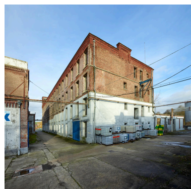
Bâtiment A, vue d'ensemble de la façade sud. Phot. Thierry Lefébure IVR32_20238000008NUCA
