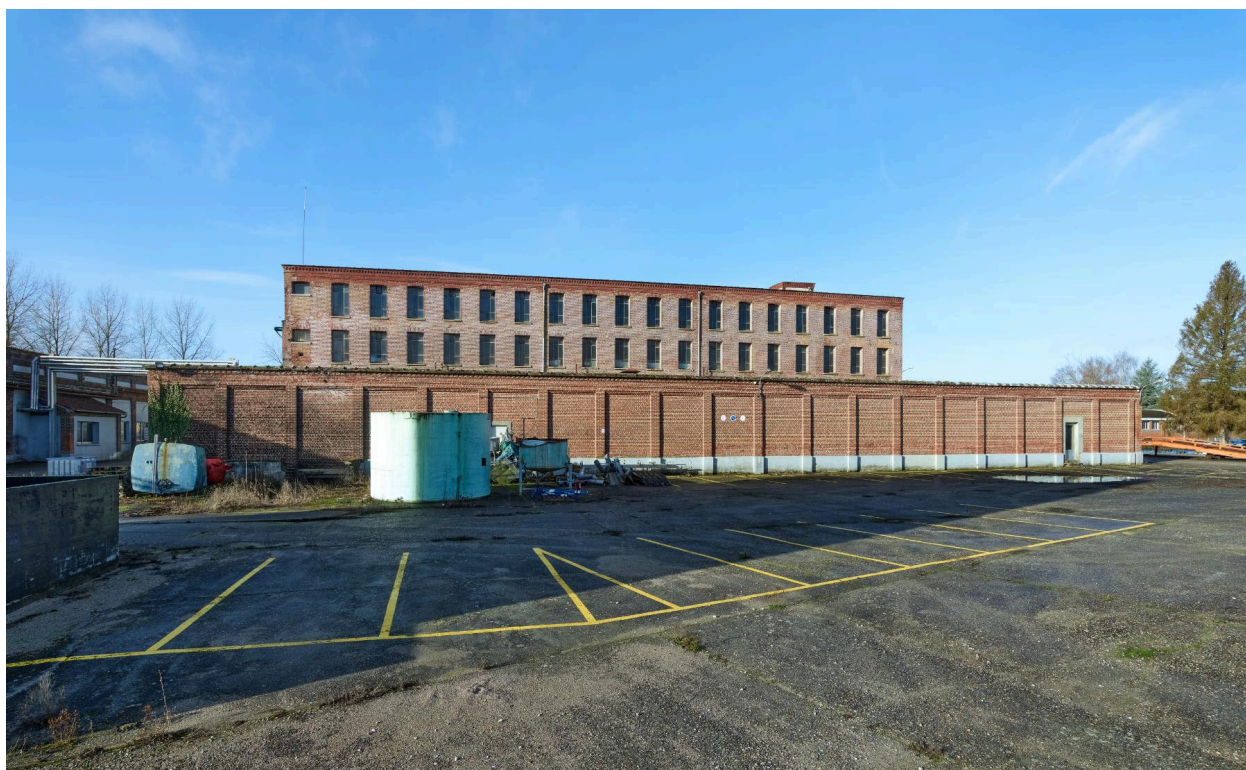
Bâtiment A, vue d'ensemble est.
