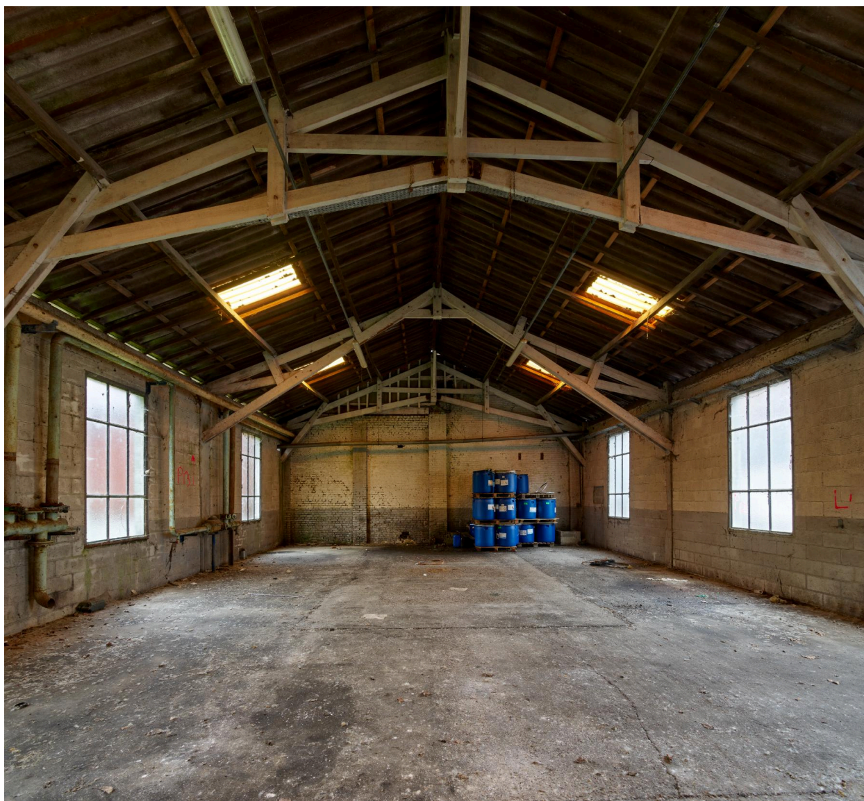
Intérieur de la partie sud d'un des ateliers à charpente apparente (bâtiment M).
