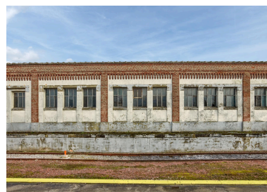
Élévation ouest partielle du magasin (bâtiment K). Phot. Thierry Lefébure IVR32_20238000084NUCA
