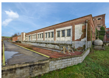
Magasins avec butée de l'embranchement ferroviaire (bâtiment K). Phot. Thierry Lefébure IVR32_20238000082NUCA
