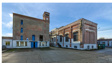
Vue d'ensemble des anciens ateliers de fabrication de la filature et de l'ancienne chaufferie (bâtiment A et K). Phot. Thierry Lefébure IVR32_20238000030NUCA
