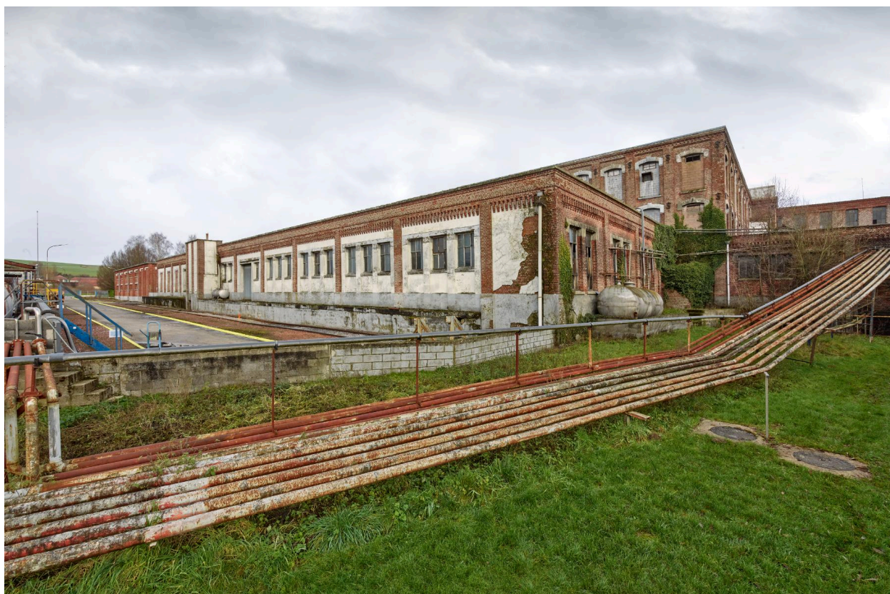
Vue d'ensemble depuis le sud-ouest (bâtiment K, partie basse et haute).
