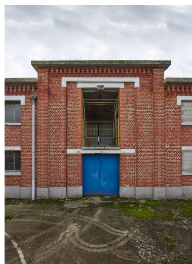
Entrée des entrepôts sur la façade est (bâtiment E). Phot. Thierry Lefébure IVR32_20238000026NUCA
