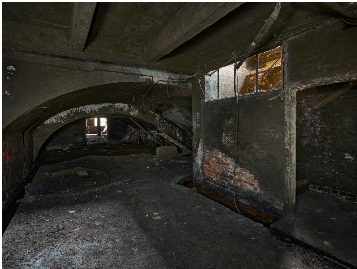
Bâtiment A, vue intérieure du sous-sol communiquant avec le bâtiment K.
