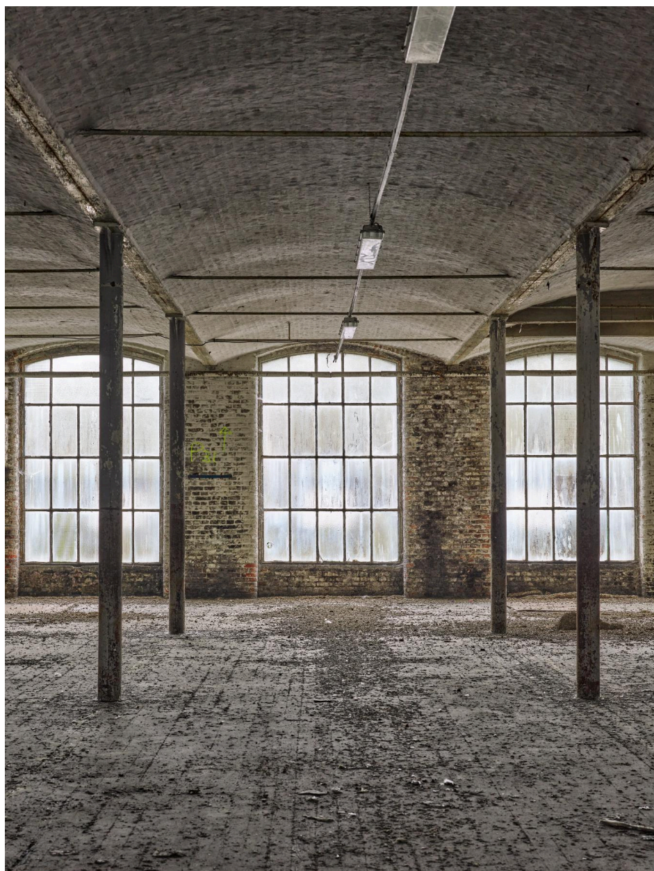
Détail d'une travée du premier étage de l'atelier de fabrication (bâtiment K).
