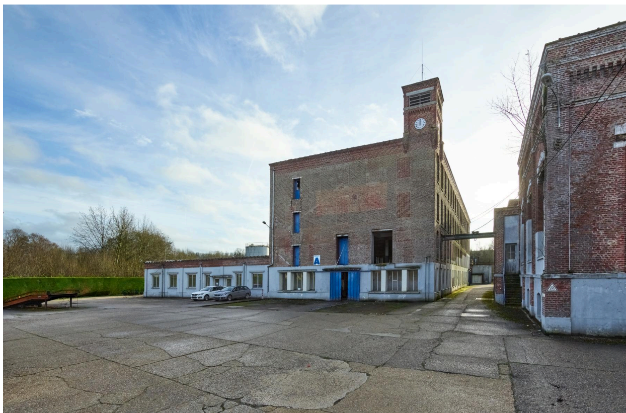
Bâtiment A, vue d'ensemble nord.
