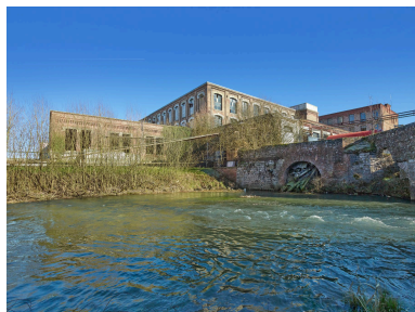
Vue de l'ancienne filature depuis la rive de l'Authie. Phot. Thierry Lefébure IVR32_20238000113NUCA
