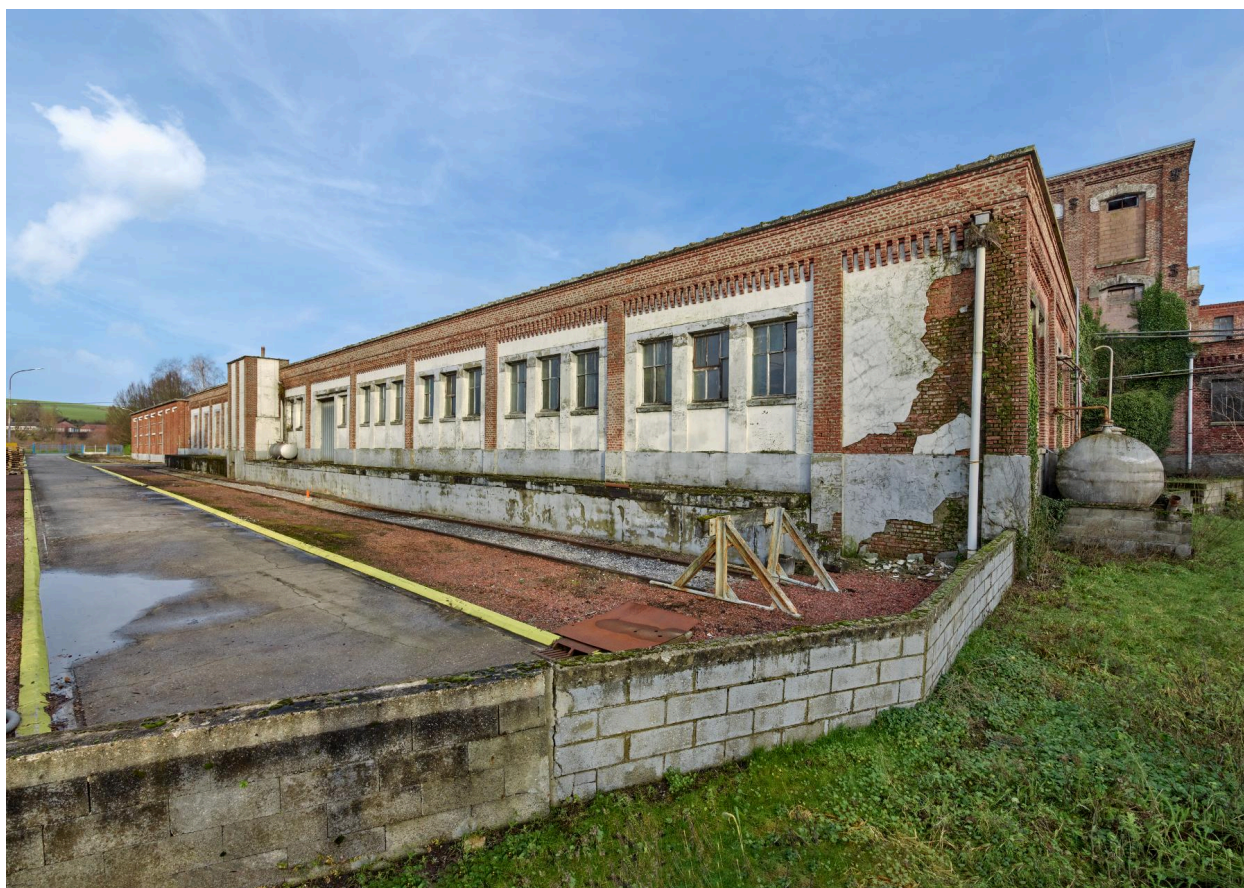
Magasins avec butée de l'embranchement ferroviaire (batiment K).
