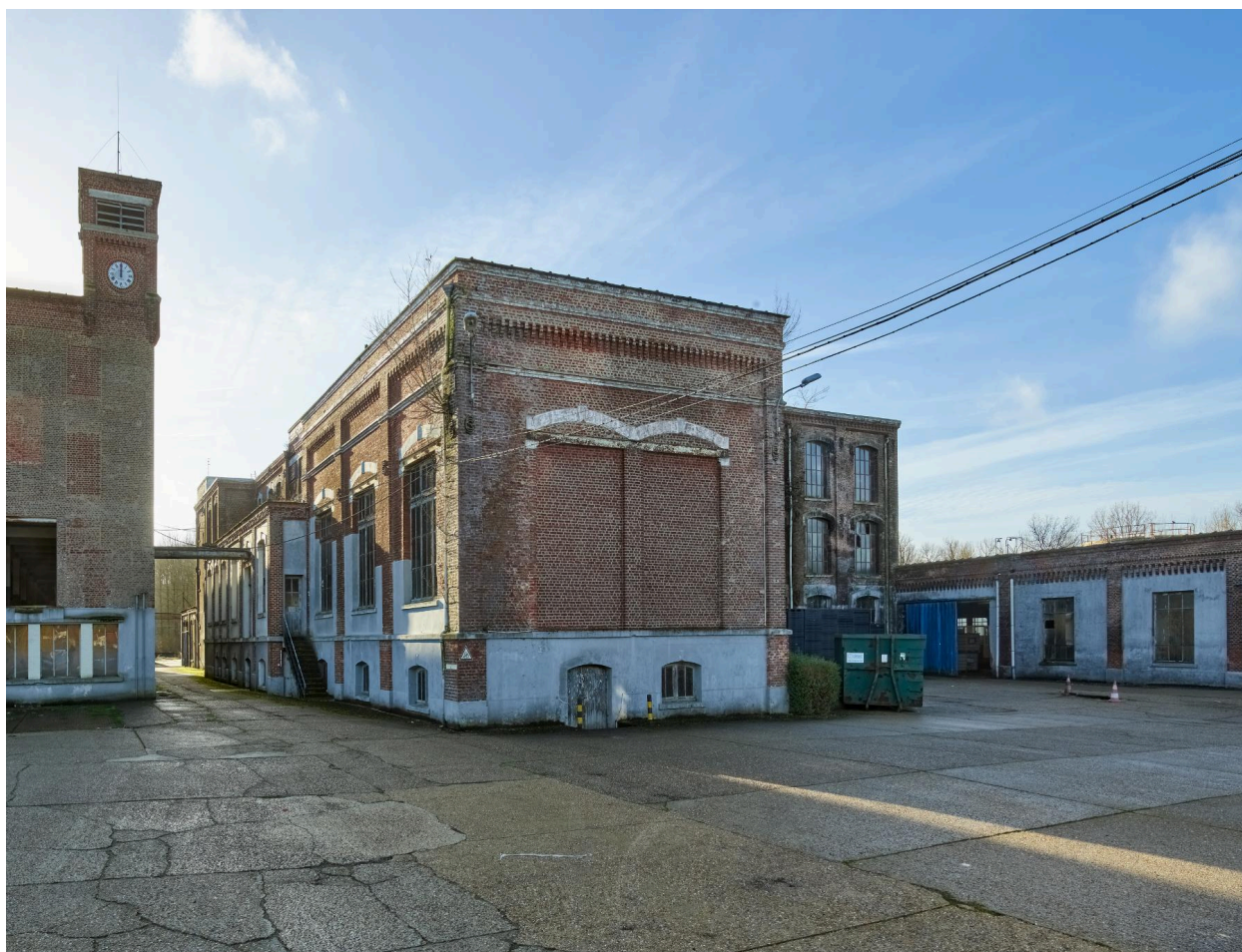
Façade nord de l'ancienne chaufferie (bâtiment K).
