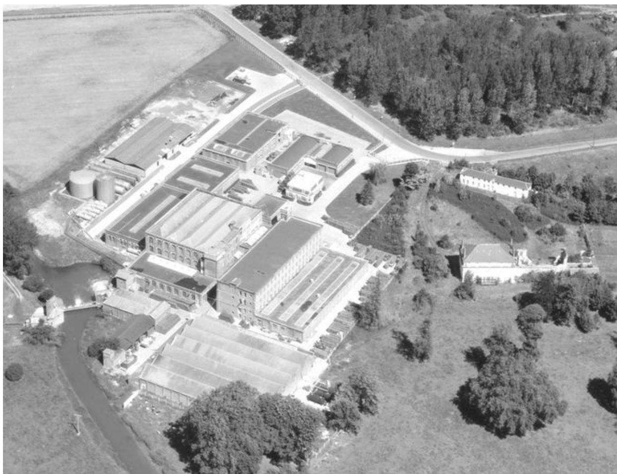
Vue aérienne, vue du flanc sud-est.
