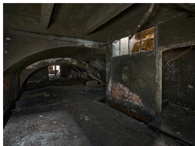
Bâtiment A, vue intérieure du sous-sol communiquant avec le bâtiment K. Phot. Thierry Lefébure IVR32_20238000010NUCA
