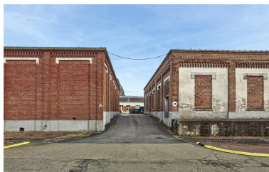
Voie de circulation interne entre les entrepôts et les magasins (bâtiment K et E). Phot. Thierry Lefébure IVR32_20238000086NUCA
