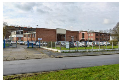
Entrée principale de l'usine. Phot. Thierry Lefébure IVR32_20238000117NUCA
