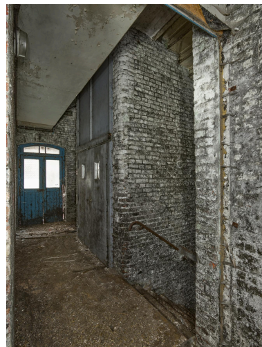
Escalier et monte-charge au deuxième étage de l'atelier de fabrication (bâtiment K). Phot. Thierry Lefébure IVR32_20238000061NUCA
