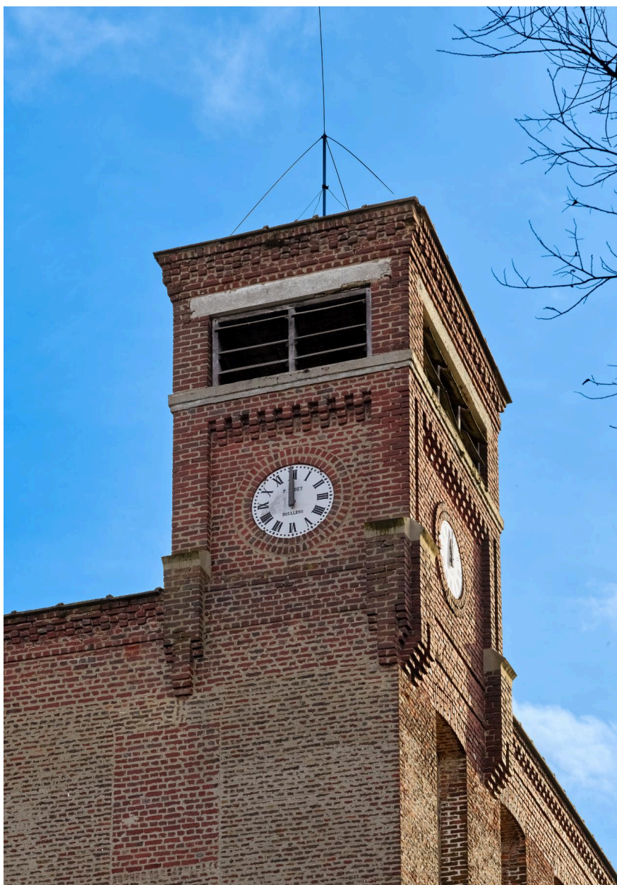
Bâtiment A, détail de l'horloge située à l'angle nord-ouest de l'édifice.
