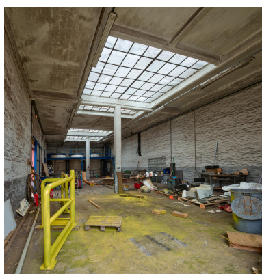
Intérieur des entrepôts (bâtiment E). Phot. Thierry Lefébure IVR32_20238000027NUCA
