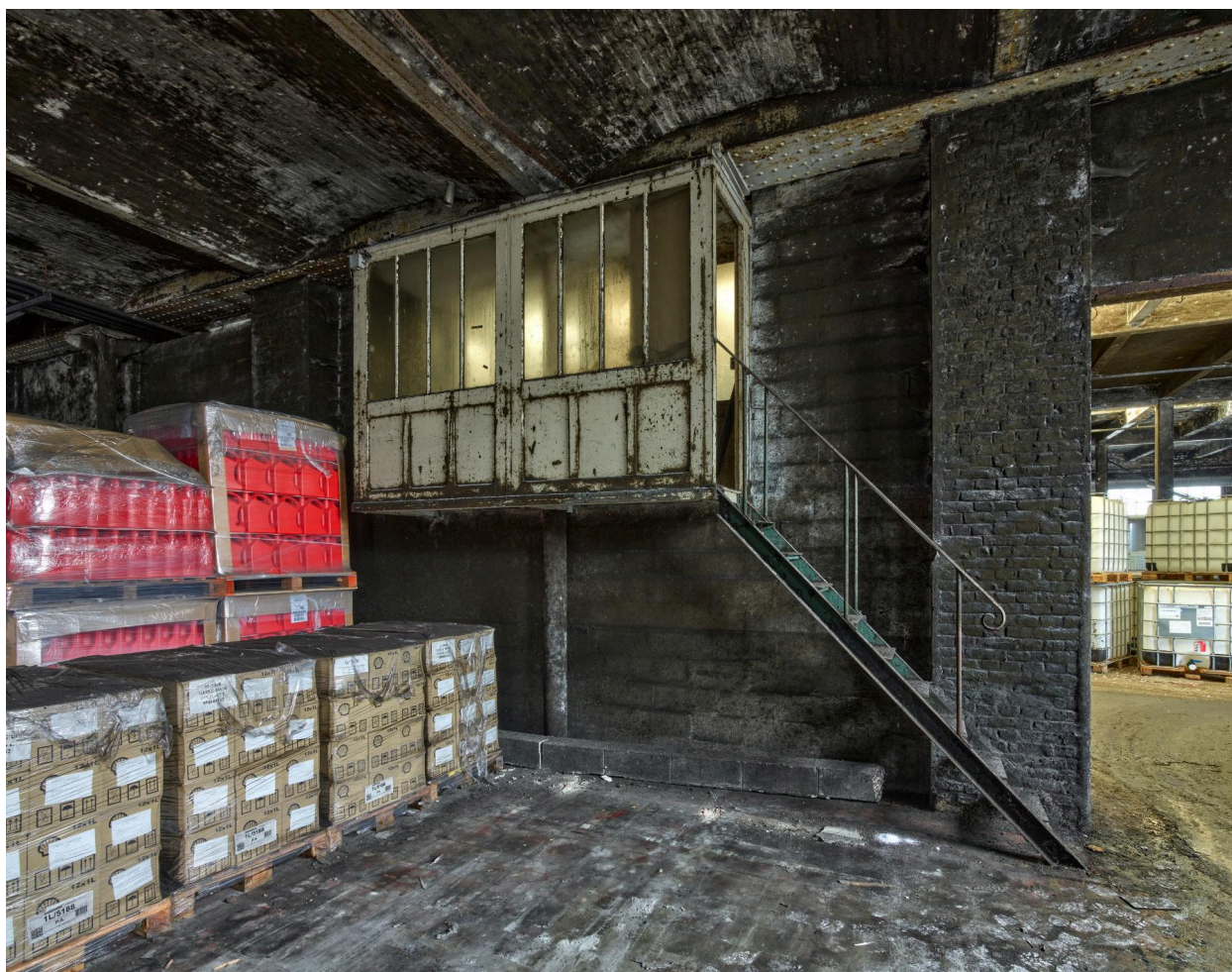
Rez-de chaussée de l'atelier de fabrication (bâtiment K), détail du bureau de contremaître.
