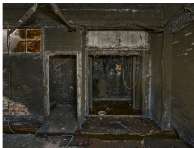
Bâtiment A, monte-charge depuis le sous-sol. Phot. Thierry Lefébure IVR32_20238000011NUCA
