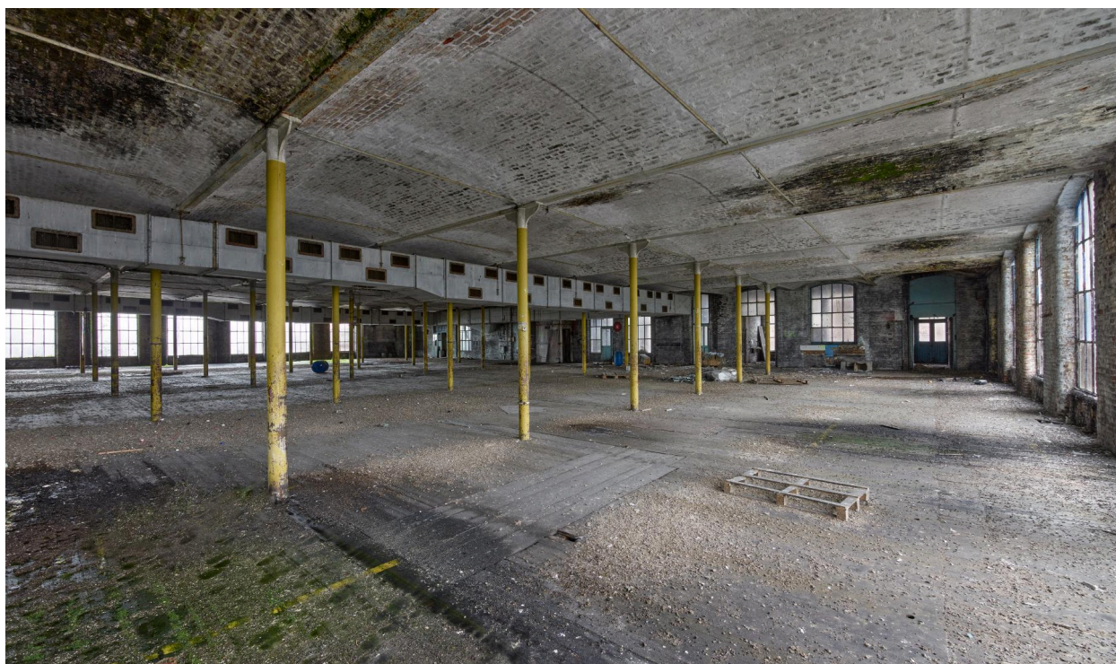
Vue générale du 2e étage de l'atelier de fabrication (bâtiment K).
