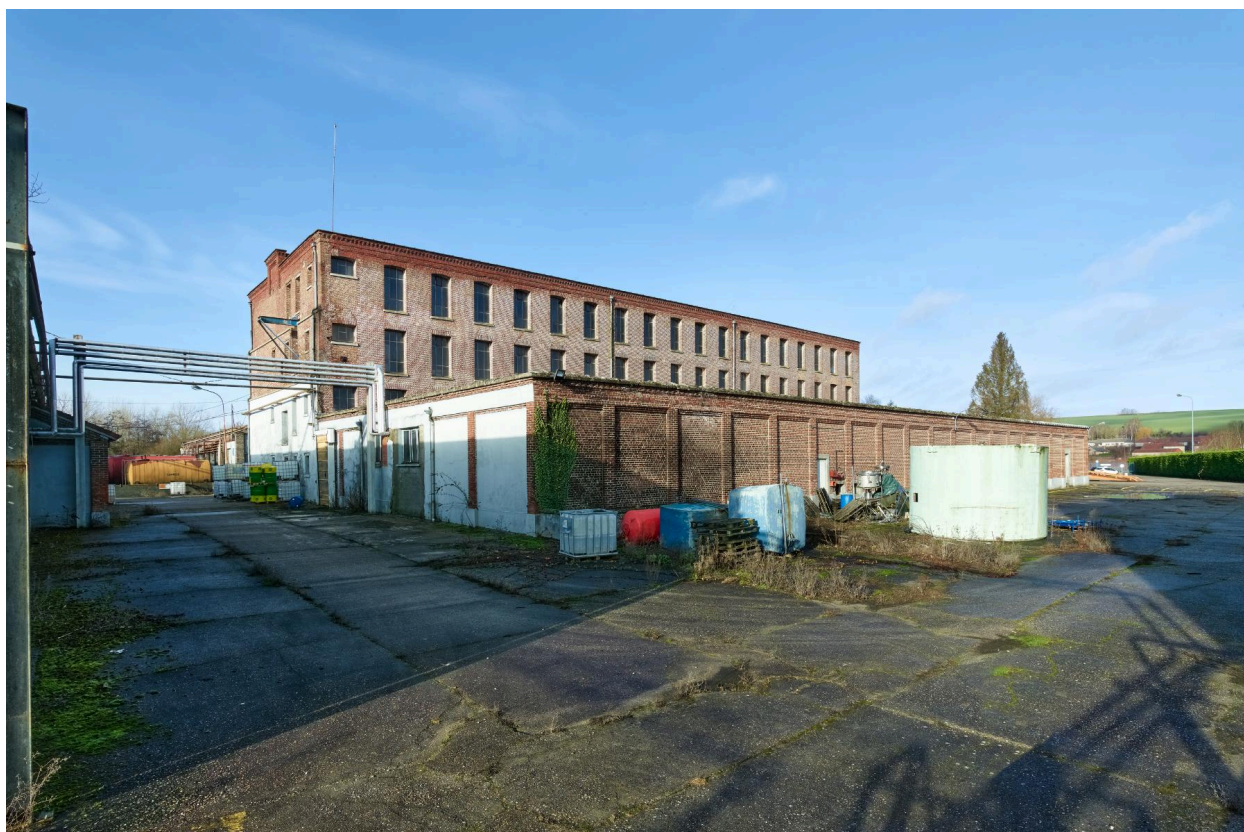
Bâtiment A, vue d'ensemble depuis le sud-est.
