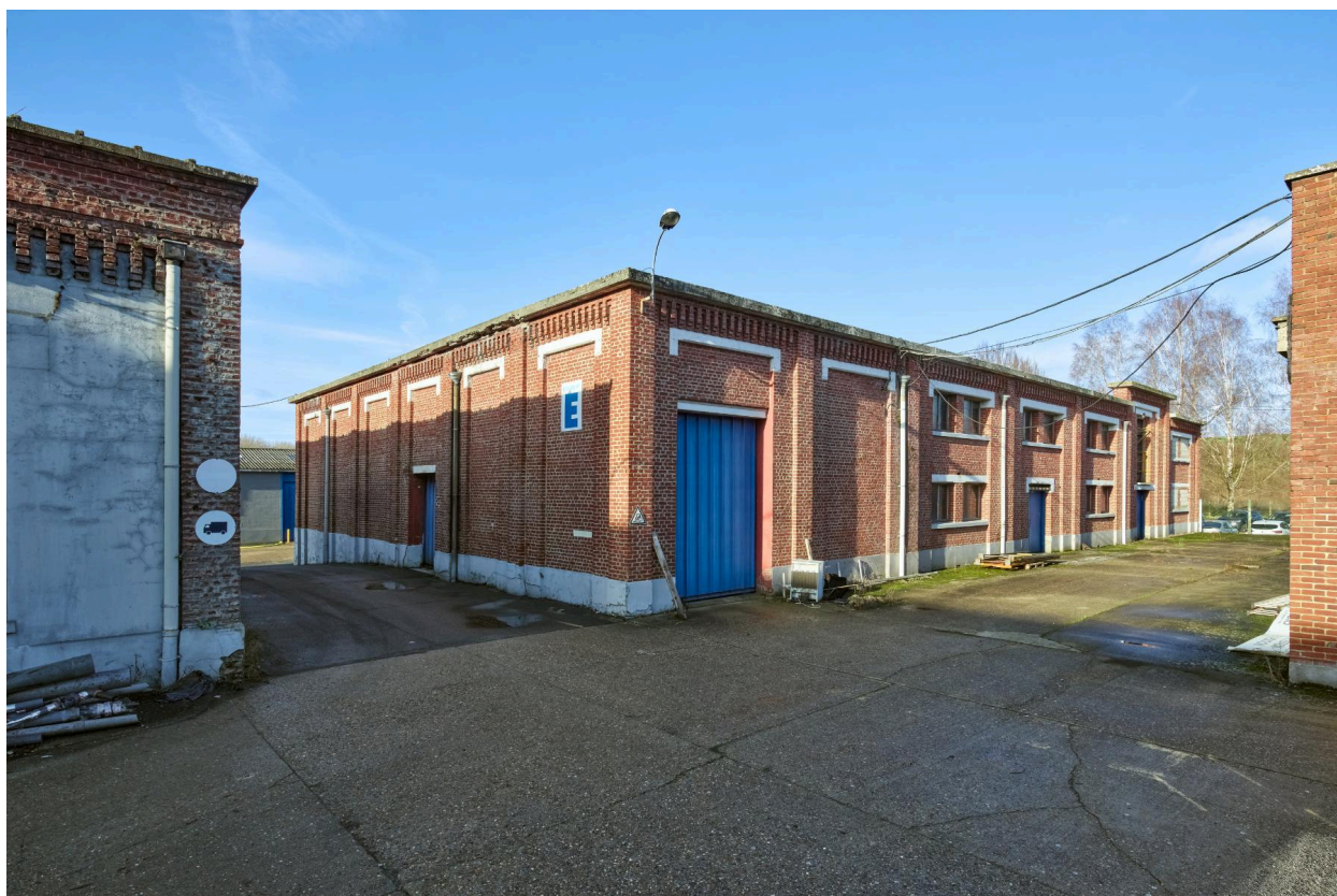
Vue d'ensemble sud-est des entrepôts (bâtiment E).
