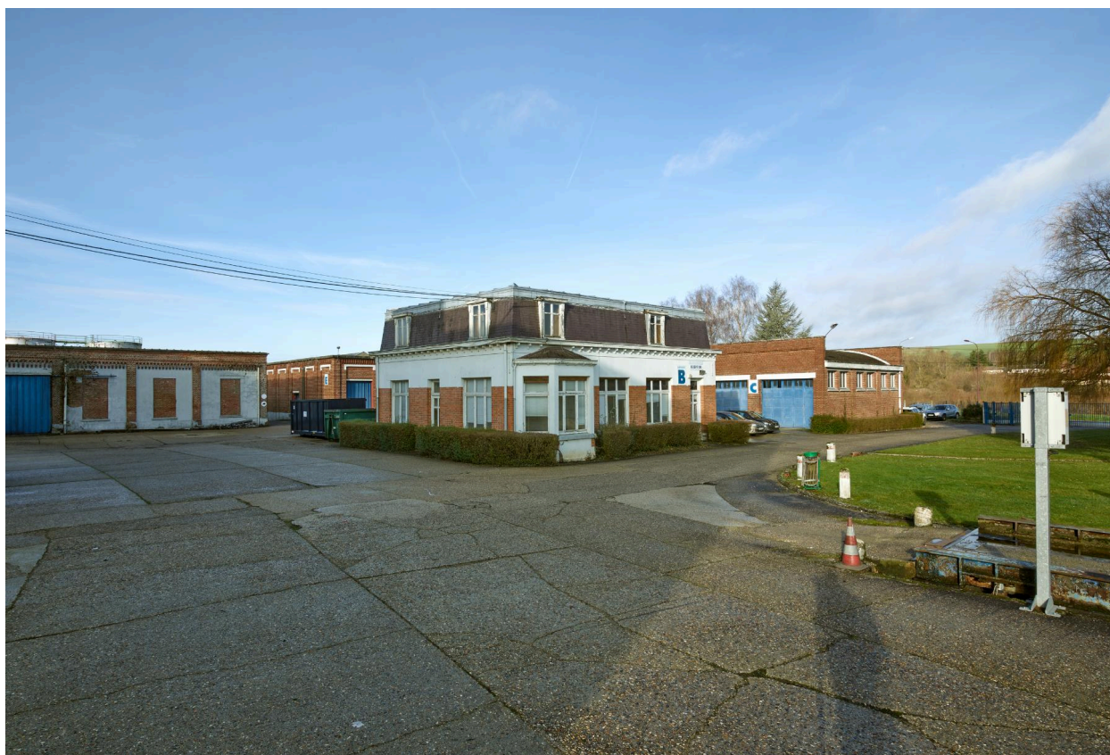
Batiment B, vue d'ensemble des bureaux depuis le sud-est.
