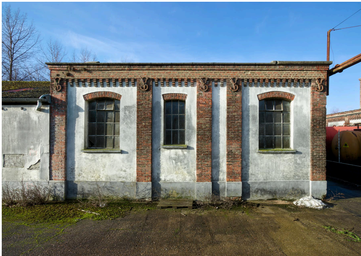
Détail des trois premières travées de la façade est d'un des ateliers portant les initiales VS en fers d'ancrage (bâtiment M).
