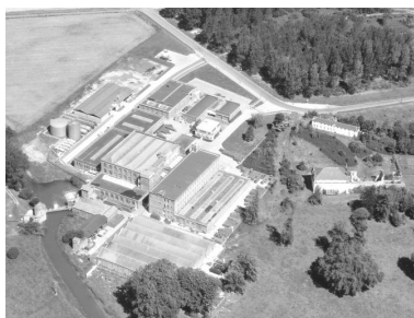
Vue aérienne, vue du flanc sud-est. Phot. Phot'R IVR22_19888001204P
