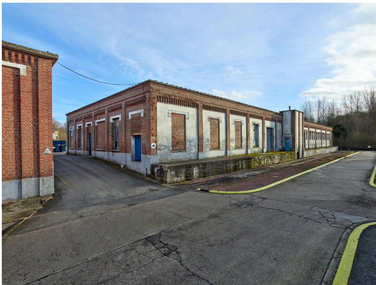
Magasins avec le quai de chargement et l'embranchement ferroviaire à l'avant, vue générale depuis le nord-ouest (bâtiment K).
