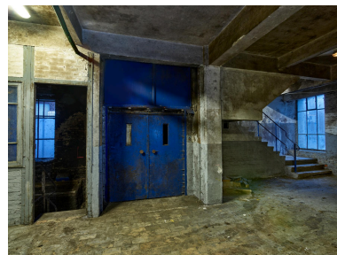
Bâtiment A, monte-charge depuis le rez-de-chaussée. Phot. Thierry Lefébure IVR32_20238000013NUCA
