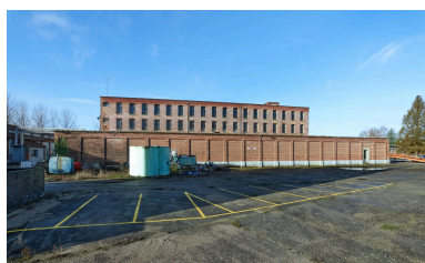
Bâtiment A, vue d'ensemble est. Phot. Thierry Lefébure IVR32_20238000002NUCA
