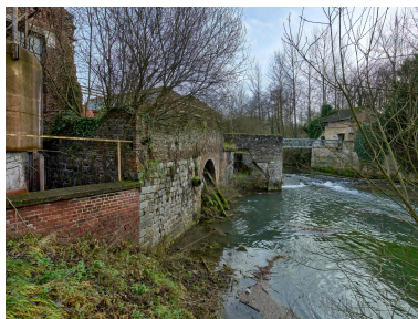
Pont métallique sur l'Authie et coulerie de l'ancien moulin de Rouval. Phot. Thierry Lefébure IVR32_20238000111NUCA
