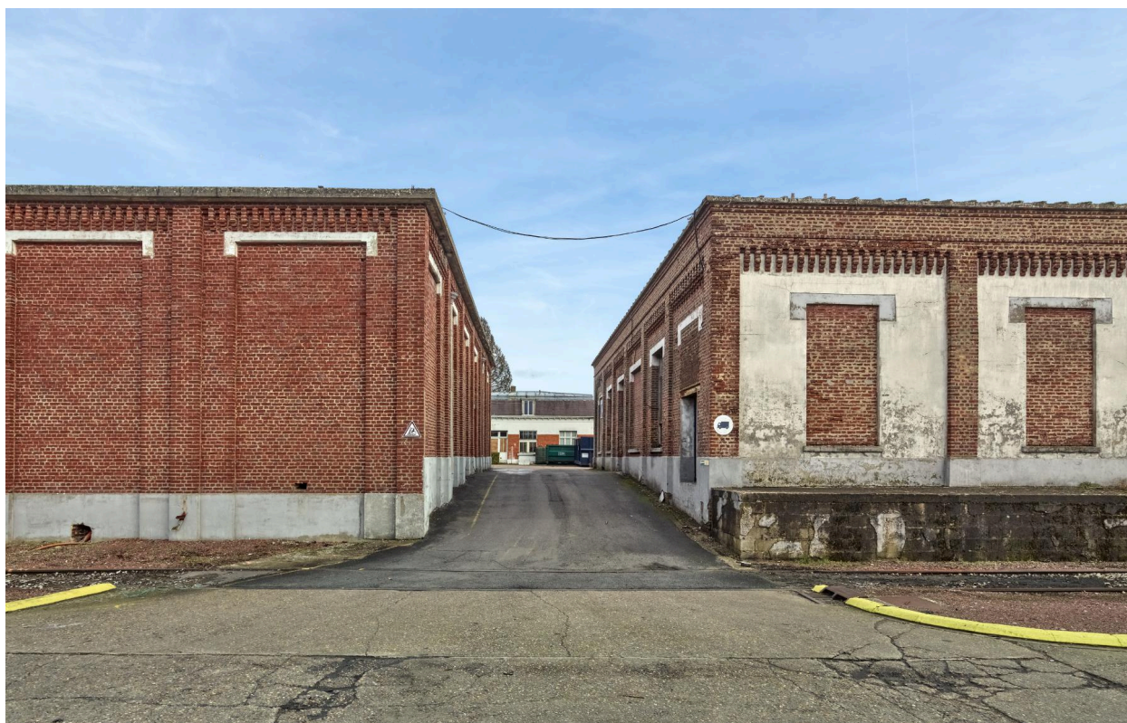
Voie de circulation interne entre les entrepôts et les magasins (bâtiment K et E).
