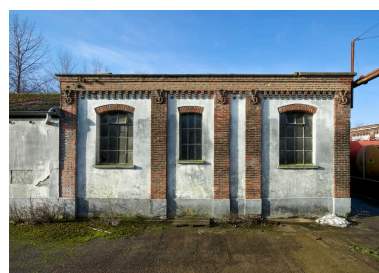
Détail des trois premières travées de la façade est d'un des ateliers portant les initiales VS en fers d'ancrage (bâtiment M). Phot. Thierry Lefébure IVR32_20238000089NUCA
