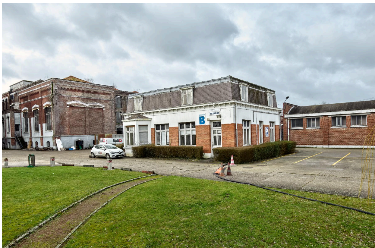
Bâtiment B, vue d'ensemble des bureaux depuis le nord-est.
