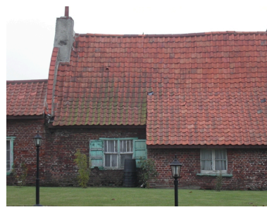
Détail de la façade postérieure du logis ; huisserie à croisée de bois. Phot. Cyril Cailleau IVR31_20055907429NUCA
