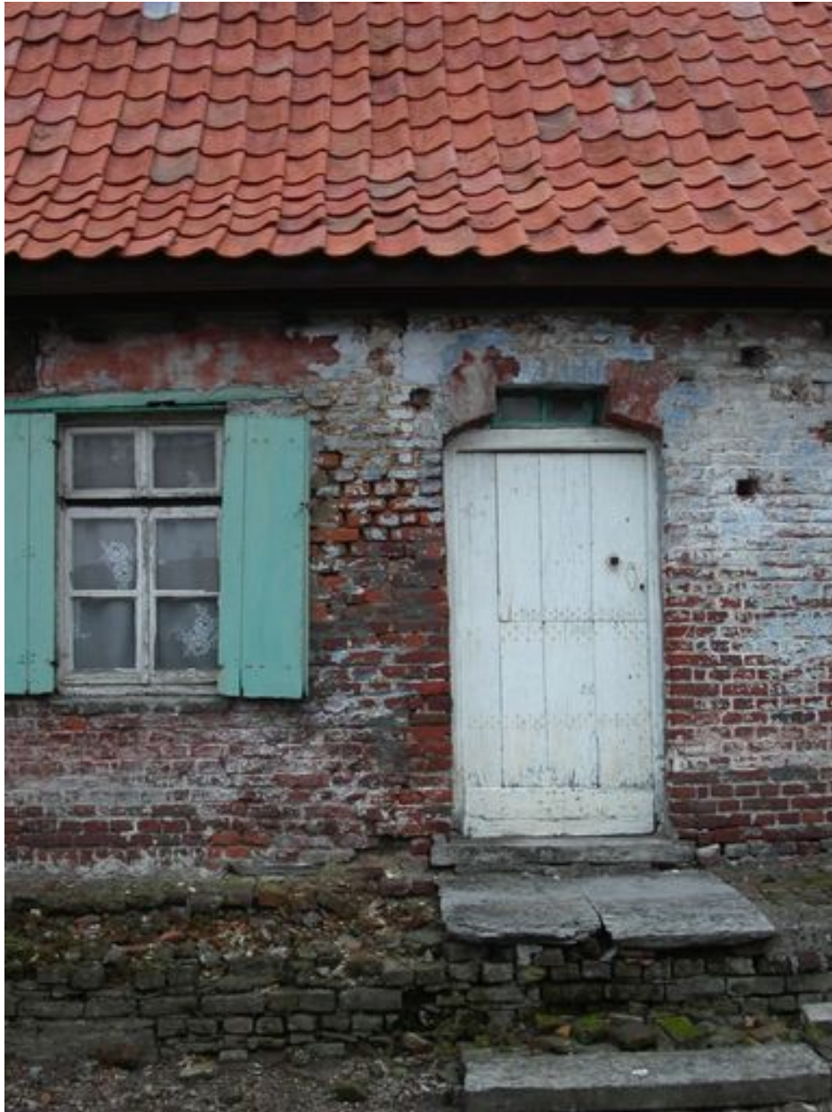
Détail de la façade sur cour du logis ; porte d'entrée.
