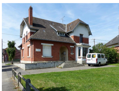
L'ancien logement de la directrice de l'école maternelle. Phot. Isabelle Barbedor IVR32_20170205510NUCA
