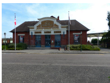
L'ancienne salle des fêtes. Phot. Isabelle Barbedor IVR32_20170205483NUCA
