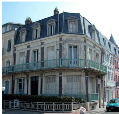
Vue d'ensemble depuis l'esplanade. Phot. Elisabeth Justome IVR22_20038005259NUCA
