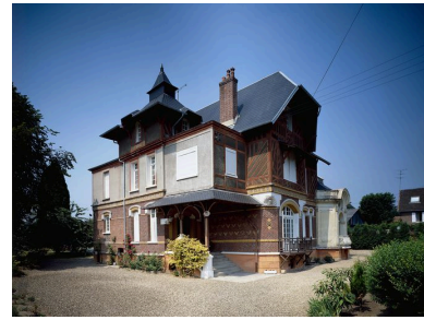
Elévation antérieure. Phot. Fabrice Charrondière IVR22_19866000109VA
