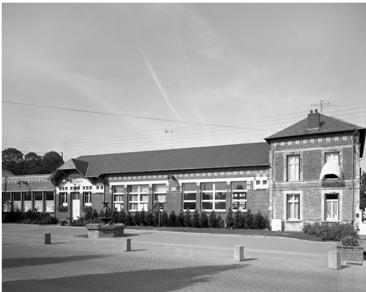
Vue d'ensemble de la façade.
