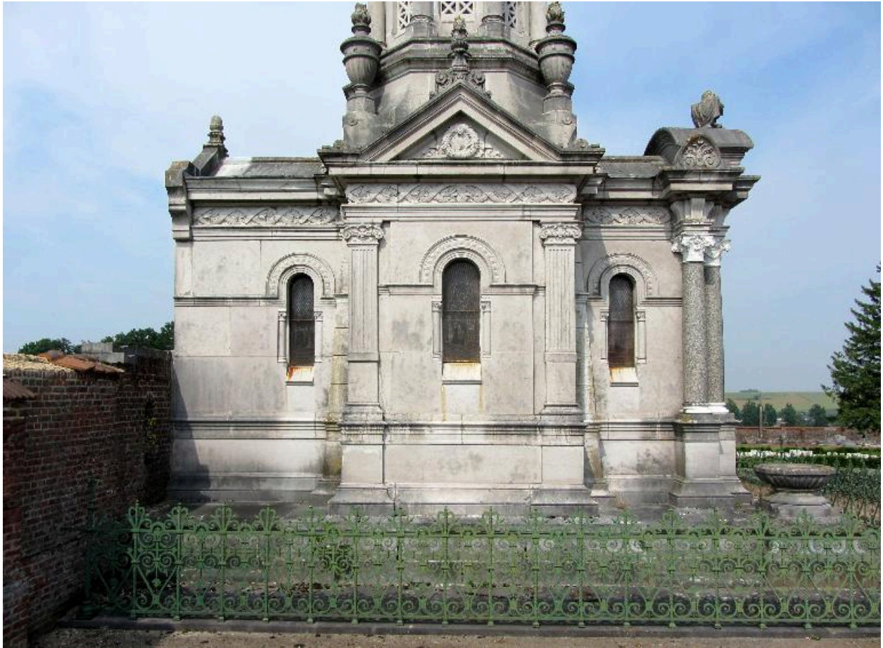
Elevation inférieure du monument, côté gauche.
