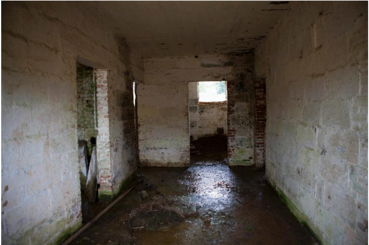
Abri casernement : vue intérieure.
