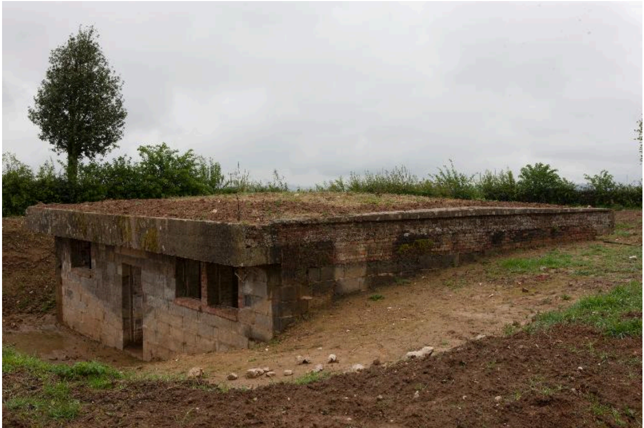
Abri casernement : vue postérieure.
