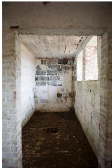
Abri casernement : vue intérieure. Phot. Pierre Thibaut IVR31_20126201697NUCA
