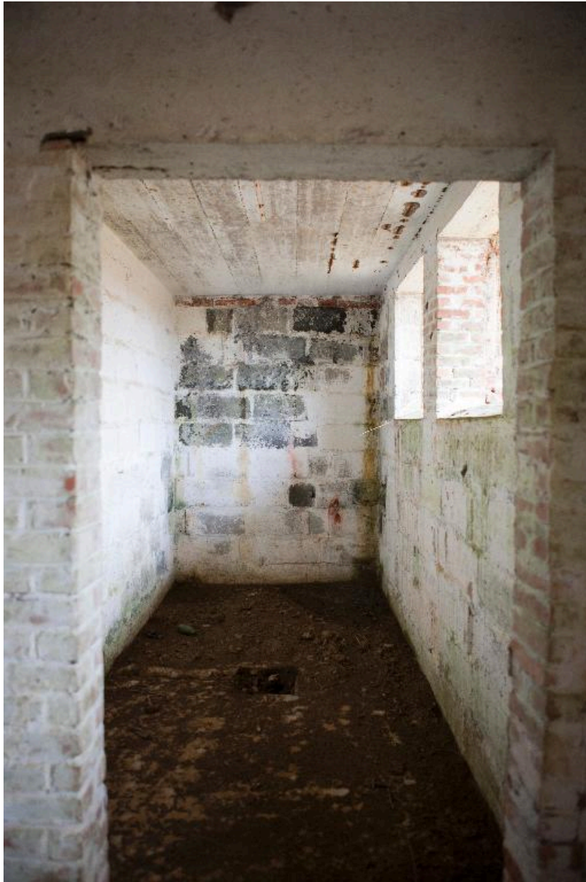
Abri casernement : vue intérieure.
