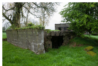
Bâtiment de stockage des réactifs chimiques. Angle sud-est. Phot. Pierre Thibaut IVR31_20126201681NUCA
