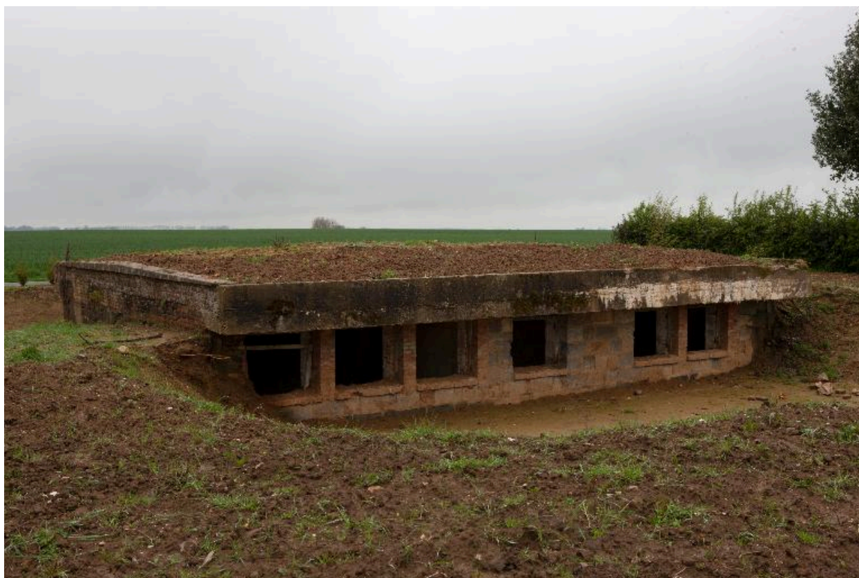
Abri casernement : vue antérieure.
