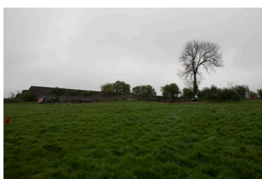
Murs de protection de la rampe de lancement : vue générale. Phot. Pierre Thibaut IVR31_20126201656NUCA
