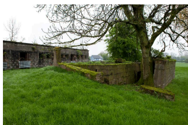
Bâtiment de stockage des réactifs chimiques. A l'arrière- plan, le bâtiment de montage. Phot. Pierre Thibaut IVR31_20126201679NUCA
