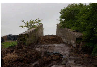
Murs de protection de la rampe de lancement : vue de face.
