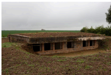
Abri casernement : vue antérieure. Phot. Pierre Thibaut IVR31_20126201691NUCA
