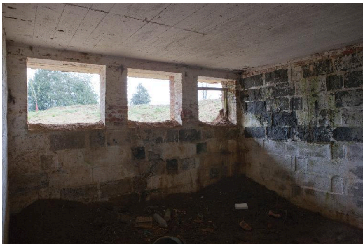
Abri casernement : vue intérieure.
