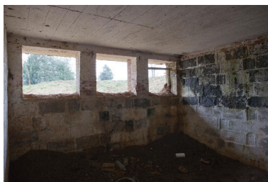
Abri casernement : vue intérieure. Phot. Pierre Thibaut IVR31_20126201700NUCA
