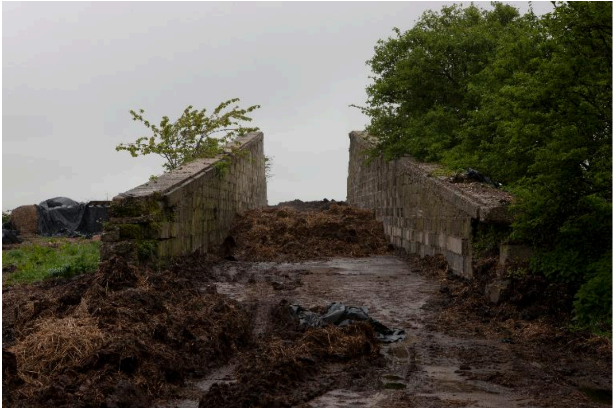
Murs de protection de la rampe de lancement : vue de face.
