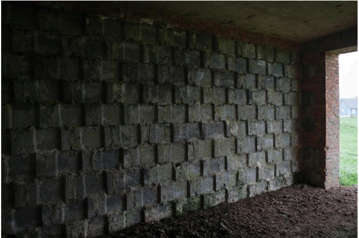
Vue intérieure du bâtiment de montage.
