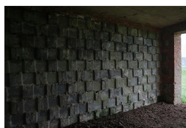
Vue intérieure du bâtiment de montage. Phot. Pierre Thibaut IVR31_20126201675NUCA
