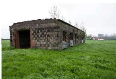
Bâtiment de montage. Vue générale prise depuis le nord-ouest. Phot. Pierre Thibaut IVR31_20126201678NUCA
