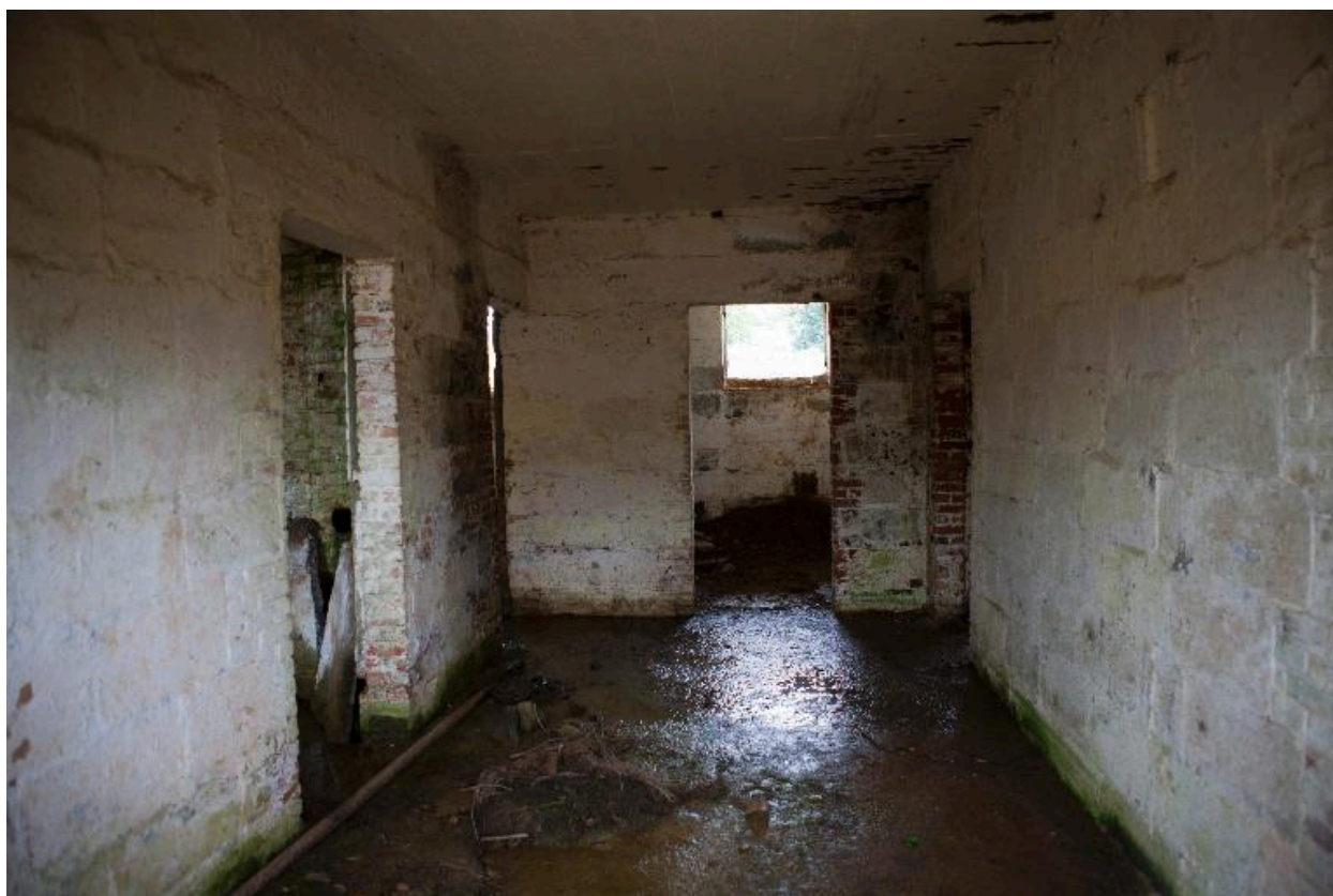
Abri casernement : vue intérieure.
