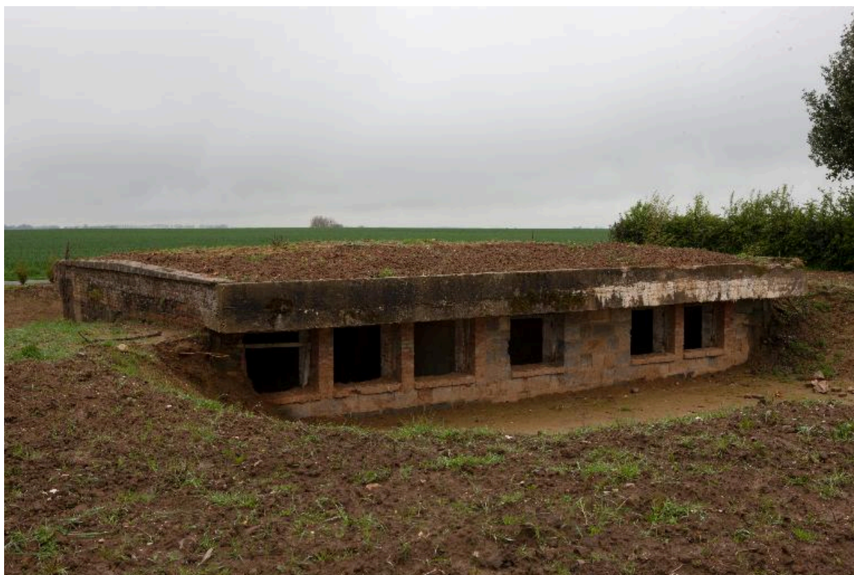
Abri casernement : vue antérieure.
