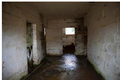
Abri casernement : vue intérieure. Phot. Pierre Thibaut IVR31_20126201696NUCA
