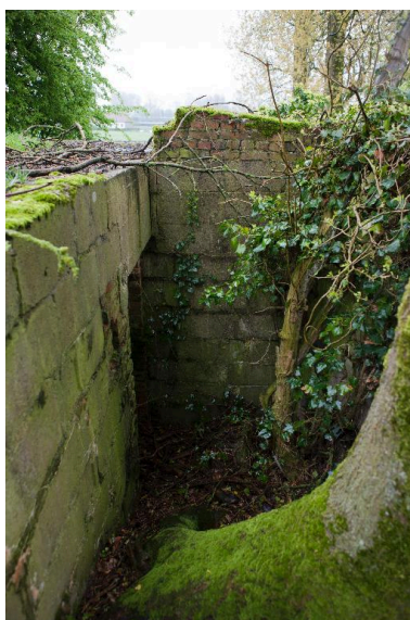
Bâtiment de stockage des réactifs chimiques : détail de l'entrée semi-enterrée. Phot. Pierre Thibaut IVR31_20126201680NUCA
