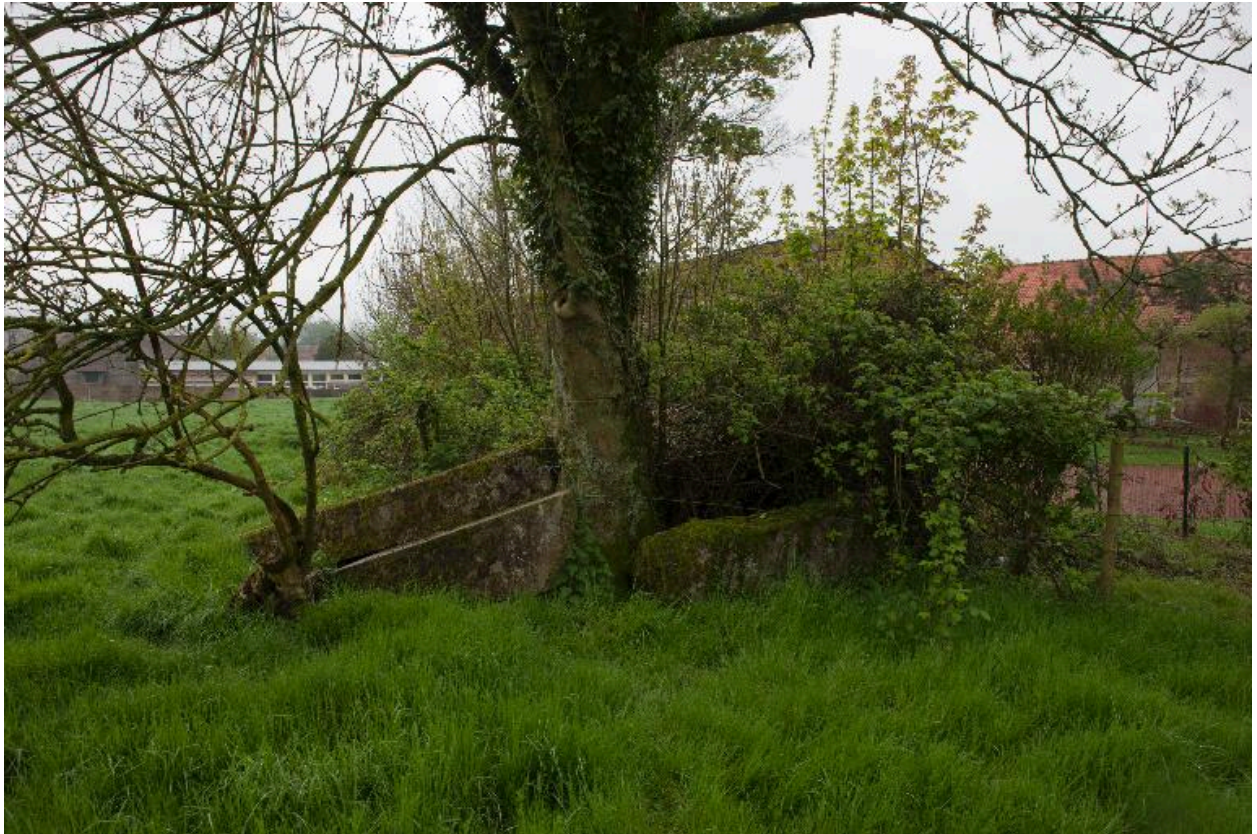
Bâtiment de stockage d'attente.
