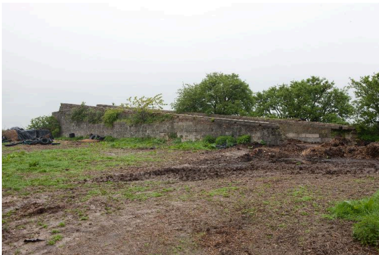
Murs de protection de la rampe de lancement : vue latérale.
