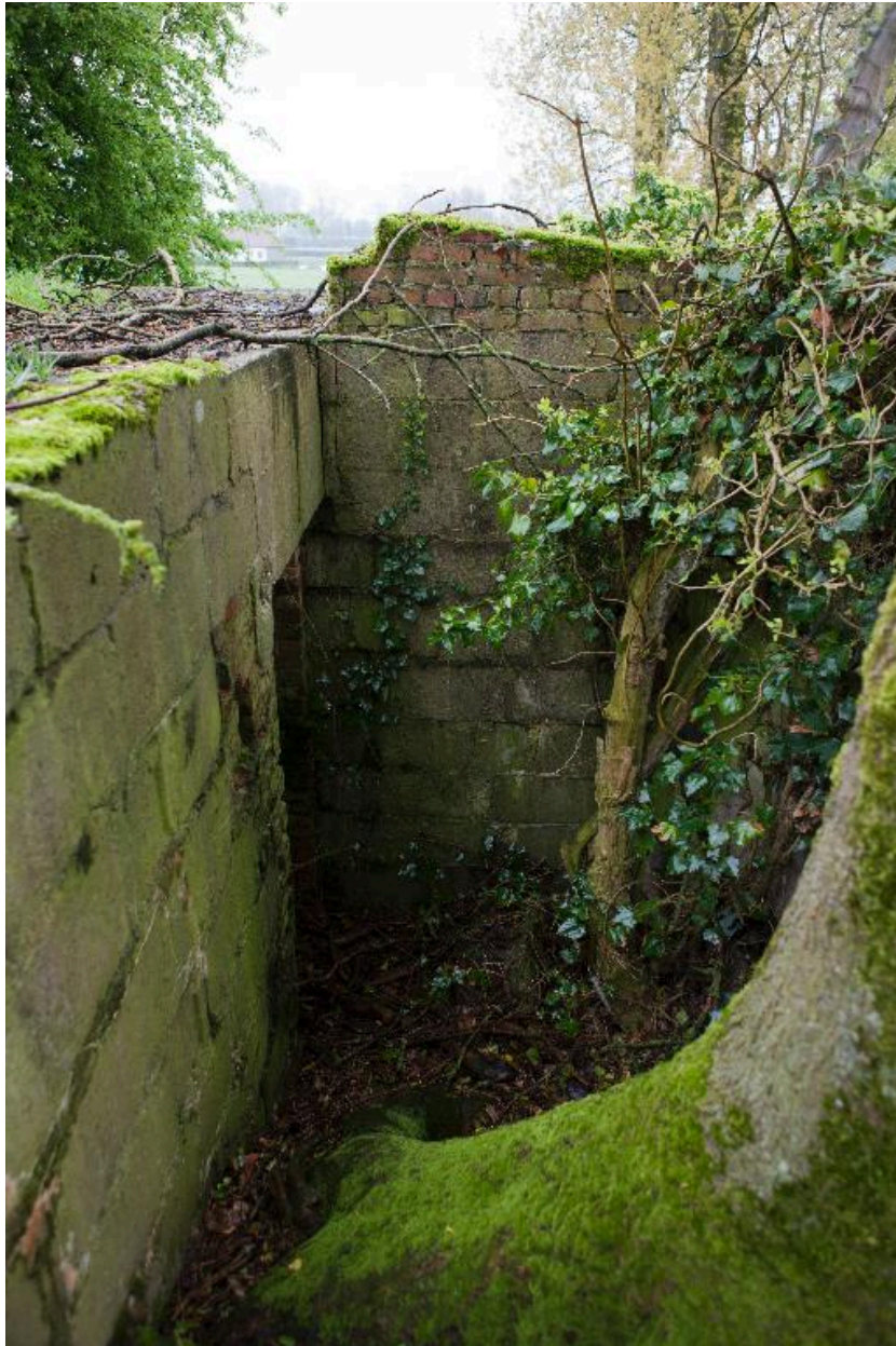
Bâtiment de stockage des réactifs chimiques : détail de l'entrée semi-enterrée.
