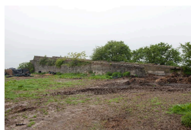
Murs de protection de la rampe de lancement : vue latérale. Phot. Pierre Thibaut IVR31_20126201653NUCA
