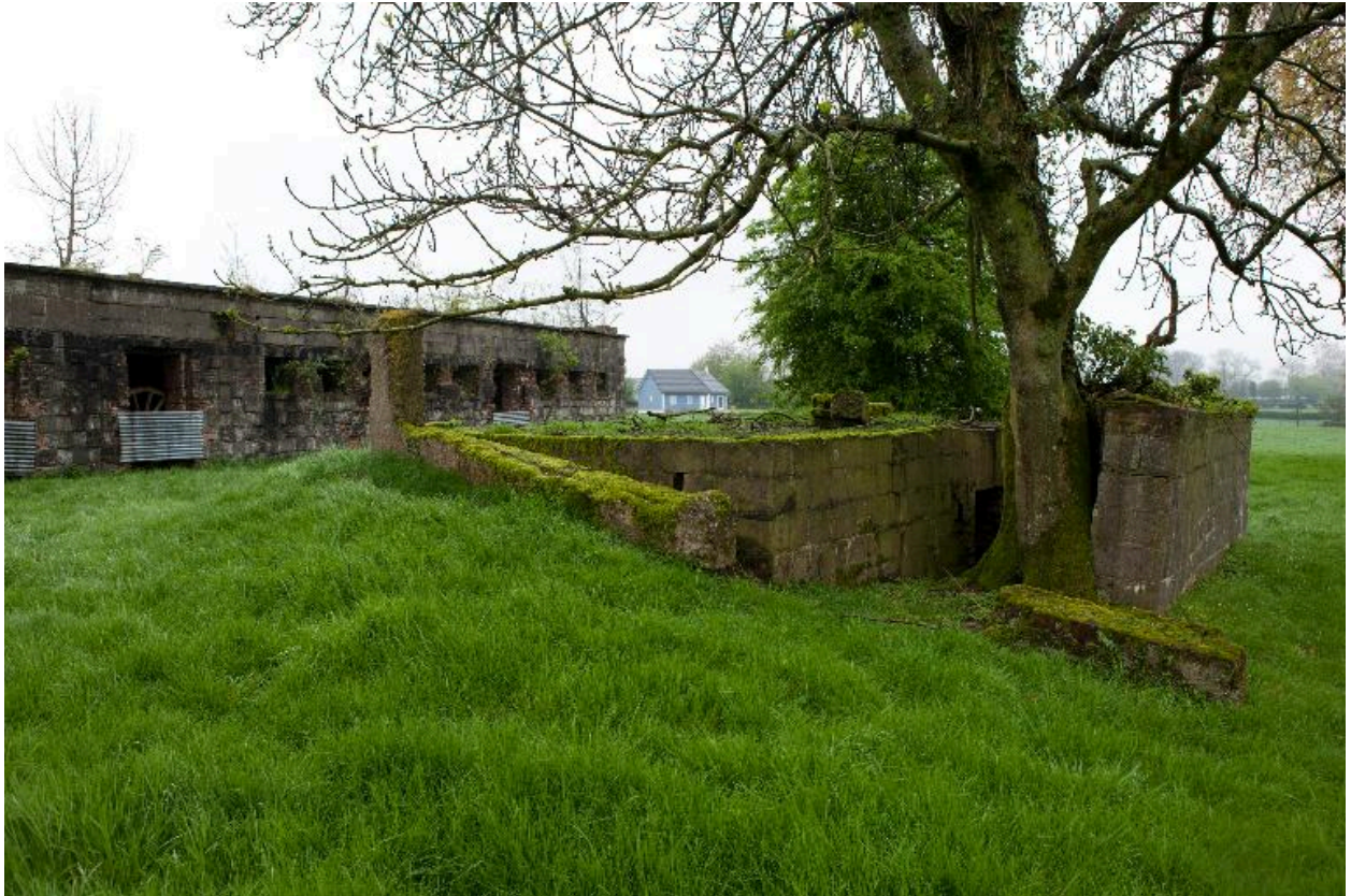
Bâtiment de stockage des réactifs chimiques. A l'arrière-plan, le bâtiment de montage.
