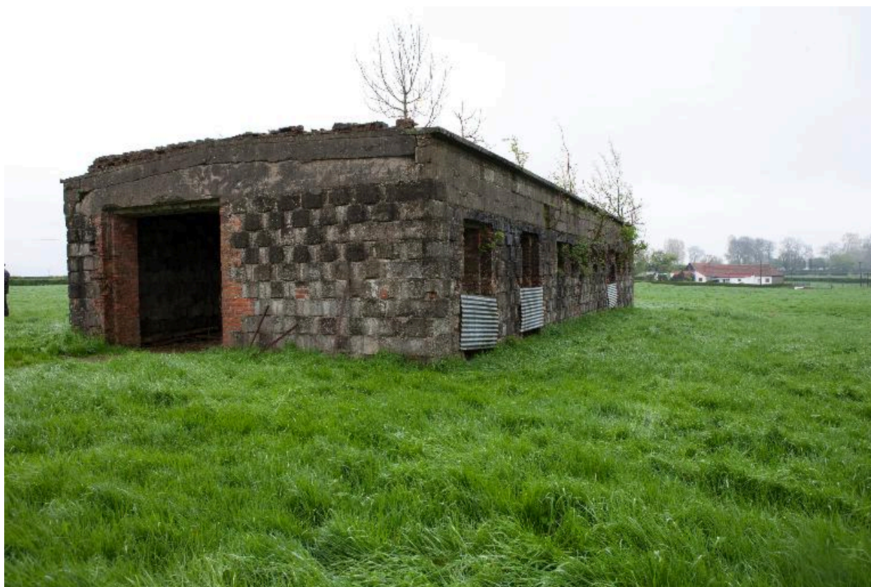
Bâtiment de montage. Vue générale prise depuis le nord-ouest.
