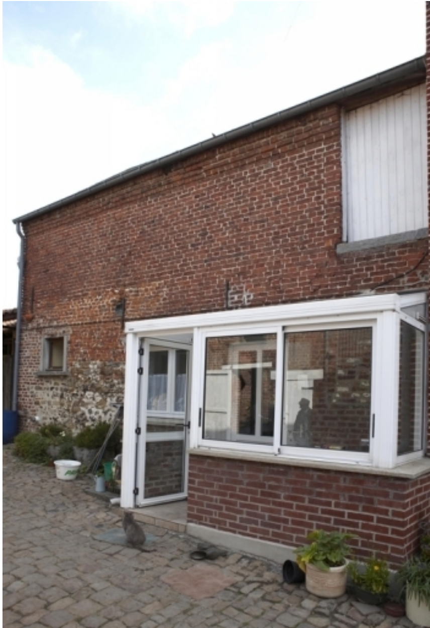
Vue de l'ancienne étable-fenil, transformée en logement.
