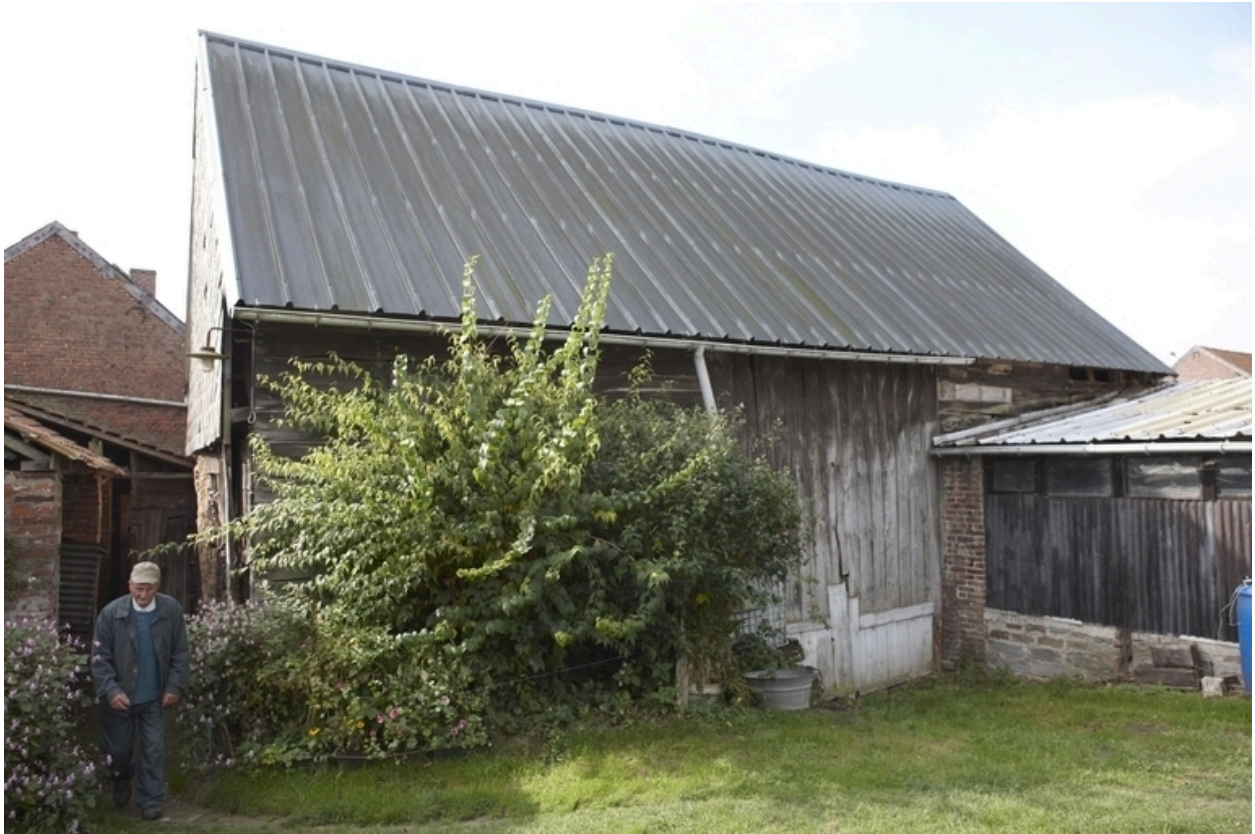
Vue du revers de la grange.
