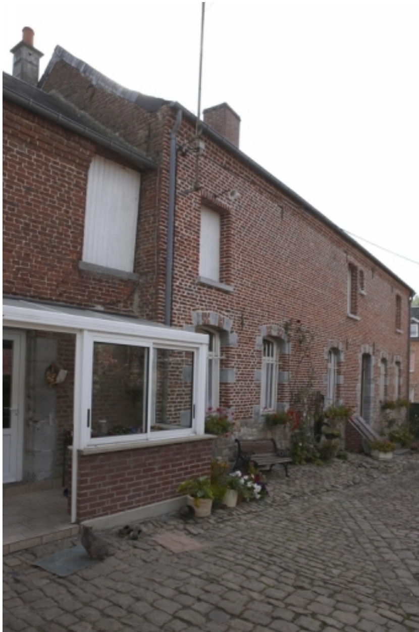
Vue de l'ancienne étable-fenil, transformée en logement.
