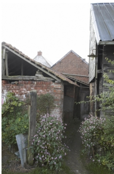
Vue du passage entre le logis et la grange. Phot. Pierre Thibaut IVR31_20095903276NUCA
