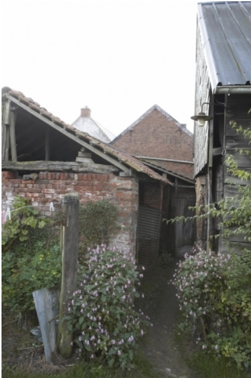
Vue du passage entre le logis et la grange.
