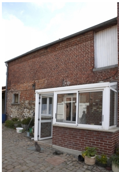
Vue de l'ancienne étable- fenil, transformée en logement. Phot. Pierre Thibaut IVR31_20095903272NUCA
