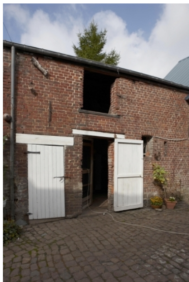
Vue de la seconde étable-fenil. Phot. Pierre Thibaut IVR31_20095903274NUCA
