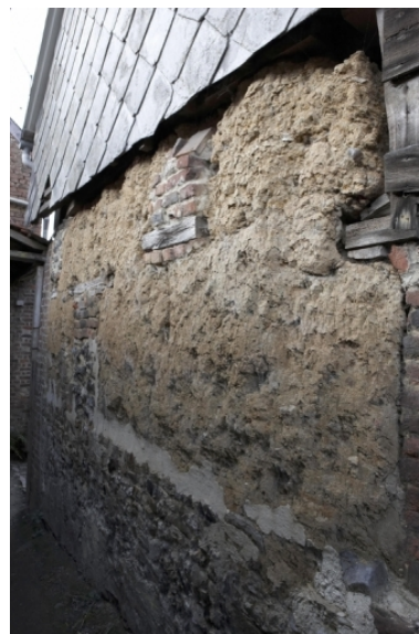
Détail de la maçonnerie du pignon est de la grange. Phot. Pierre Thibaut IVR31_20095903277NUCA
