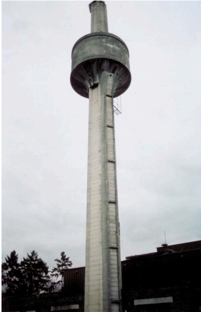
Cheminée de la chaufferie. Château d'eau.
