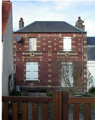
Vue d'ensemble avant travaux. Phot. Elisabeth Justome IVR22_20058002629NUCA
