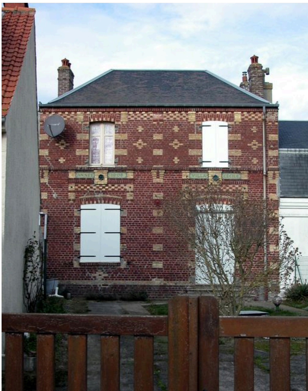
Vue d'ensemble avant travaux.
