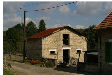
Vue de la grange postérieure au logis. Phot. Inès Guérin IVR22_20030202034NUCA
