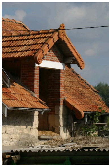
Détail de la lucarne. Phot. Inès Guérin IVR22_20030202036NUCA
