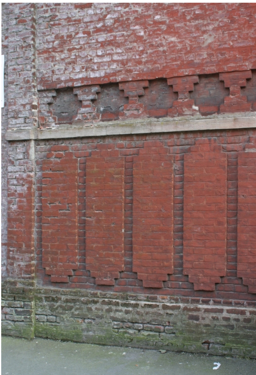
Détail de l'appareillage des briques.
