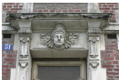
Maison d'habitation : détail. Phot. Frédéric Pillet IVR22_20050205598NUCA
