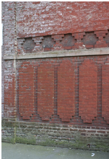
Détail de l'appareillage des briques. Phot. Frédéric Pillet IVR22_20050205141NUCA
