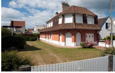
Vue générale. Phot. Pierre Thibaut IVR31_20146202174NUCA
