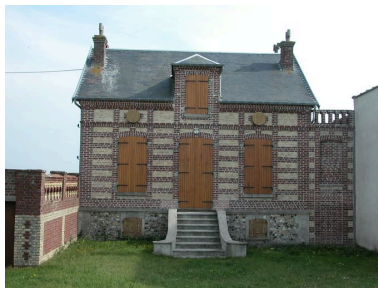
Élévation antérieure. Phot. Elisabeth Justome IVR22_20058002650NUCA
