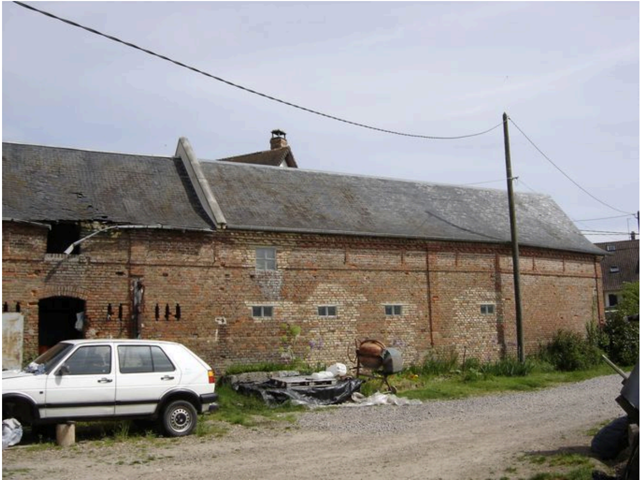
Vue des bâtiments de stockage.
