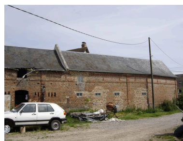
Vue des bâtiments de stockage. Phot. Inès Guérin IVR22_20058005788NUCA
