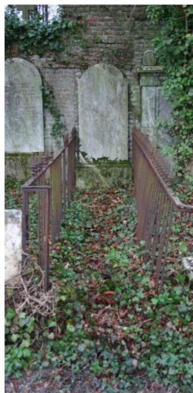
Concession de type couloir et stèle d'applique, milieu 19e siècle (L 104). Phot. Caroline Vincent IVR22_20068001810NUCA
