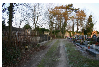
Vue générale d'une allée de desserte, jouxtant le mur d'enceinte extérieur, vers le deuxième mur d'enceinte intérieure, au nord. Phot. Caroline Vincent IVR22_20098001696NUCA
