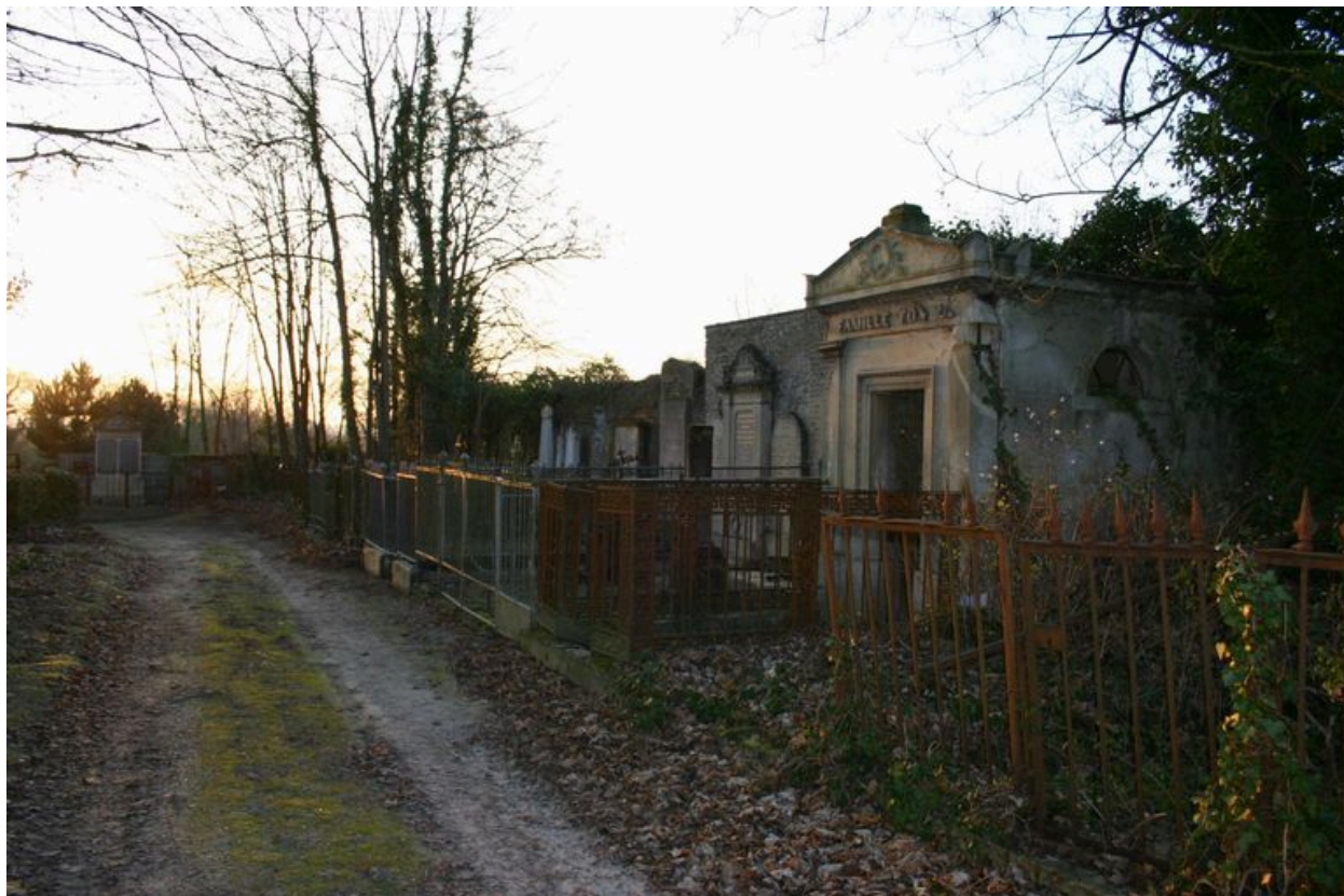
Vue générale du mur d'enceinte extérieur, vers le premier mur d'enceinte intérieur, au sud.
