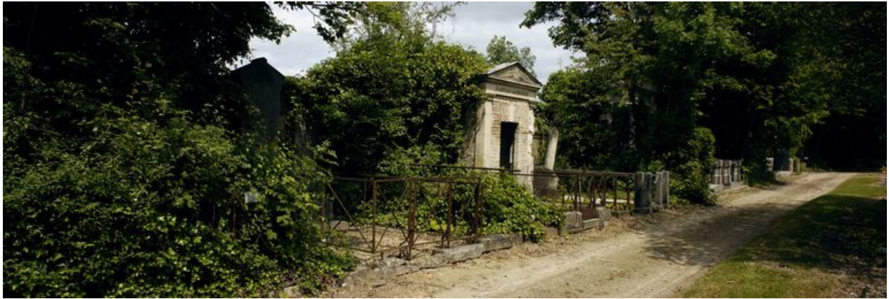
L'allée desservant les concessions adossées au mur ouest, vue depuis le sud.
