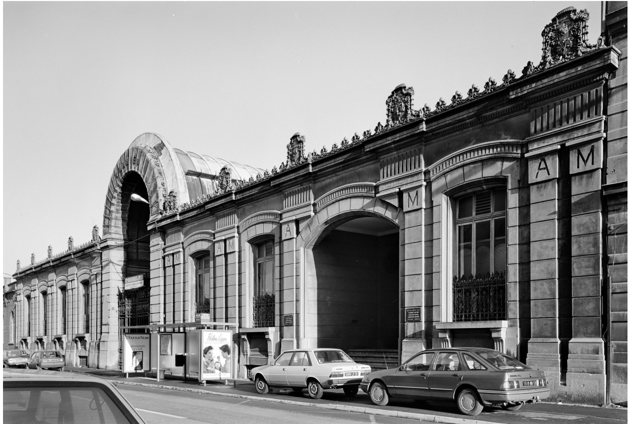
Élévation antérieure rue de la Gare.
