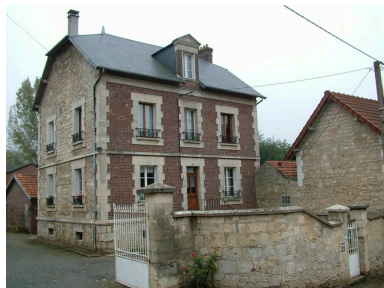
Vue générale du logis. Phot. Irwin Leullier IVR22_20050201052NUCA
