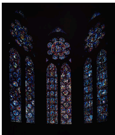
Vue d'ensemble des verrières de la chapelle d'axe (baie 1 à gauche).
