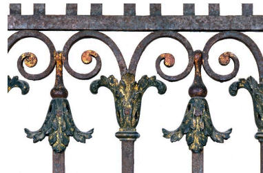
Détail de la grille. Phot. Laurent Jumel IVR22_19966004055ZA
