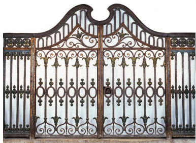
Vue de détail : la porte de la clôture. Phot. Laurent Jumel IVR22_19966004053ZA
