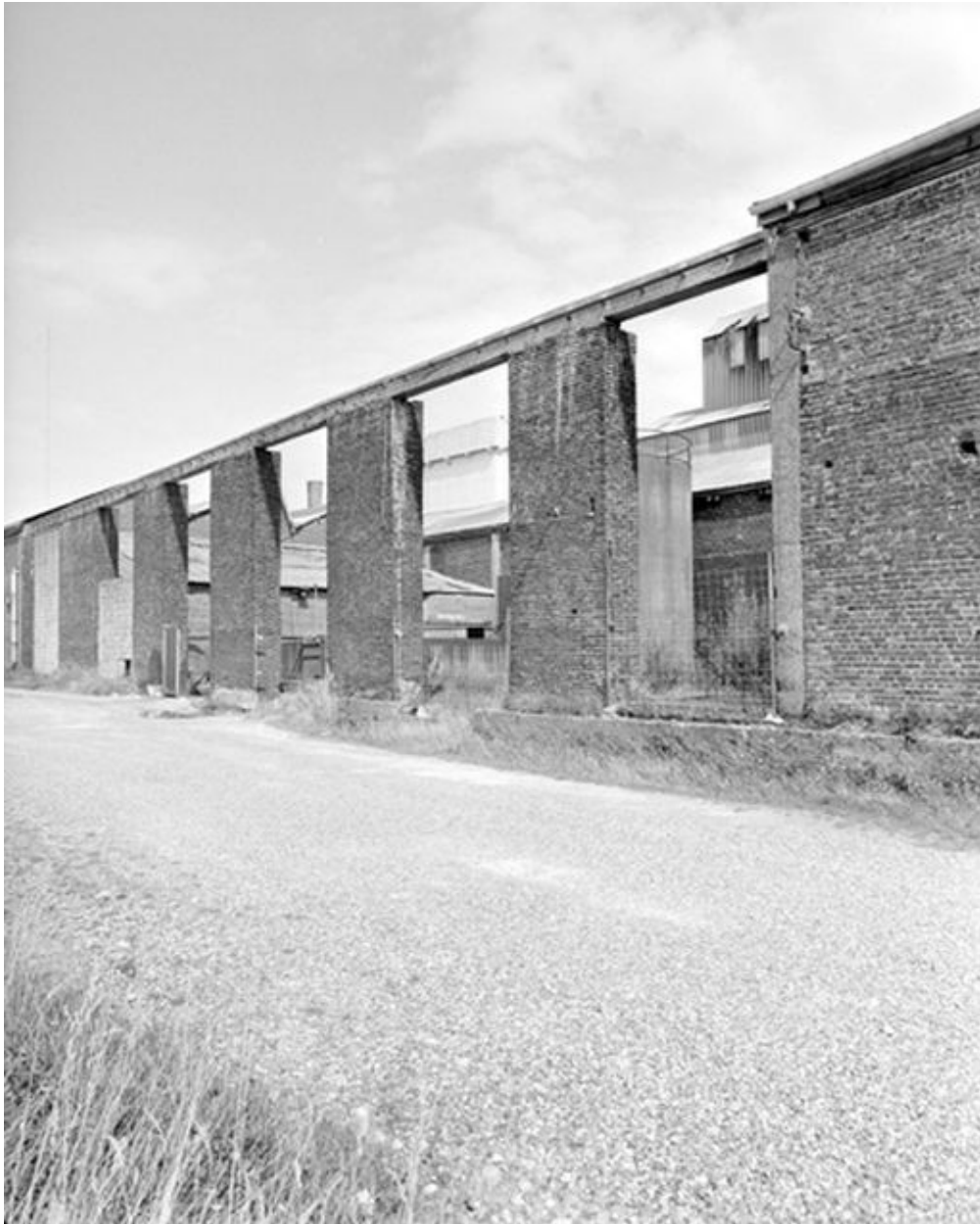
Vue partielle des ateliers de fabrication.
