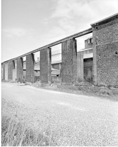
Vue partielle des ateliers de fabrication. Phot. Thierry Lefébure IVR22_19888000926X
