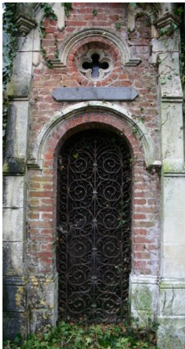
Détail de la façade principale, percée d'une porte cintrée en fonte et fer forgé. Phot. Caroline Vincent IVR22_20078000392NUCA
