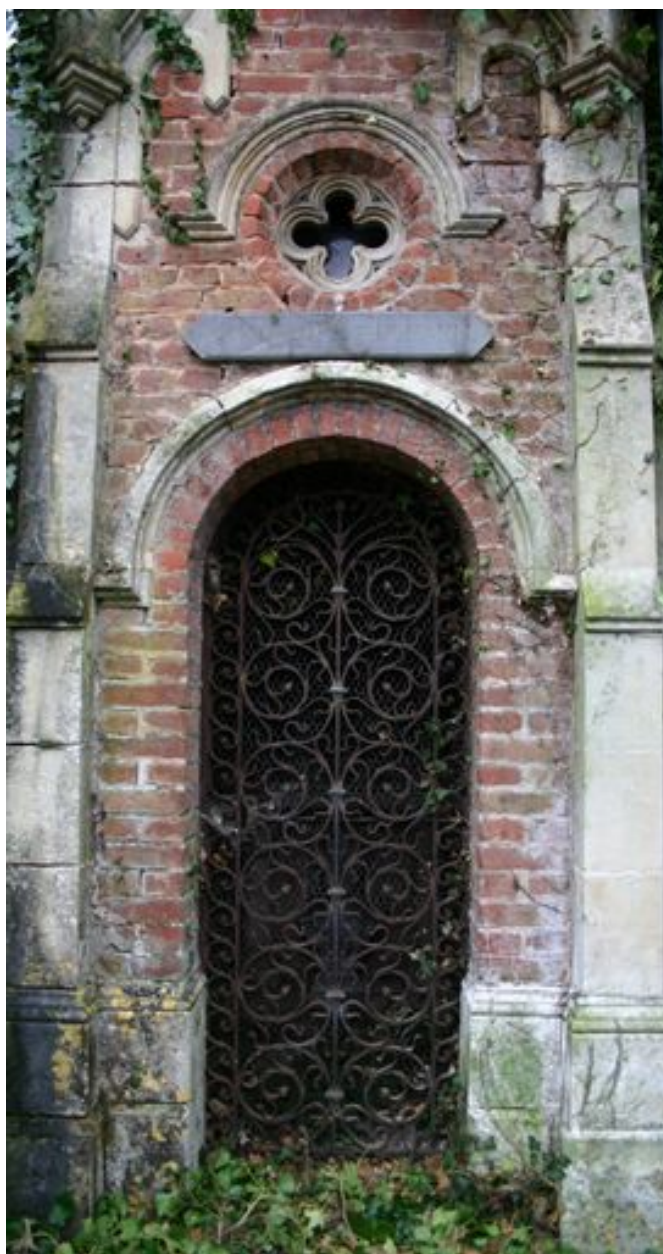
Détail de la façade principale, percée d'une porte cintrée en fonte et fer forgé.
