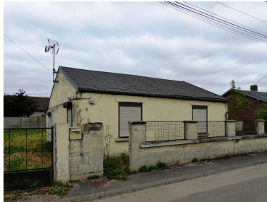
Maison, 5 rue Jules-Bonhomme. Phot. Isabelle Barbedor IVR32_20208005175NUCA
