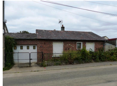
Maison, 9 rue Jules-Bonhomme. Phot. Isabelle Barbedor IVR32_20208005176NUCA
