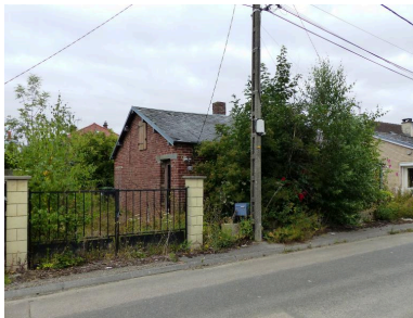
Maison, rue Jules-Bonhomme. Phot. Isabelle Barbedor IVR32_20208005177NUCA
