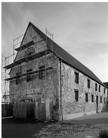
Le pignon de l'ancienne chapelle, en cours de travaux. Phot. Thierry Lefébure IVR22_19930201916V
