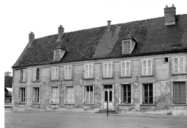
Élévation est et vue des bâtiments conventuels. Phot. Martine Plouvier IVR22_19880201798Z
