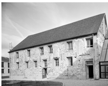
La face occidentale de l'ancienne chapelle, en cours de travaux. Phot. Thierry Lefébure IVR22_19930201914V
