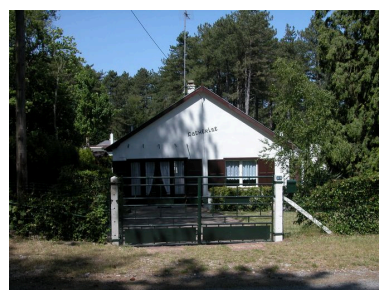
Maison dite Catherine (37 avenue des Sapins, AD 202). Phot. Elisabeth Justome IVR22_20058004002NUCA
