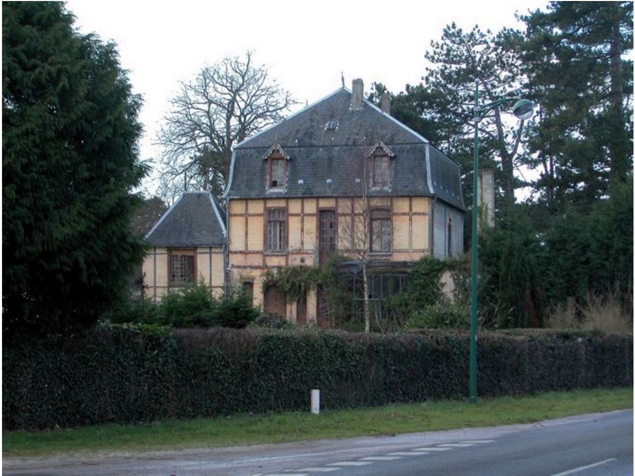
Les Dunettes, construite vers 1905 pour Paul Delegrange, route de la Plage (AE 123).
