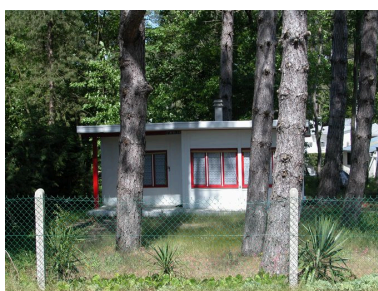
Maison dite Esméralda (9 avenue des Sapinettes, AD 31). Phot. Elisabeth Justome IVR22_20058004006NUCA
