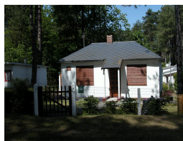
Maison dite Villa Jeannette (35 avenue des Sapins, AD 32). Phot. Elisabeth Justome IVR22_20058004005NUCA
