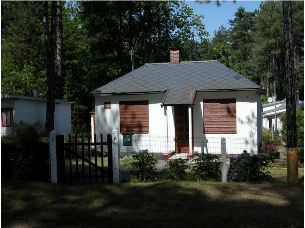
Maison dite Villa Jeannette (35 avenue des Sapins, AD 32).
