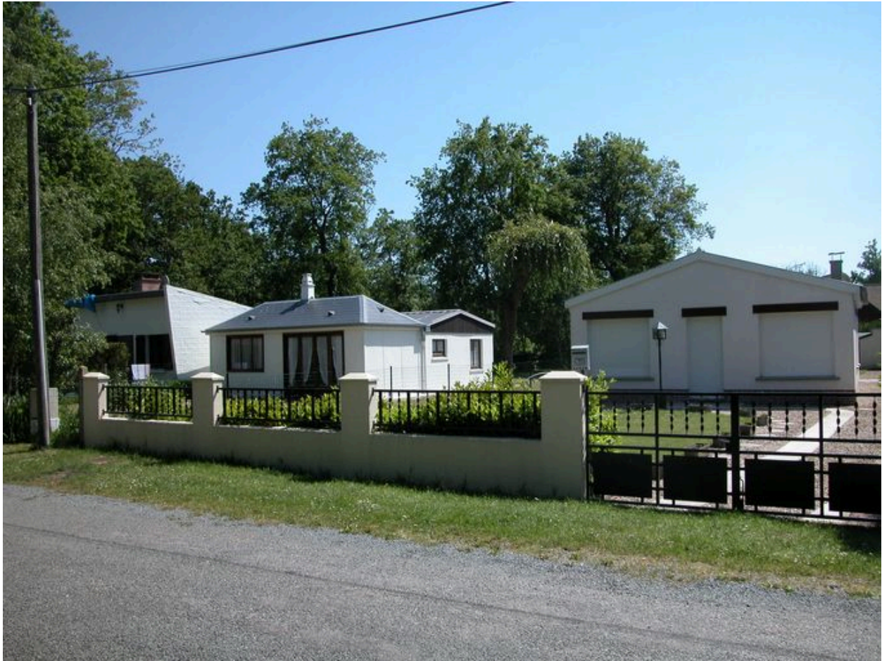
Maisons (50, 52, 54 avenue des Sapins, AE 47, 48, 49).
