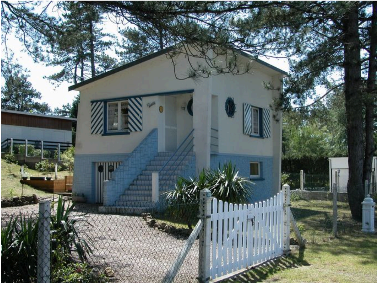
Maison dite Cisca (20 avenue des Chênes, AD 58).
