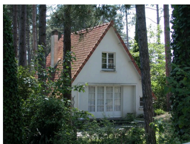
Maison dite la Nichette (38 avenue des Sapins, AD 38) construite vers 1962 pour Joseph Louvieux-Dehon, entrepreneur à la Bassée (Nord). Phot. Elisabeth Justome IVR22_20058003998NUCA
