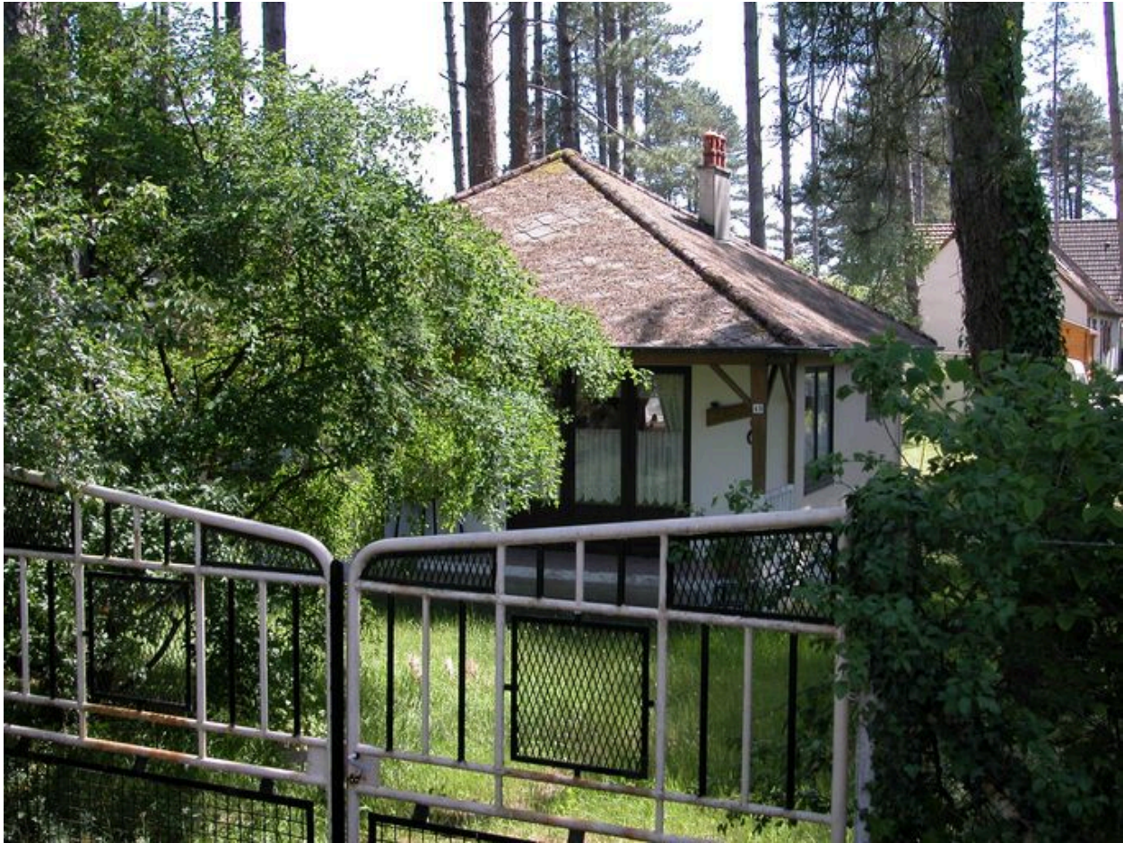
Maison dite Rokérou, 40 avenue des Sapins.
