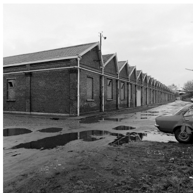
Atelier de fabrication, élévation sur cour. Phot. Olivier Marlard IVR31_19885902280X
