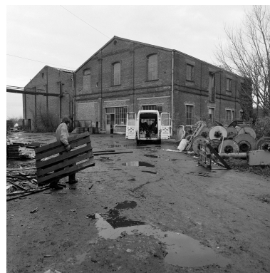
Ancienne chaufferie. Phot. Olivier Marlard IVR31_19885902282X
