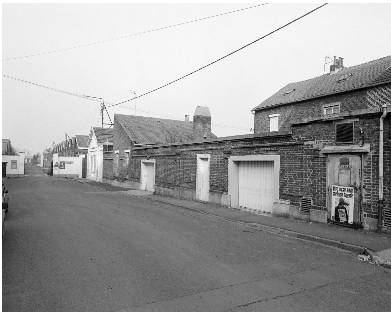
Atelier de fabrication, élévation rue d'Écosse.
