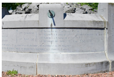
Vue de détail du panneau latéral 8 - première partie (numérotation depuis le panneau central avant dans le sens des aiguilles d'une montre). Le nom de l'entrepreneur Bouchez-Berur est gravé sur le poteau de droite. Phot. Delphine Volto-Jourdan IVR32_20216200648NUCA
