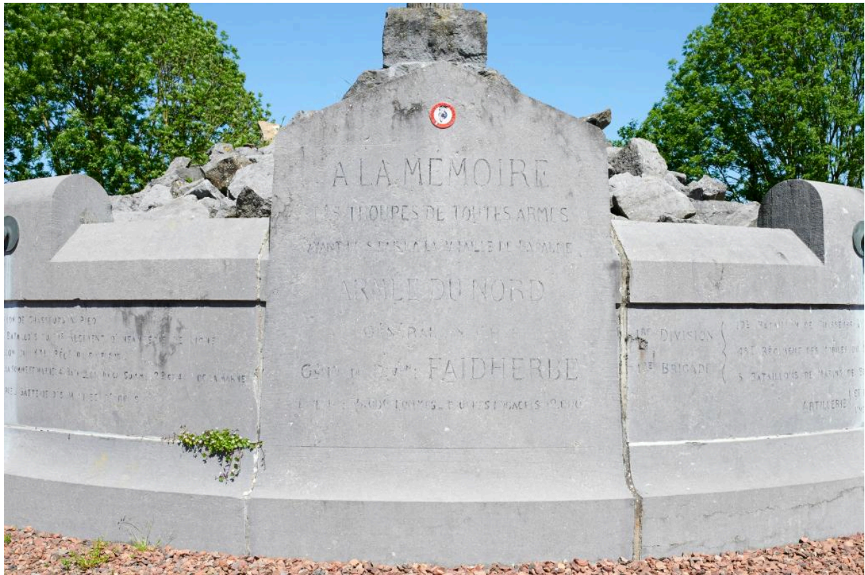
Vue de détail du panneau central avant.
