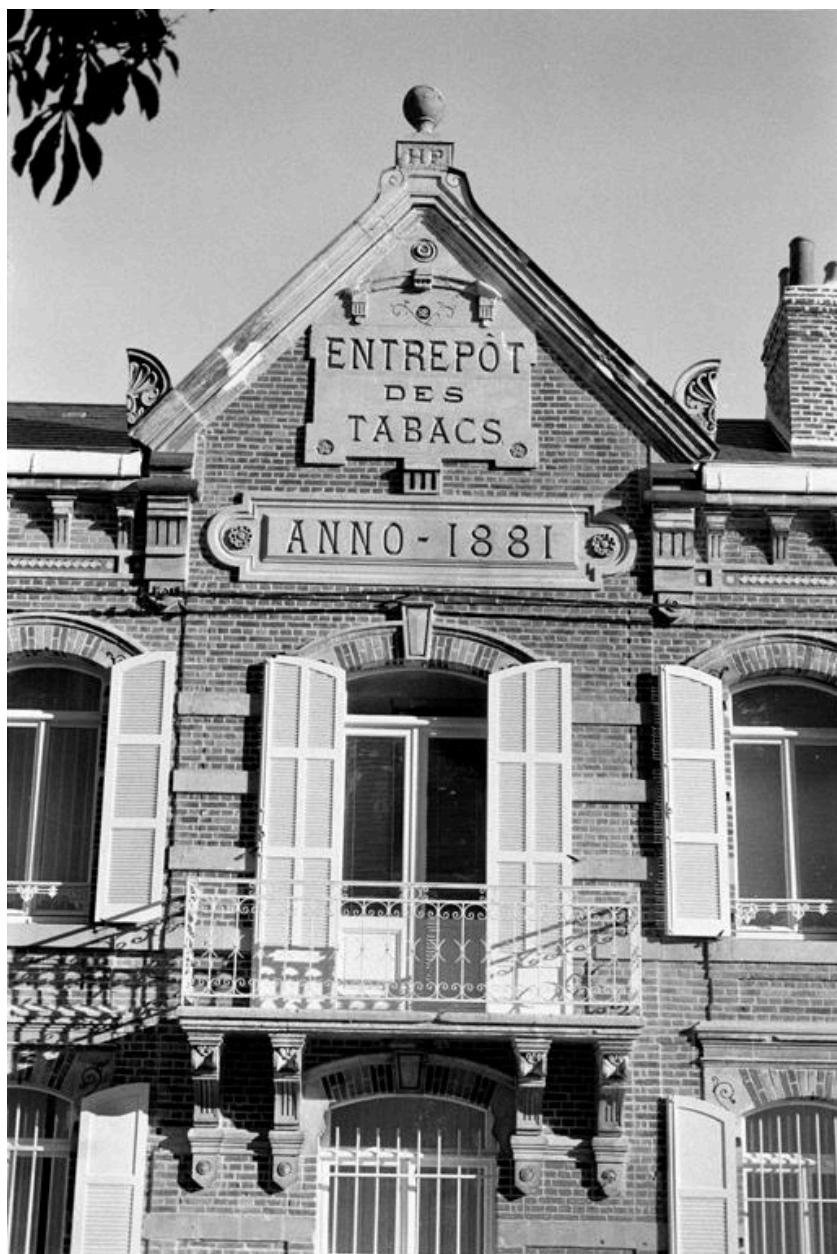
Vue du fronton de la façade principale.
