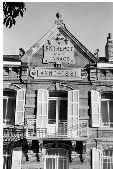
Vue du fronton de la façade principale. Phot. Pierre-Yves Brest IVR22_19990202126Z
