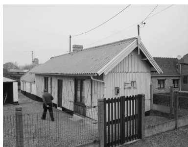
Vue générale de la maison en bois. Phot. Philippe Dapvril IVR31_20045900039X
