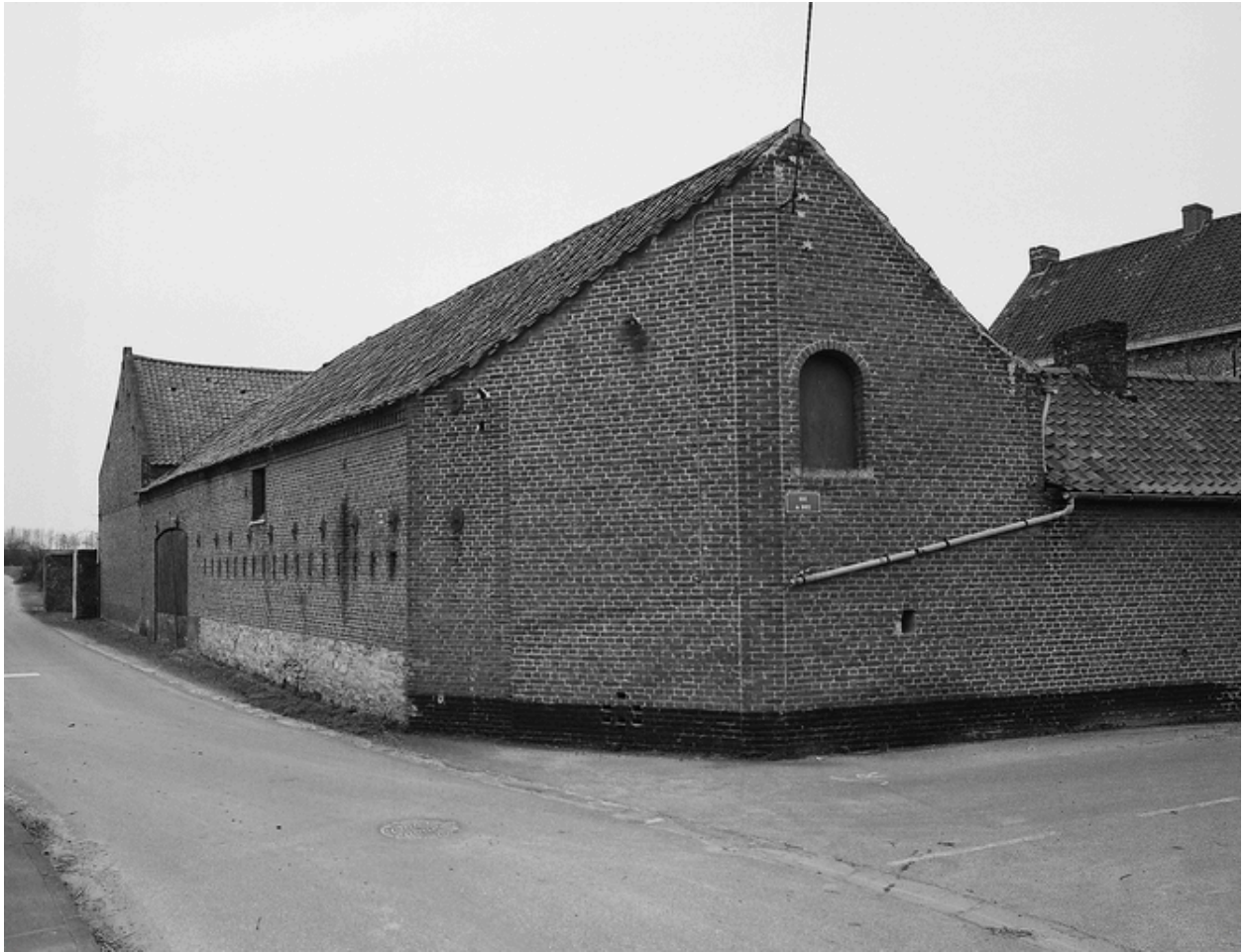
Ferme à cour ouverte, 80, rue du Bois, les communs et la grange.
