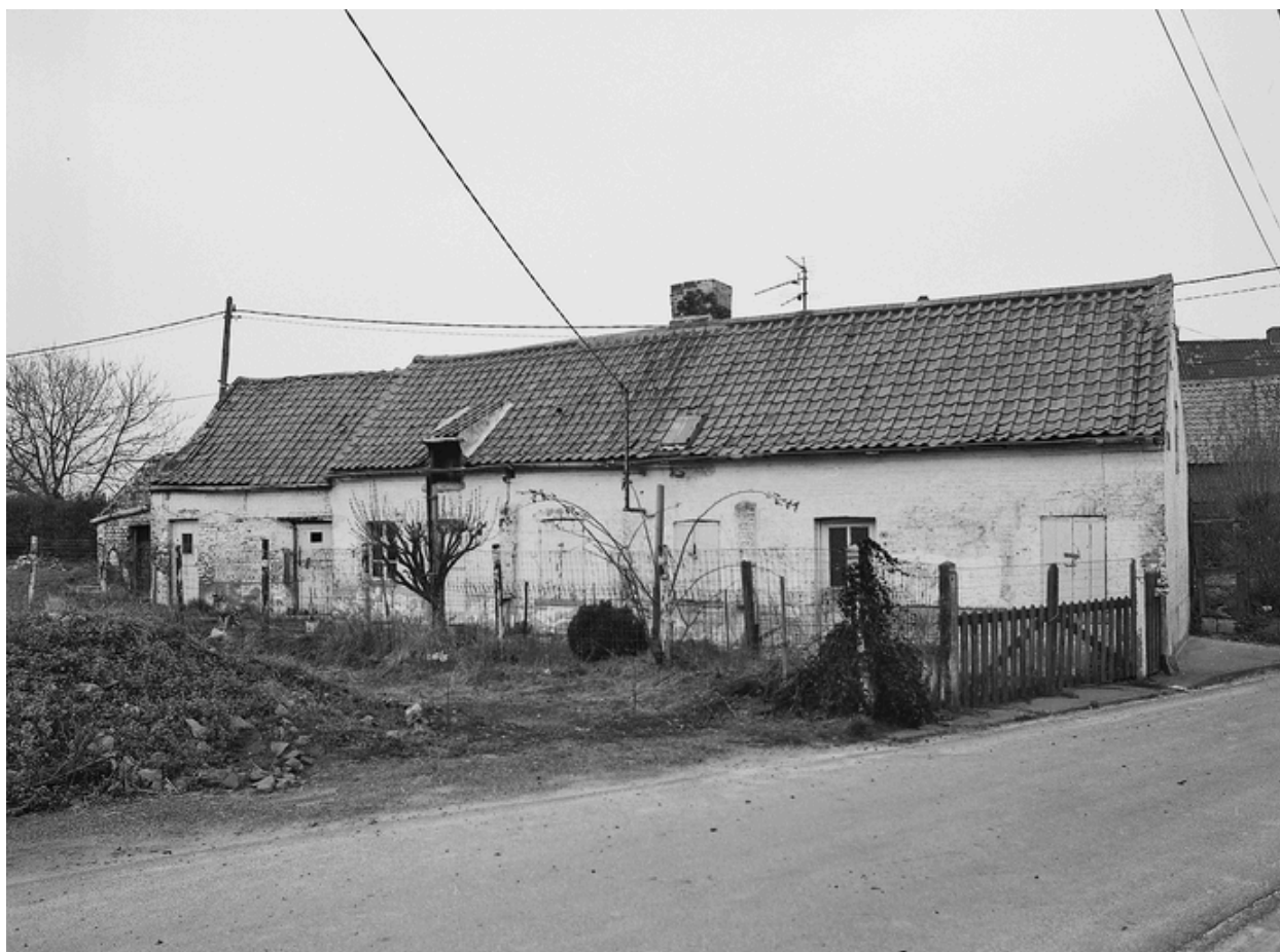
Ferme élémentaire, 12, rue du Fort.
