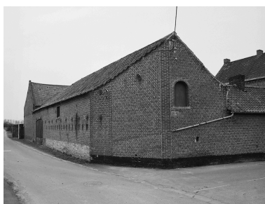
Ferme à cour ouverte, 80, rue du Bois, les communs et la grange. Phot. Philippe Dapvril IVR31_20045900024X
