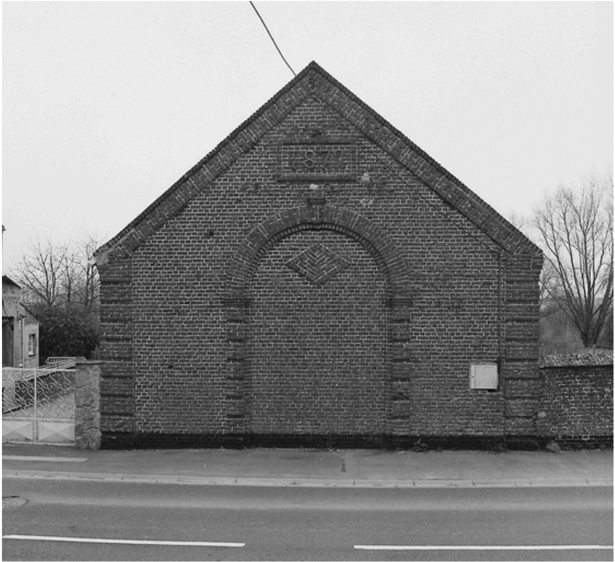
Le pignon de la grange située 869 Grand'Rue.
