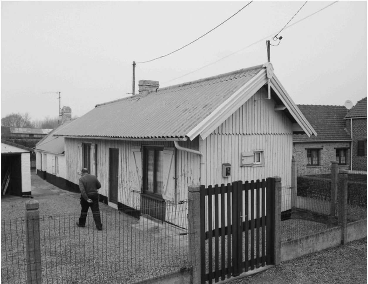
Vue générale de la maison en bois.
