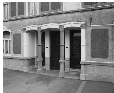
Le porche de la maison, 40-32, rue du Pont. Phot. Philippe Dapvril IVR31_20045900016X
