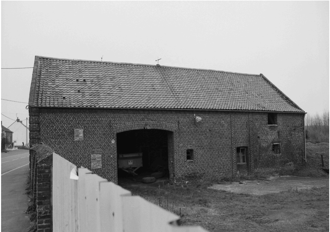
Vue générale de la grange située 869 Grand'Rue.
