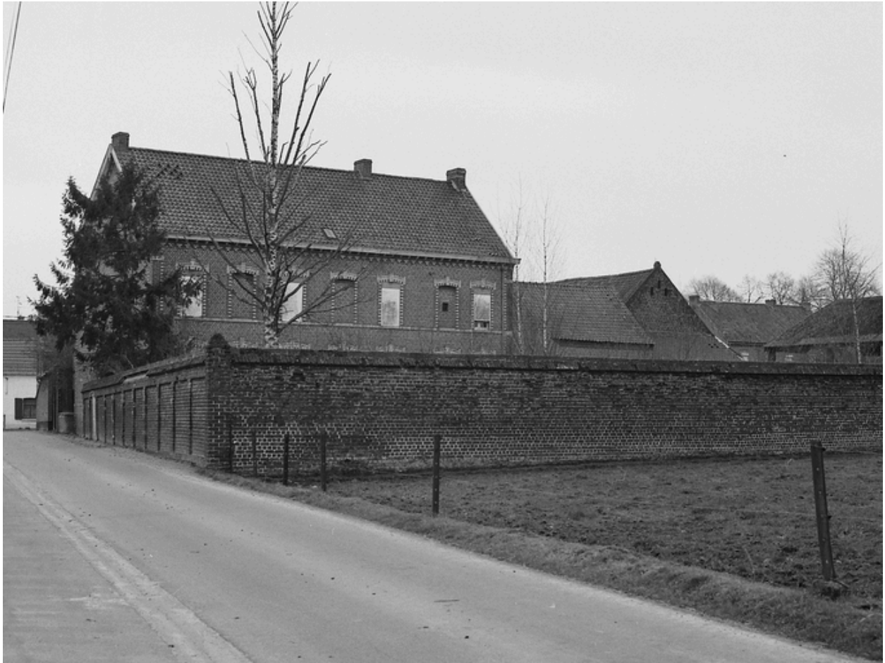
Ferme à cour ouverte, 80, rue du Bois, vue générale depuis le mur de cloture et l'arrière du logis..
