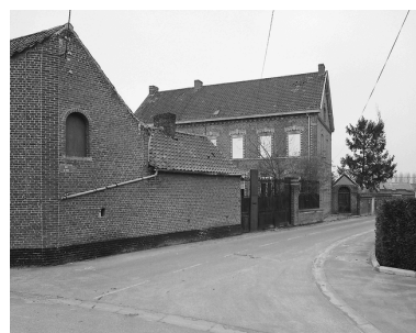
Ferme à cour ouverte, 80, rue du Bois, vue générale depuis la grange. Phot. Philippe Dapvril IVR31_20045900023X
