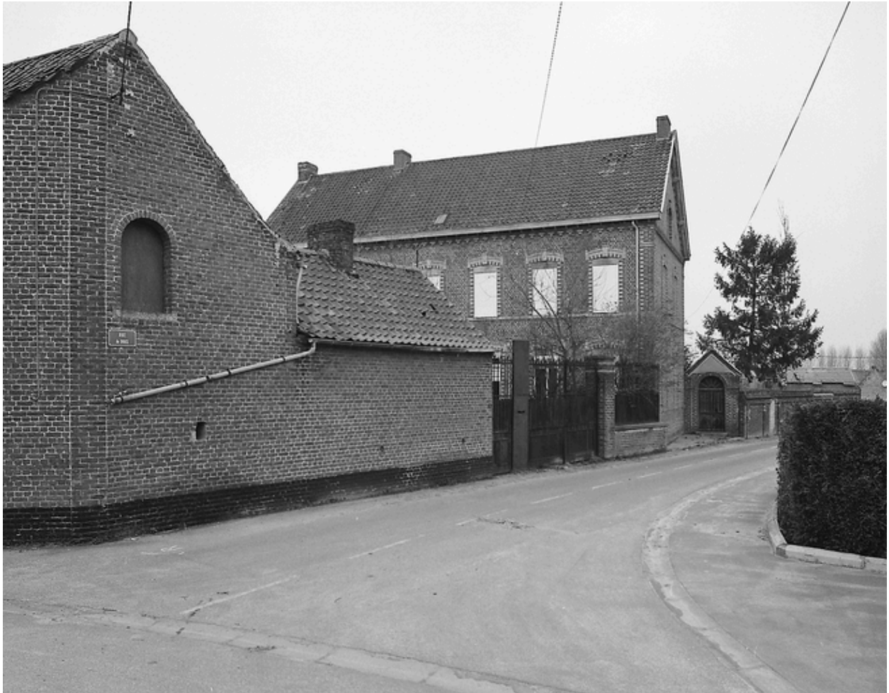
Ferme à cour ouverte, 80, rue du Bois, vue générale depuis la grange.
