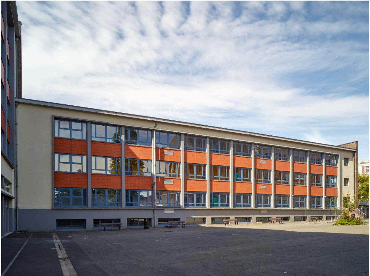
Bâtiment des sciences : façade sur la cour des élèves.
