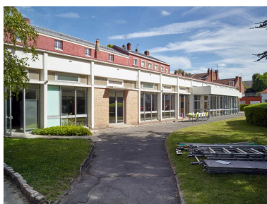
Vue du réfectoire depuis la cour des élèves, vue orientée sud-ouest - nord-est. Phot. Pierre Thibaut IVR32_20225900408NUCA
