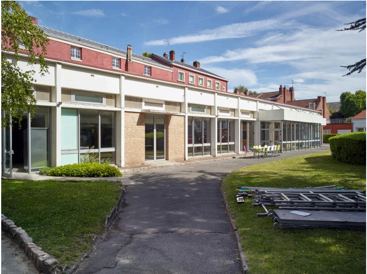
Vue du réfectoire depuis la cour des élèves, vue orientée sud-ouest - nord-est.
