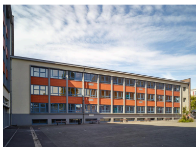
Bâtiment des sciences : façade sur la cour des élèves. Phot. Pierre Thibaut IVR32_20225900413NUCA
