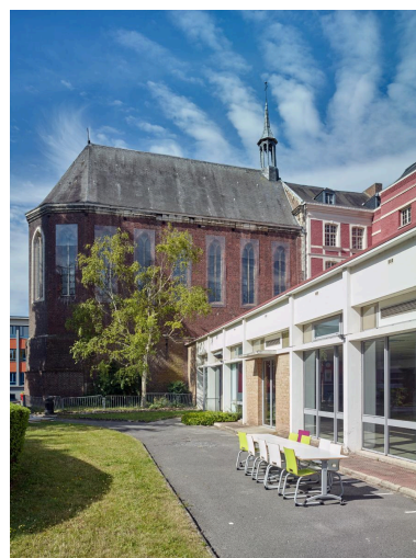
Vue du réfectoire depuis la cour des élèves, vue orientée nord-est - sud- ouest avec la chapelle à l'arrière plan. Phot. Pierre Thibaut IVR32_20225900409NUCA
