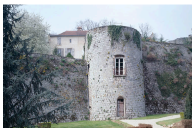
La tour Henriot, depuis la rue du faubourg de La Barre.
