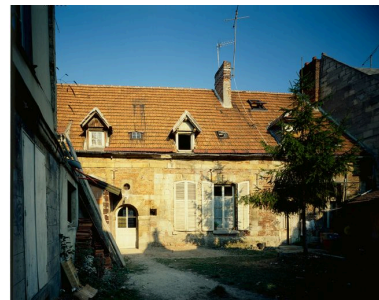
Elévation postérieure. Phot. Fabrice Charrondière IVR22_19856001428VA
